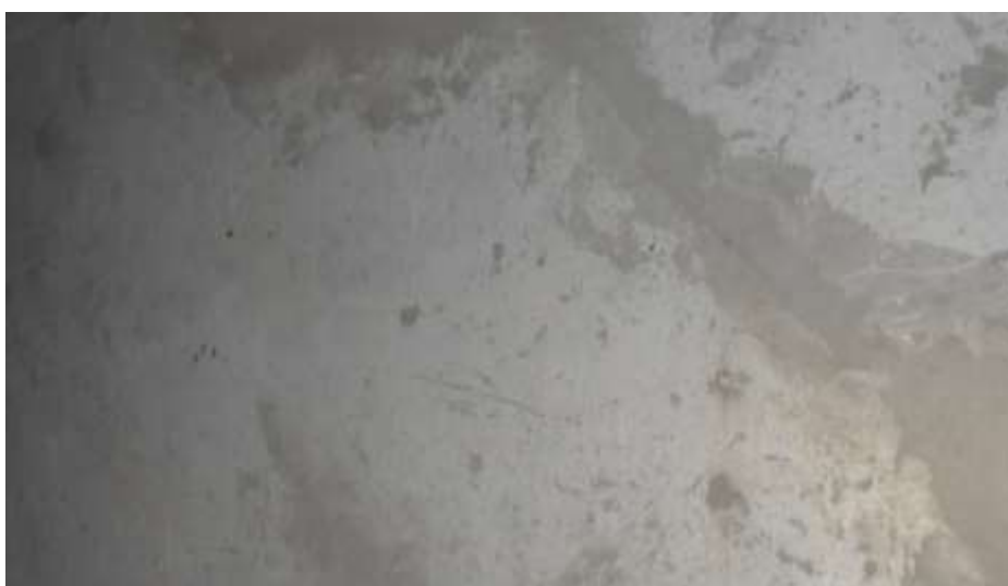
Fot. 161. Fragment ściany zewnętrznej: ściana tynkowana i malowana; tynk skorodowany; złuszczenia lica tynku;
