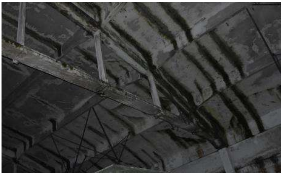
Fot. 216. Fragment dźwigara w osi IV-IV: od strony północnej z zaciekami; na powierzchni rozwój kolonii glonów;
