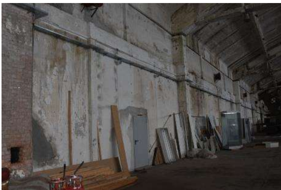
Fot. 34. Fragment ściany zewnętrznej: ściana o konstrukcji szkieletowej; przy ścianie 5 słupów podpierających dźwigary dachowe;
