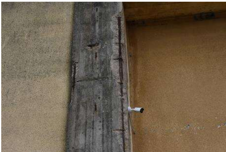
Fot. 391: Fragment elewacji południowej: słup narożny od strony zachodniej z rozległym brakiem otuliny w górnej części;
