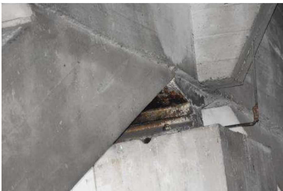
Fot. 13. Fragment ściany zewnętrznej: pas górny kratownicy połączony przegubowo na słupie; łożysko metalowe;
