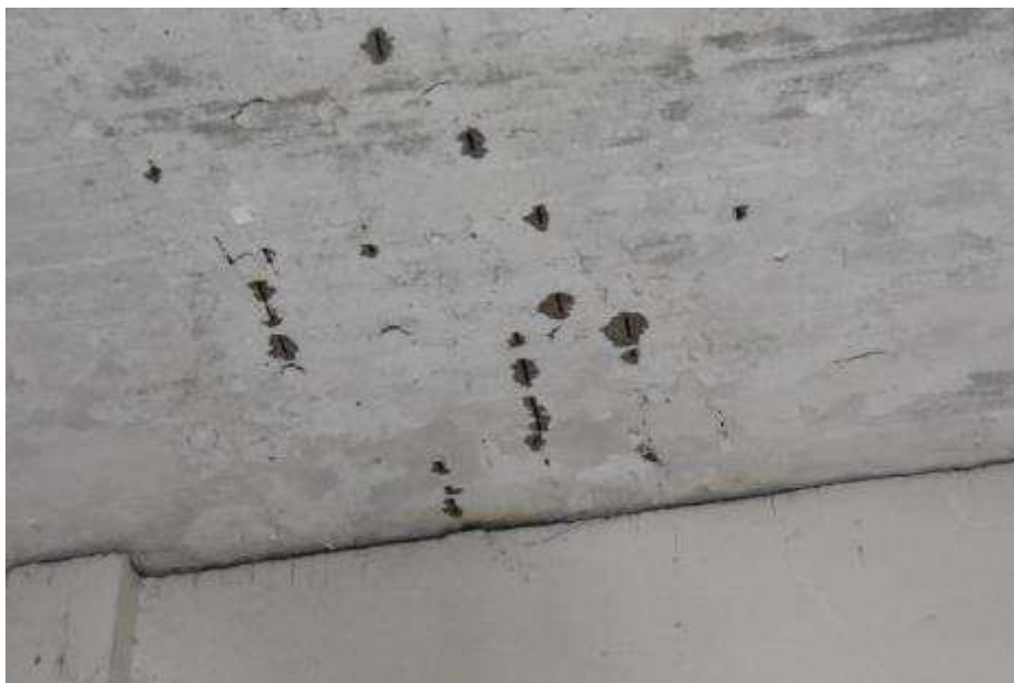
Fot. 238. Fragment stropodachu nad parterem: w pomieszczeniu garażu nr G8 na suficie lokalnie ubytki otuliny prętów; odsłonięte zbrojenie powierzchniowo skorodowane;
