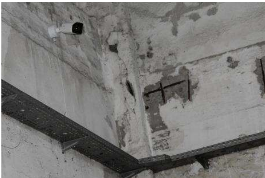
Fot. 90. Fragment ściany zewnętrznej: w narożniku odsłonięte zbrojenie belki żelbetowej;
