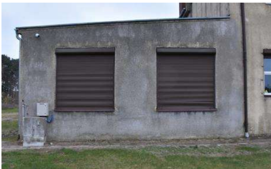
Fot. 294: Fragment elewacji zachodniej: ściana murowana z cegły ceramicznej; tynkowana; warstwa zewnętrzna tzw. „baranek”; w ścianie 2 otwory okienne;
