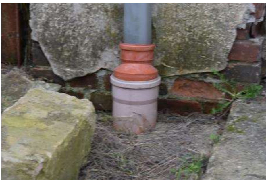
Fot. 268. Fragment elewacji północnej: od filara piętnastego do narożnika północno-wschodniego woda opadowa odprowadzona do kanalizacji;
