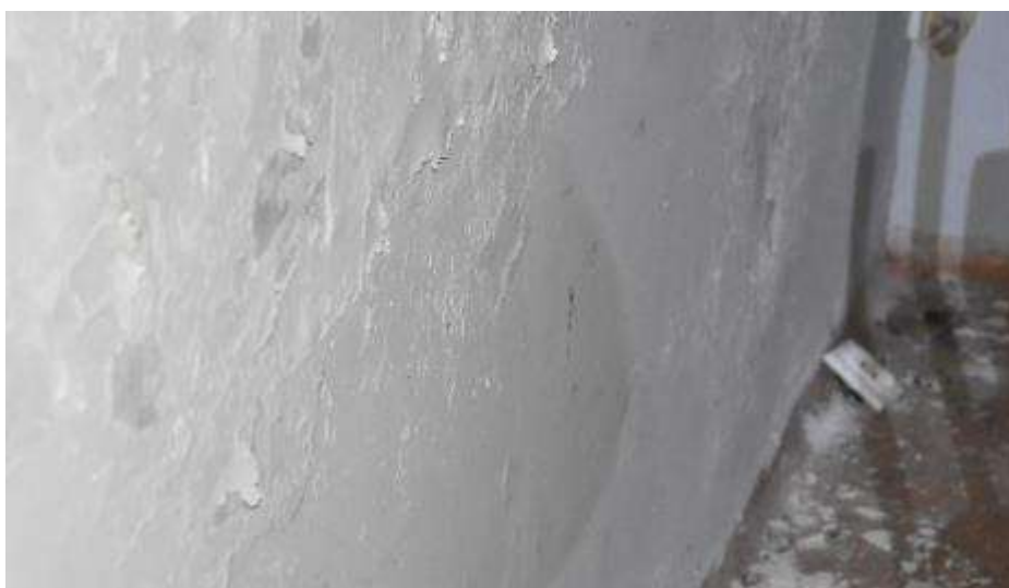
Fot. 104. Fragment ściany zewnętrznej: zawilgocenie w pasie podokiennym; złuszczenia warstw malarskich i lica tynku; fragmenty zalegają na posadzce
