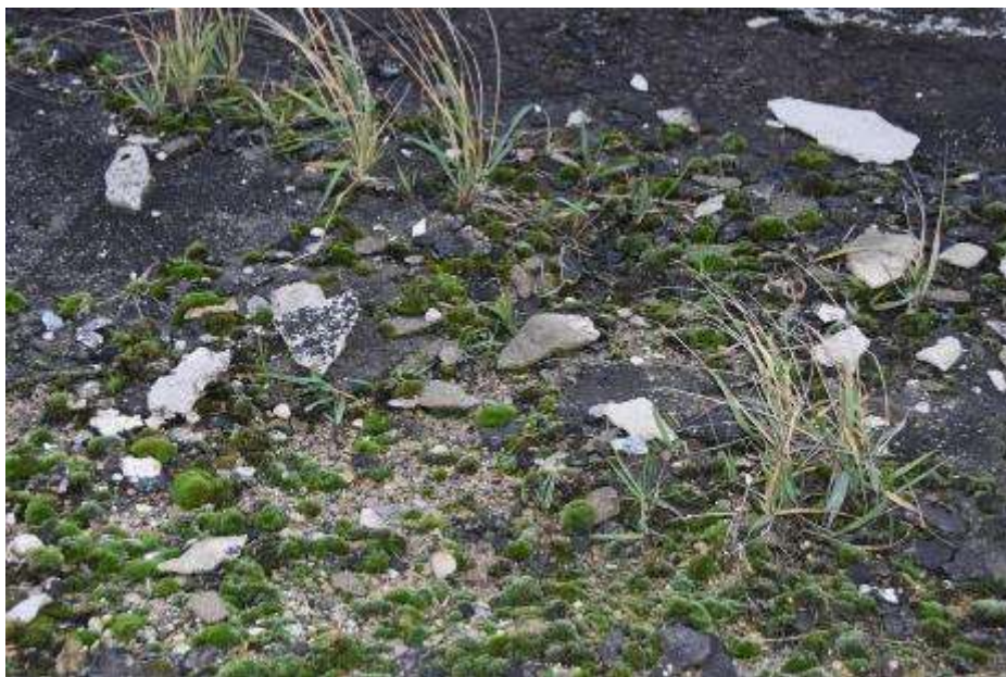
Fot. 249. Fragment dachu nad hangarem: odsłonięta powierzchnia betonowa skorodowana; rozluźniona; we fragmentach rozwój roślin trawiastych;
