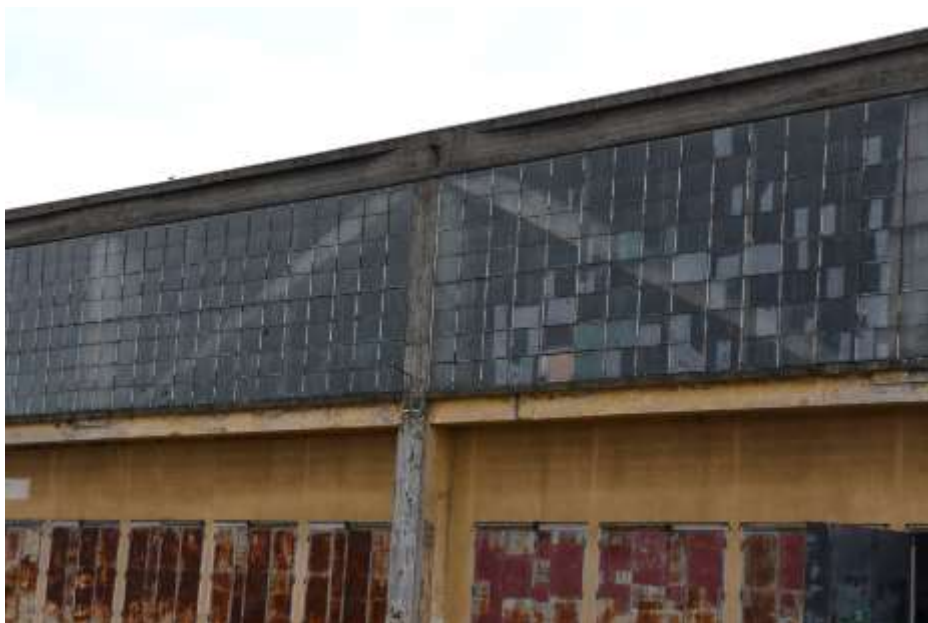
Fot. 390: Fragment elewacji południowej: za elewacją szklaną widoczna kratownica żelbetowa; - słup narożny od strony zachodniej z rozległym brakiem otuliny w górnej części;
