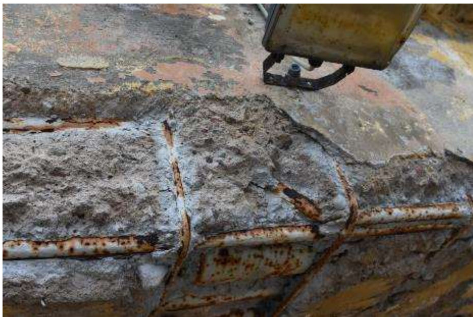
Fot. 411: Fragment elewacji południowej: strzemiona z prętów Ø10 mm w rozstawie co 25-35 cm;
