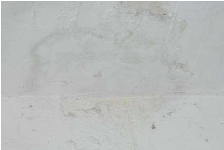
Fot. 167. Fragment stropu nad parterem: na powierzchni zacieki;
