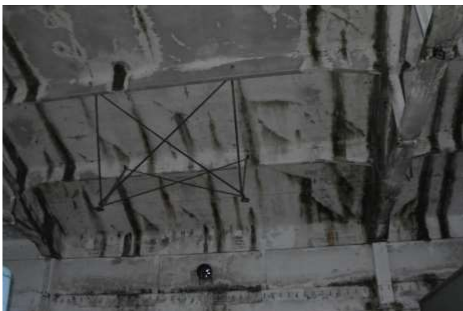
Fot. 230. Fragment płyty dachowej: rozległe zacieki od strony północnej; na powierzchni płyty oraz na płatwiach rozwój kolonii glonów;
