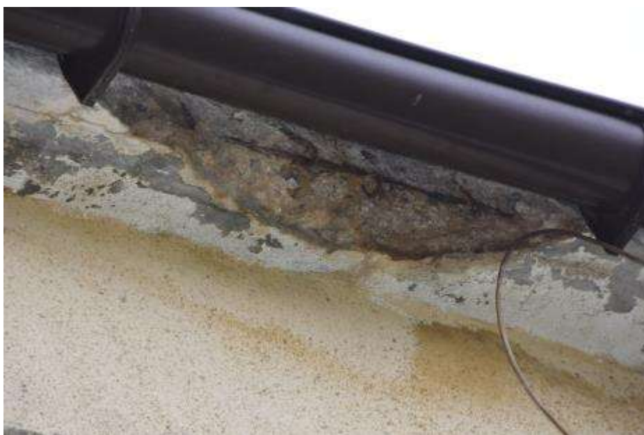
Fot. 288: Fragment elewacji zachodniej: ściana zwieńczona prostym wysuniętym gzymsem; lokalnie ubytki betonu; odsłonięte zbrojenie skorodowane;
