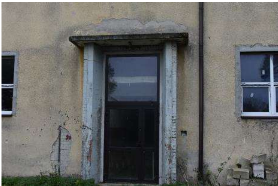
Fot. 343: Fragment elewacji wschodniej: otwór drzwiowy z portalem wejściowym murowanym z cegły ceramicznej; cegła malowana;
