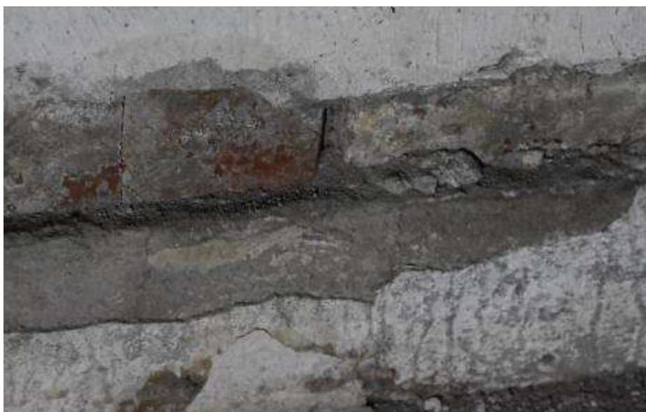
Fot. 122. Fragment ściany zewnętrznej: lokalnie ubytki tynku; odsłonięta cegła powierzchniowo skorodowana;
