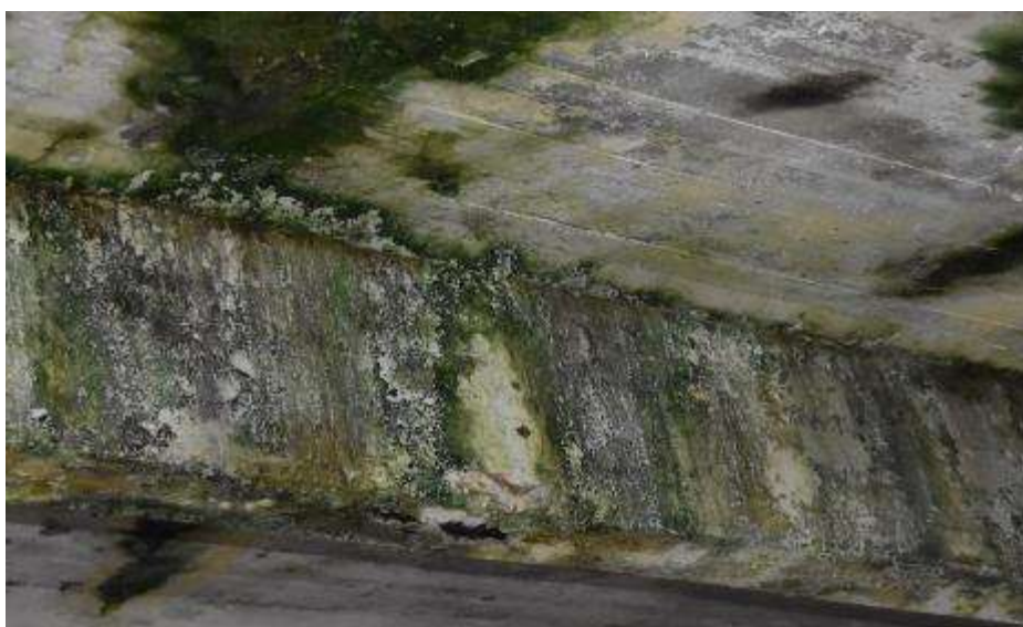
Fot. 225. Fragment płyty dachowej: rozległy zaciek przy dźwigarze w osi V-V; na powierzchni płyty rozwój kolonii glonów;
