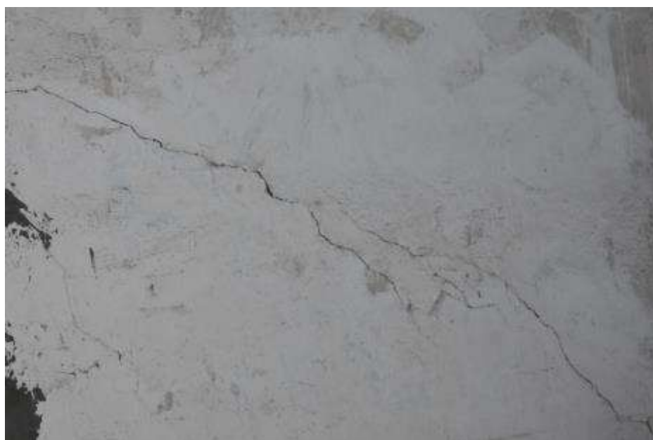
Fot. 65. Fragment ściany zewnętrznej: rysy o rozwarciu do 2 mm;
