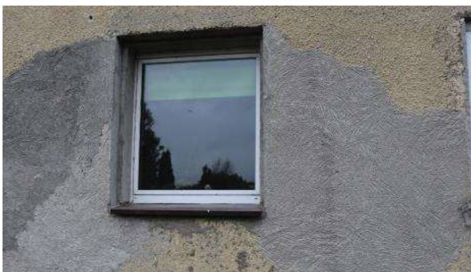
Fot. 358: Fragment elewacji wschodniej: ślady napraw; uzupełnienia wyprawy tynkarskiej;
