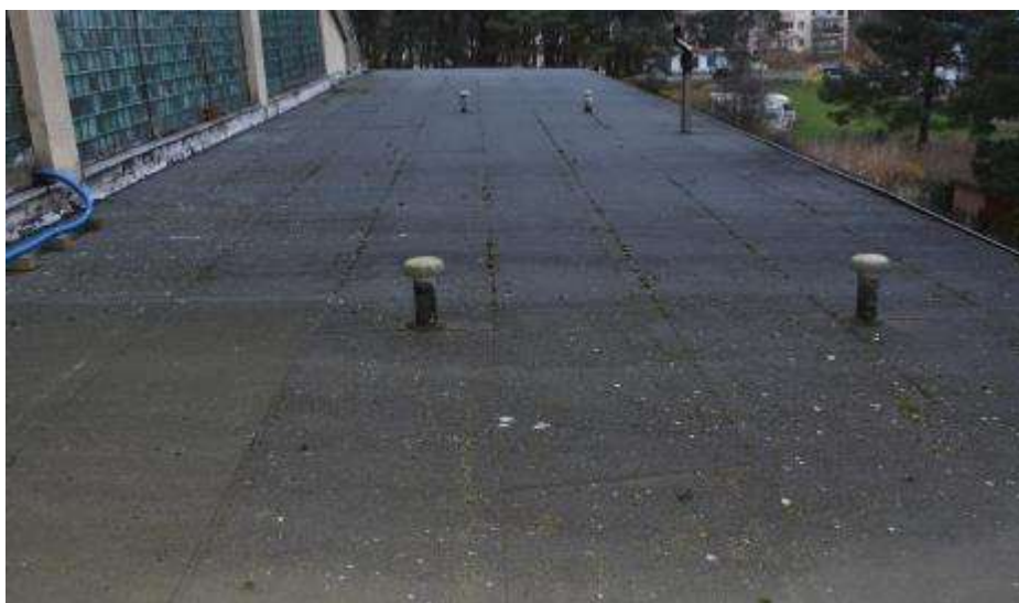
Fot. 256. Fragment pokrycia budynku „E”: pokrycie z papy termozgrzewalnej; na złączach wegetacja mchów;
