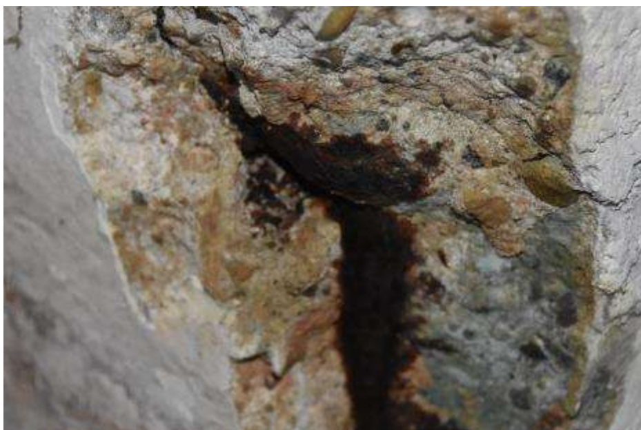
Fot. 52. Fragment ściany zewnętrznej: po odsłonięciu zbrojenia i przeprowadzaniu badania kontrolnego stwierdzono brak ochrony betonu przed korozją;
