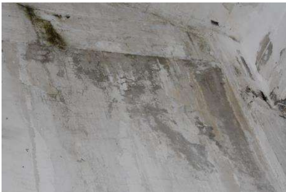
Fot. 28. Fragment ściany zewnętrznej: rozległy zaciek w górnej części ściany w narożniku północno-zachodnim;
