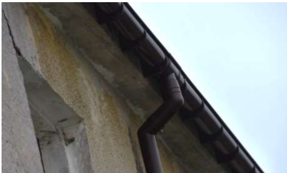
Fot. 269. Fragment elewacji wschodniej: rynny i rury spustowe z PCV;
