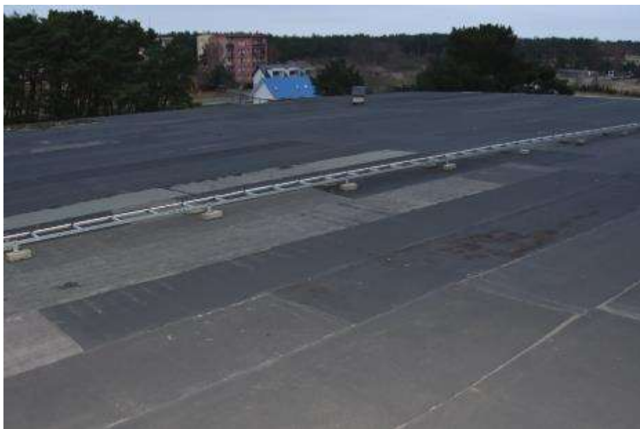
Fot. 247. Fragment dachu nad hangarem: na połaci widoczne różne rodzaje papy;
