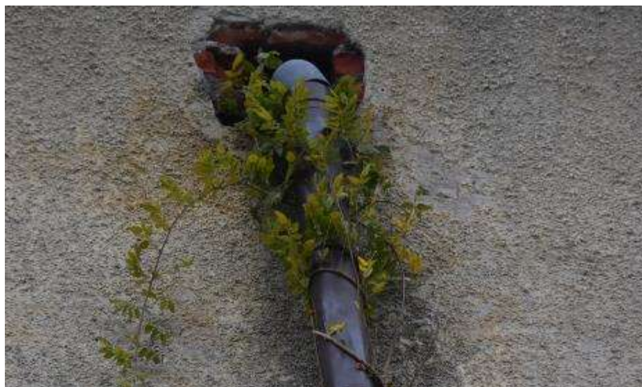
Fot. 270. Fragment elewacji południowej: rynny i rura spustowa z PCV;
