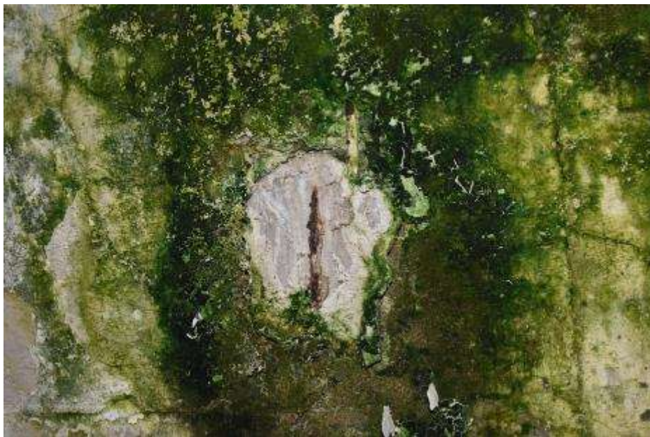
Fot. 75. Fragment ściany zewnętrznej: lokalnie brak otuliny prętów;
