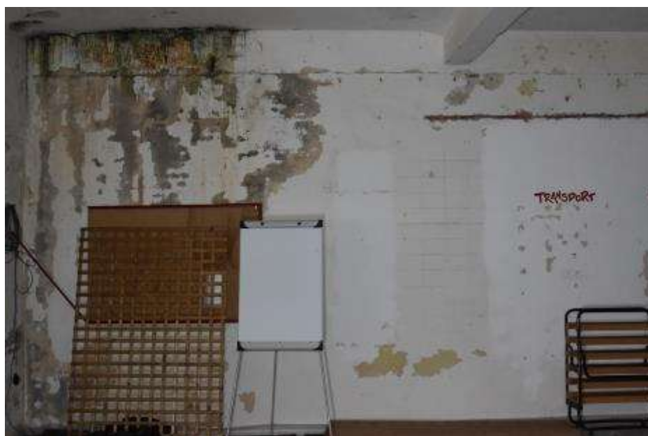
Fot. 32. Fragment ściany wewnętrznej: w pomieszczeniu nr 20 ściana silnie zawilgocona w narożniku przy osi 5-5; złuszczenia warstw tynkarskich; - belka żelbetowa zawilgocona; beton skorodowany; na powierzchni rozwój glonów i grzybów pleśniowych;
