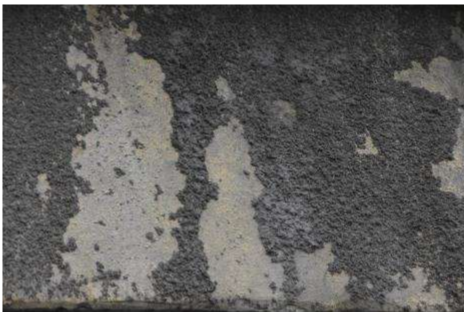
Fot. 306: Fragment elewacji północnej: liczne złuszczenia warstwy zewnętrznej tynku;
