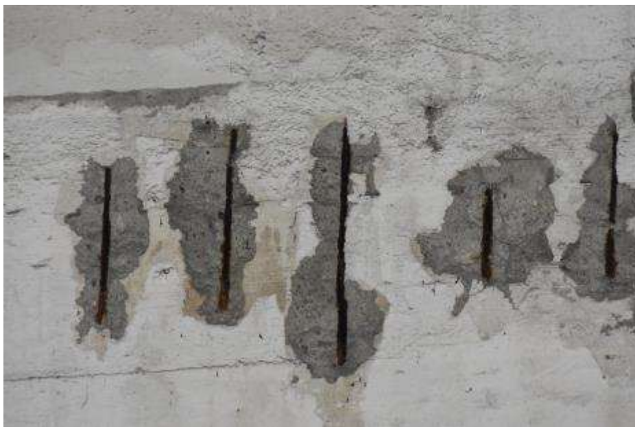
Fot. 91. Fragment ściany zewnętrznej: odspojona otulina strzemion; odsłonięte zbrojenie powierzchniowo skorodowane;
