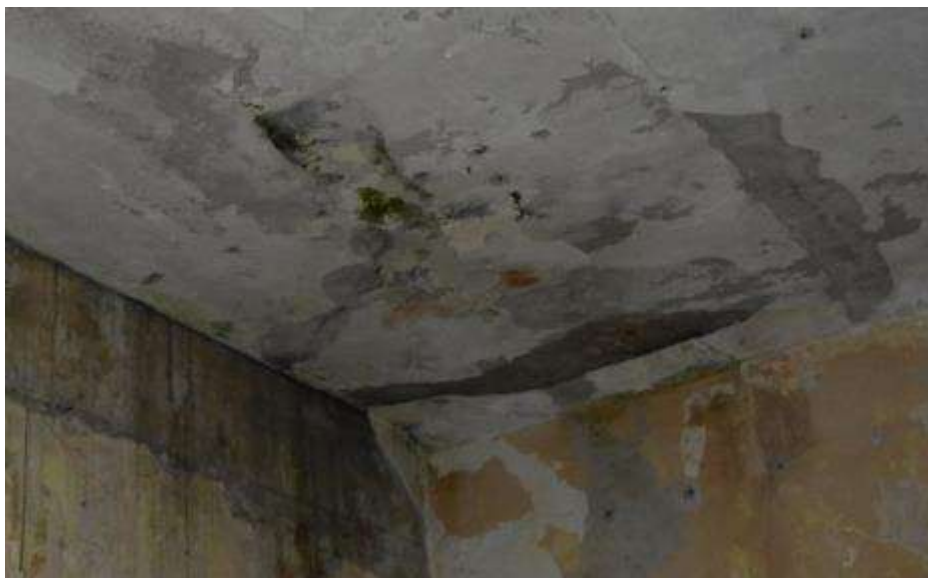
Fot. 242. Fragment stropodachu nad I piętrem: rozległy zaciek w narożniku ścian w osi C-C i 5-5; na suficie zawilgocenie; korozja tynku; na powierzchni rozwój kolonii glonów oraz grzybów pleśniowych;
