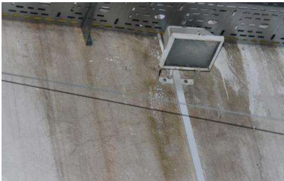
Fot. 45. Fragment ściany zewnętrznej: ciemne zacieki w górnej części ściany;
