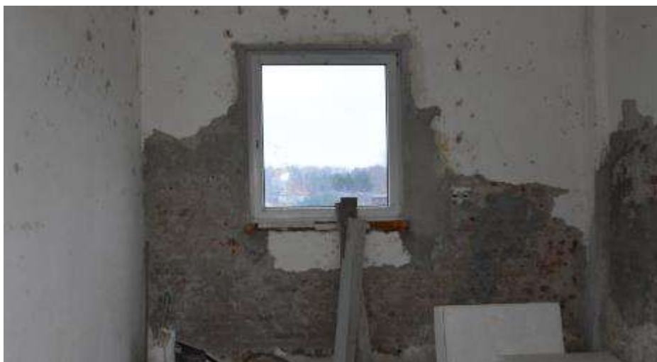
Fot. 151. Fragment ściany zewnętrznej: rozległe ubytki tynku; odsłonięta cegła powierzchniowo skorodowana; w ścianie otwór okienny;
