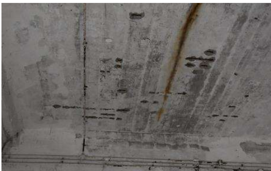
Fot. 237. Fragment stropodachu nad parterem: w pomieszczeniu garażu nr G7 na suficie lokalnie ubytki otuliny prętów; odsłonięte zbrojenie powierzchniowo skorodowane; rdzawe naloty wzdłuż rysy;
