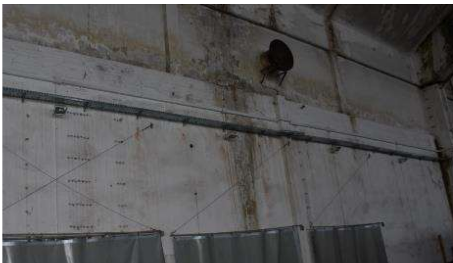
Fot. 47. Fragment ściany zewnętrznej: ściana wypełniająca murowana z cegły ceramicznej; tynkowana; przy ścianie pilaster żelbetowy o szerokości 26 cm;
