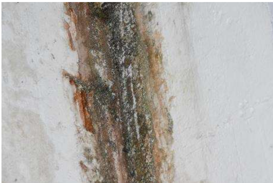
Fot. 50. Fragment ściany zewnętrznej: przy słupie w osi III brunatne zacieki; na powierzchni wegetacja glonów;
