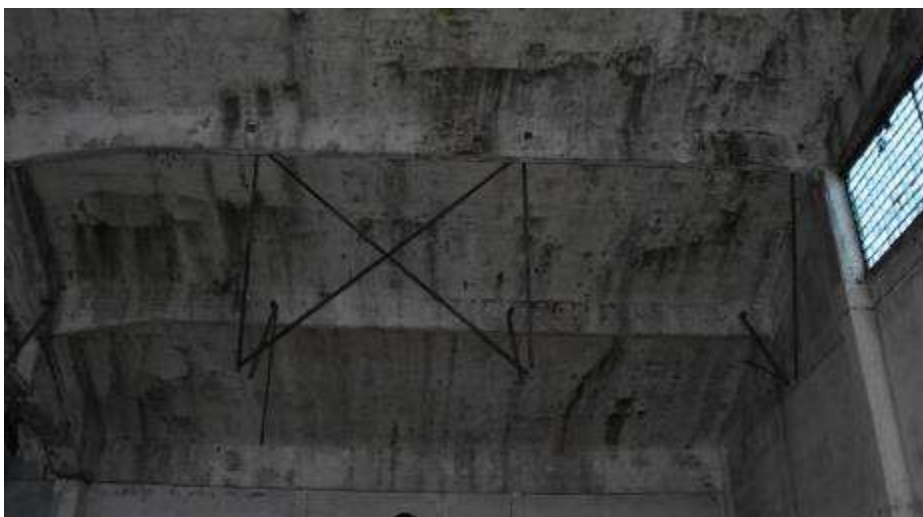
Fot. 222. Fragment płyty dachowej: płyta dachowa żelbetowa; oparta na płatwiach; ślady zacieków od strony północnej;
