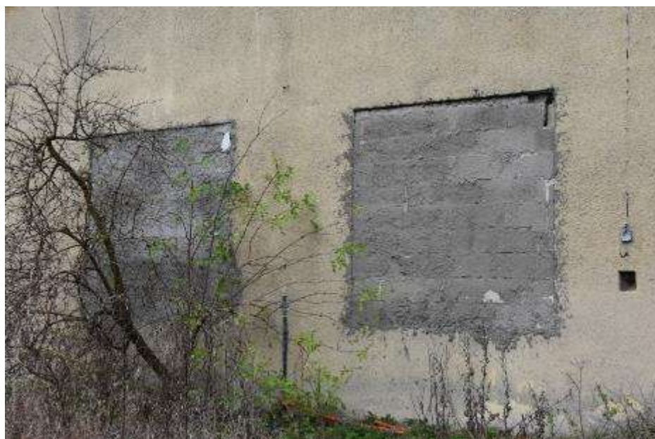
Fot. 338: Fragment elewacji wschodniej: otwory okienne od strony północnej zamurowane bloczkami gazobetonowymi;
