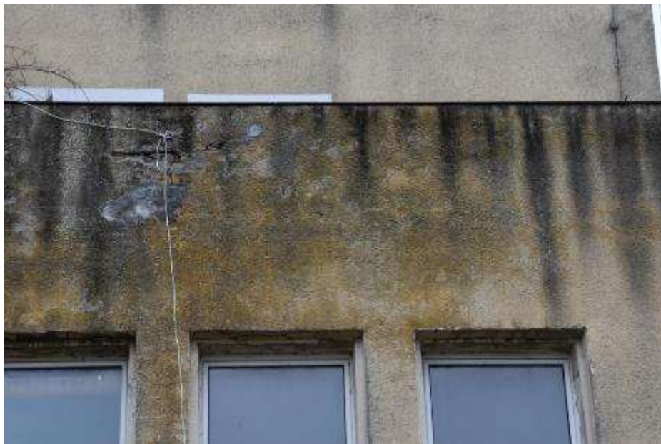
Fot. 375: Fragment elewacji południowej: ponad otworami okiennymi rozległe zacieki; na powierzchni ciemne naloty; rozwój kolonii glonów;
