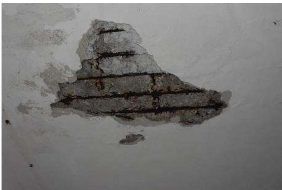
Fot. 180. Fragment stropu nad II piętrem: lokalnie brak otuliny prętów; odsłonięte zbrojenie powierzchniowo skorodowane;
