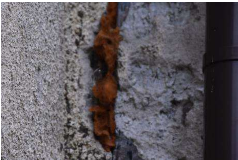
Fot. 350: Fragment elewacji wschodniej: pomiędzy budynkami „D” i „E” dylatacja; szczelina wypełniona pianką;
