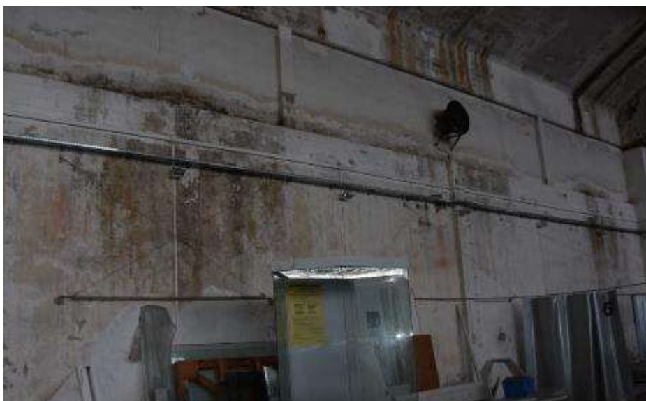
Fot. 40. Fragment ściany zewnętrznej: ściana wypełniająca murowana z cegły ceramicznej; tynkowana; przy ścianie pilaster żelbetowy o szerokości 26 cm;
