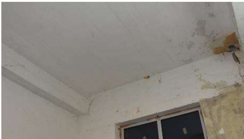
Fot. 175. Fragment stropu nad parterem: w pomieszczeniu nr 12 strop płytowo-żebrowy; malowany; lokalnie złuszczenia warstw malarskich;
