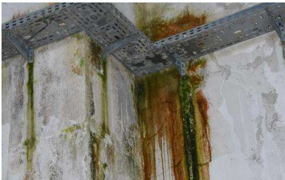
Fot. 66. Fragment ściany zewnętrznej: w narożniku słupa w osi IV i ściany wypełniającej rozległy brunatny zaciek; na powierzchni wegetacja kolonii glonów;
