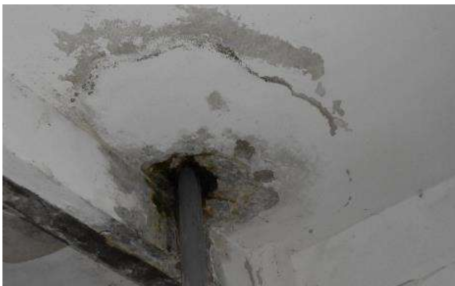
Fot. 243. Fragment stropodachu nad III piętrem: płyta żelbetowa; w rejonie rury instalacyjnej na suficie zacieki; w miejscu zawilgocenia korozja tynku; złuszczenia warstw zewnętrznych wypraw;
