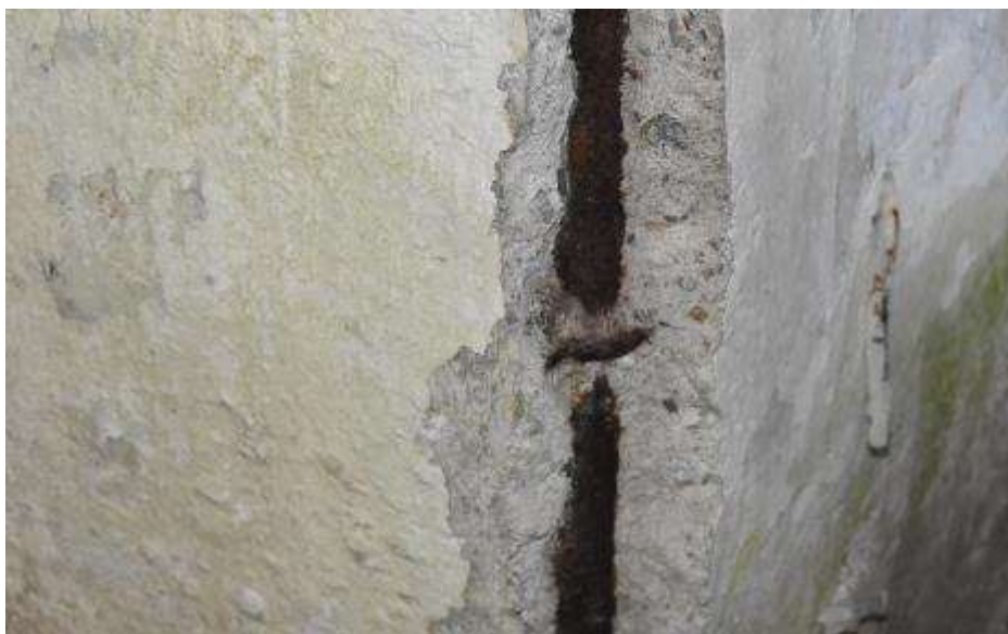
Fot. 61. Fragment ściany zewnętrznej: w dolnej części odspojona otulina pręta; zbrojenie powierzchniowo skorodowane;
