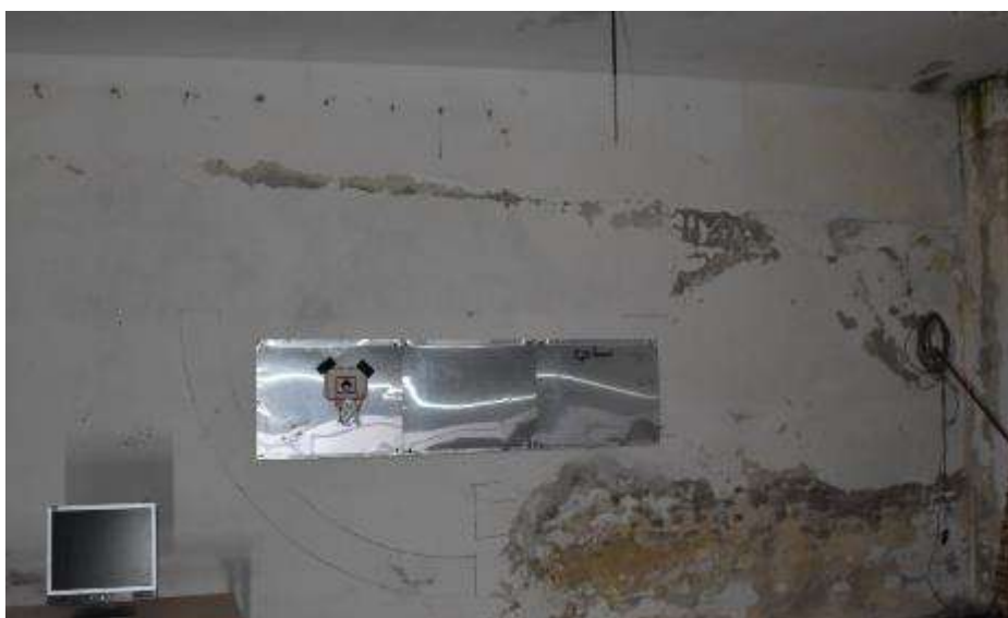
Fot. 115. Fragment ściany wewnętrznej: poziome pęknięcie pod belką żelbetową pod stropem;
