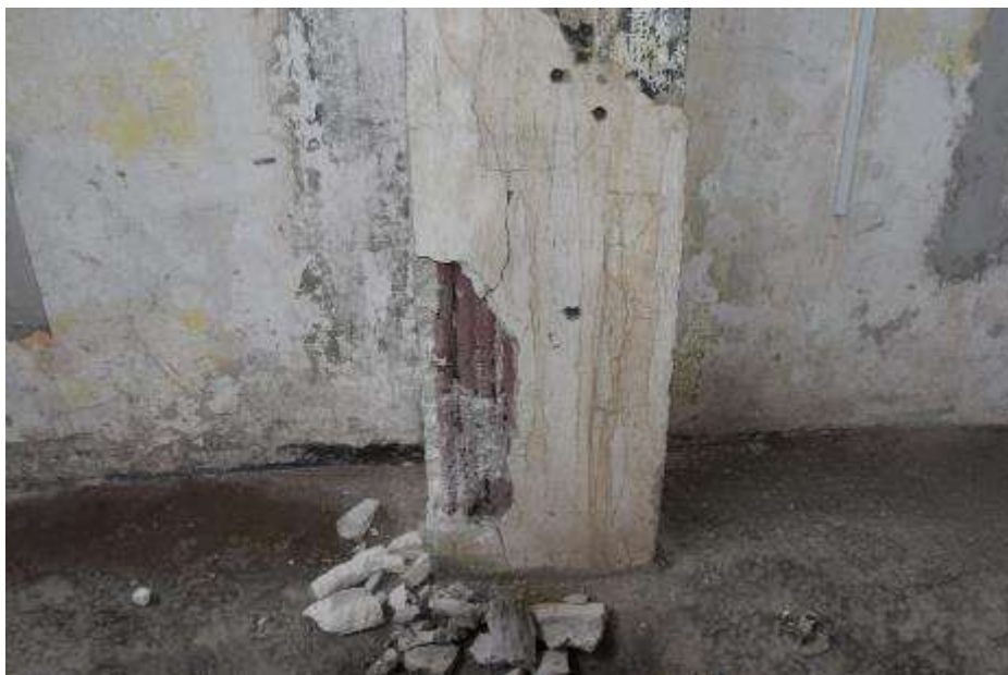
Fot. 18. Fragment ściany zewnętrznej: słup w osi pierwszej od południa (elewacji frontowej) ze śladami napraw w dolnej części;
