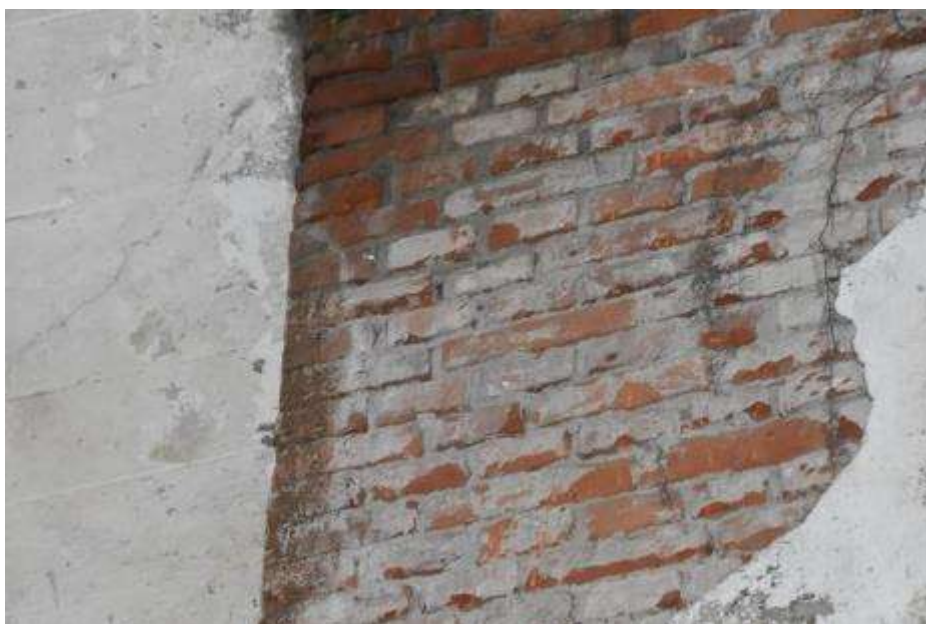
Fot. 194. Fragment komina: odsłonięta cegła powierzchniowo skorodowana;
