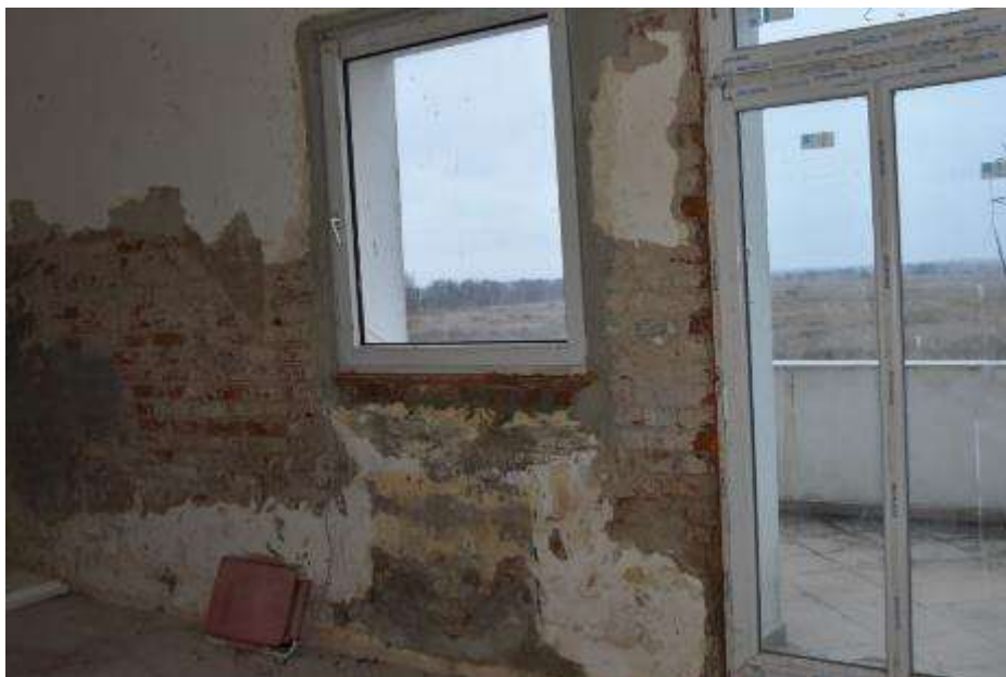
Fot. 158. Fragment ściany zewnętrznej: ściana tynkowana i malowana; rozległe ubytki wyprawy; odsłonięta cegła powierzchniowo skorodowana;
