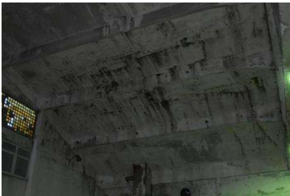
Fot. 233. Fragment płyty dachowej: od strony północnej punktowe zawilgocenie;
