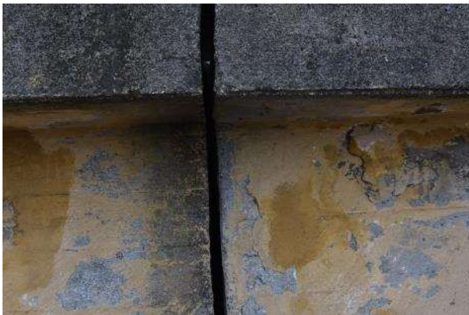
Fot. 403: Fragment elewacji południowej: dylatacja szerokości 25 mm;
