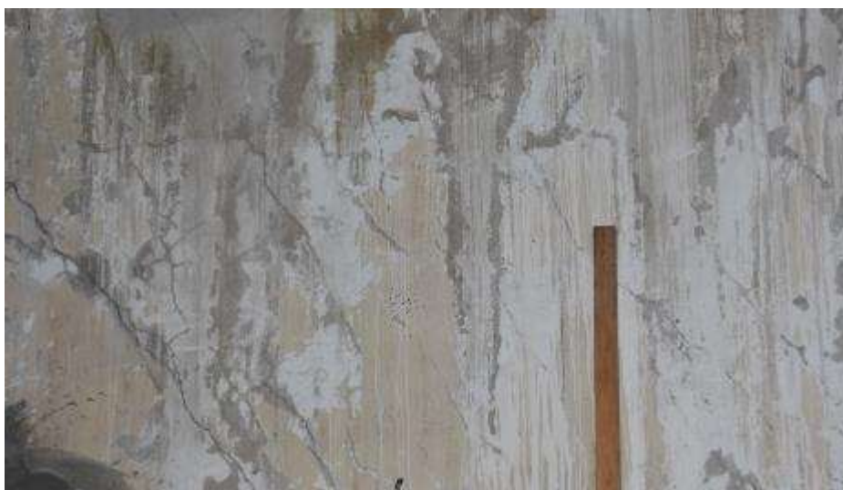
Fot. 36. Fragment ściany zewnętrznej: tynk skorodowany; w rejonie słupa liczne zarysowania;
