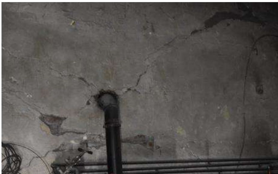
Fot. 142. Fragment ściany wewnętrznej: ściana szkieletowa z wypełnieniem murowanym z cegły ceramicznej; tynk skorodowany;
