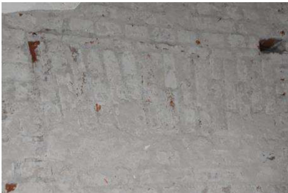
Fot. 87. Fragment ściany wewnętrznej: w ścianie zamurowany otwór; widoczne nadproże ceramiczne;
