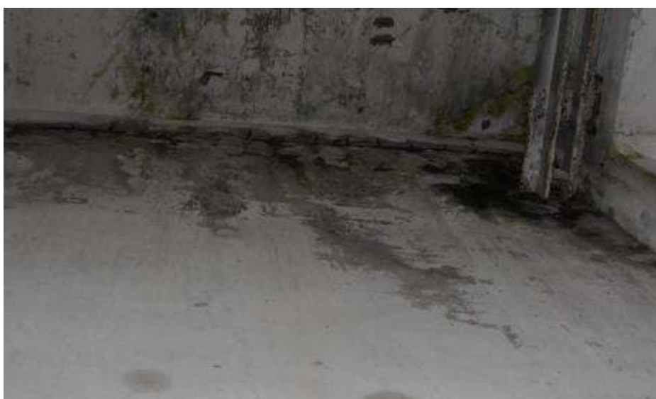
Fot. 30. Fragment ściany wewnętrznej: odsłonięte zbrojenie dolne belki wieńczącej; pręty powierzchniowo skorodowane;
