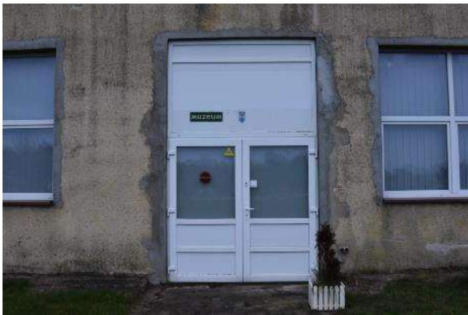
Fot. 281: Fragment elewacji zachodniej: otwór drzwiowy utworzony poprzez usunięcie partii podokiennej;
