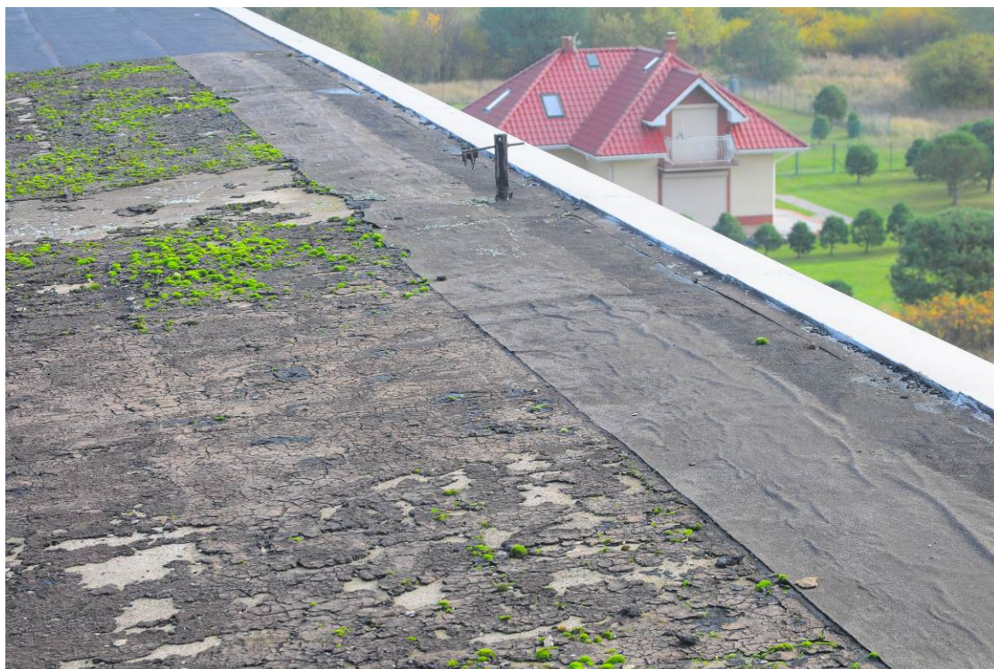
6.7 Widok dachu – część pulpitowa wraz z obróbką, krawędź południowa (do remontu).
