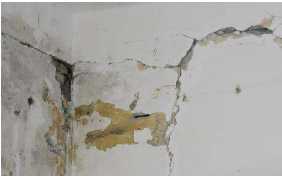
Fot. 119. Fragment ściany wewnętrznej: w narożniku zarysowanie;
