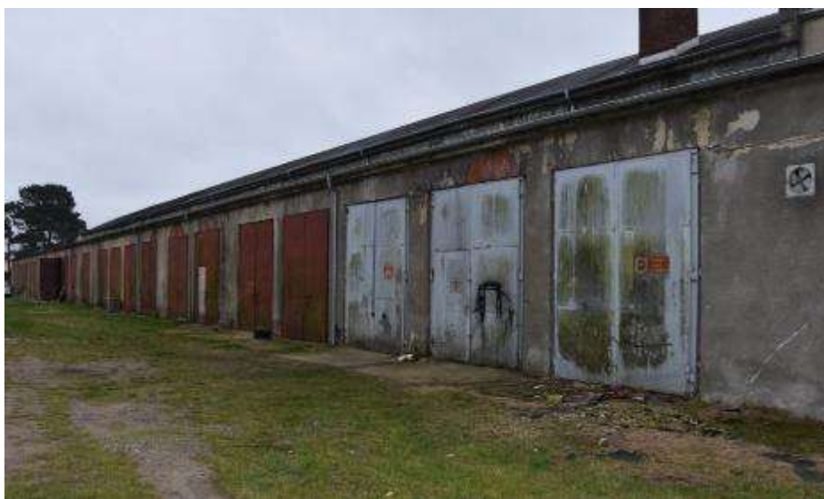
Fot. 299: Fragment elewacji północnej: budynek parterowy; w ścianie 25 bram garażowych; ściana murowana; tynkowana; warstwa zewnętrzna tzw. „baranek”;
