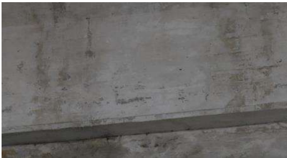
Fot. 39. Fragment ściany zewnętrznej: zacieki w górnej części;
