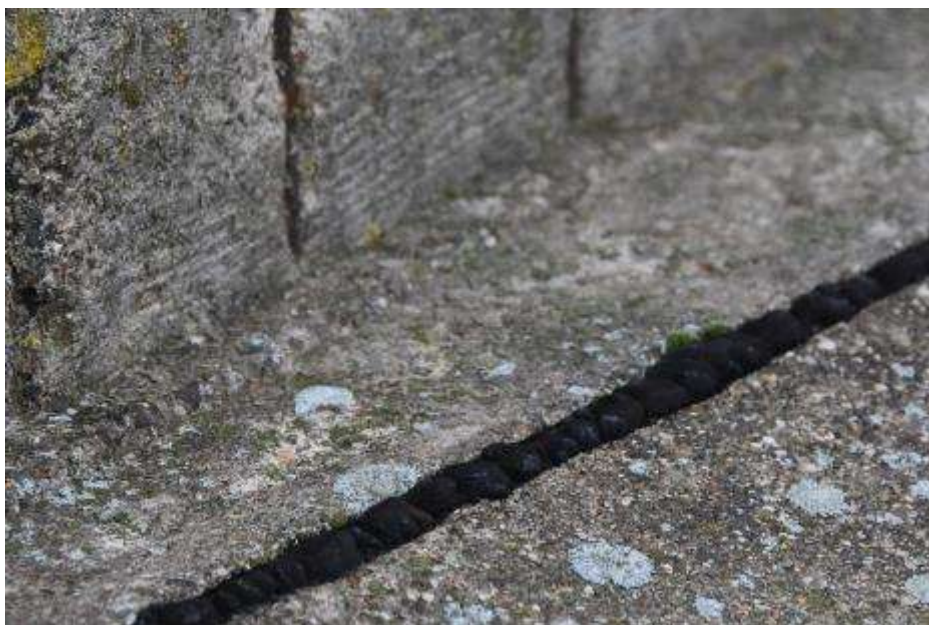
Fot. 419: Fragment elewacji południowej: szczelina między belką a gzymsem wypełniona materiałem bitumicznym;
