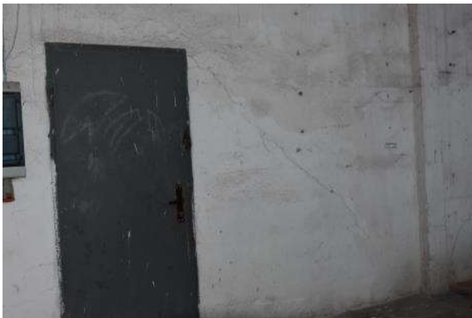
Fot. 80. Fragment ściany zewnętrznej: zarysowania wypełnienia w rejonie otworów drzwiowych;
