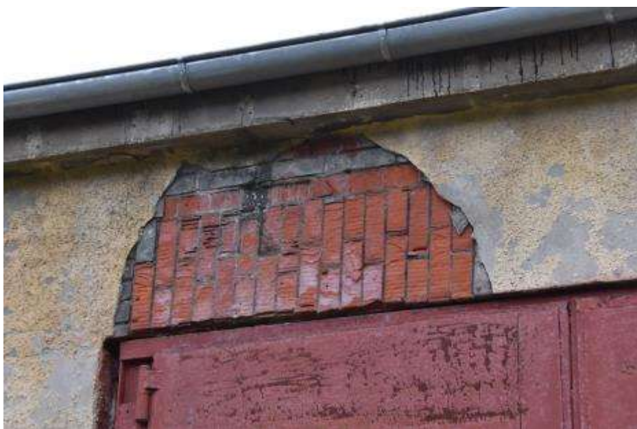
Fot. 314: Fragment elewacji północnej: rozległy ubytek tynku na nadprożu bramy w osi siedemnastej od zachodu; uszkodzenia lica cegły;
