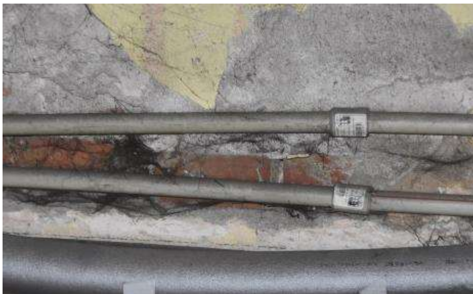
Fot. 148. Fragment ściany wewnętrznej: ściana wymurowana z cegły ceramicznej; tynkowana; tynk skorodowany; odspojony we fragmentach odpada;
