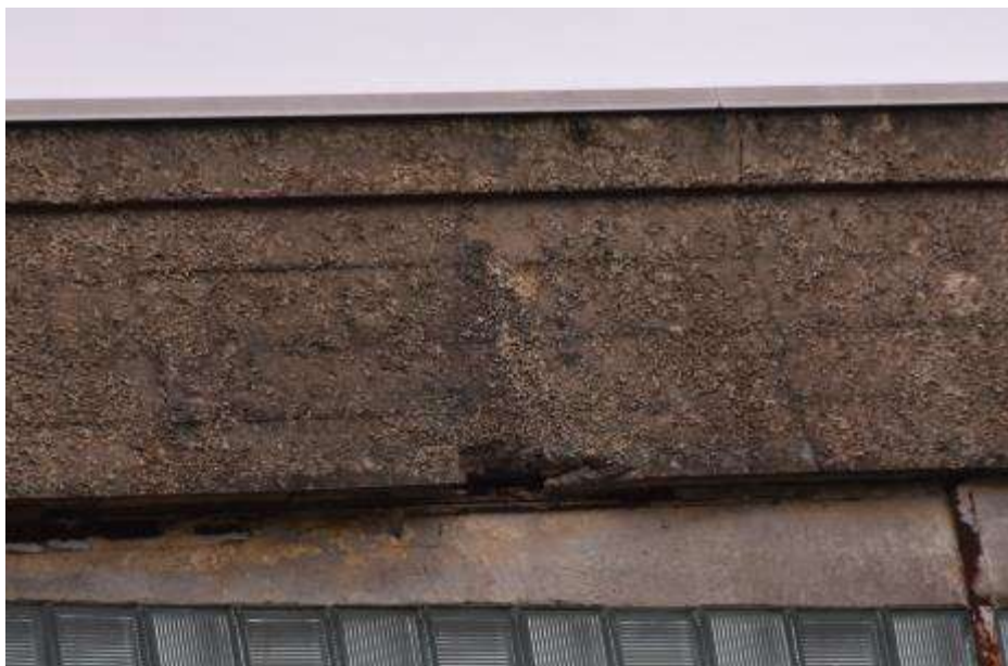
Fot. 293: Fragment elewacji zachodniej: lokalnie ubytki otuliny prętów; od góry ściana zabezpieczona obróbką z blachy;
