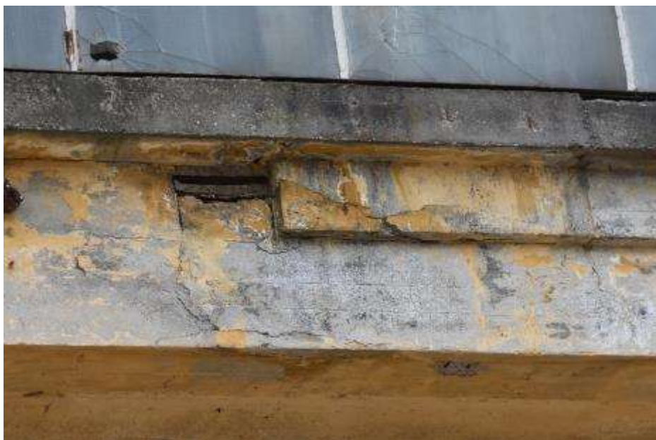
Fot. 406: Fragment elewacji południowej: ubytek otuliny prętów przy oparciu dźwigara nr II; odsłonięte zbrojenie skorodowane;
