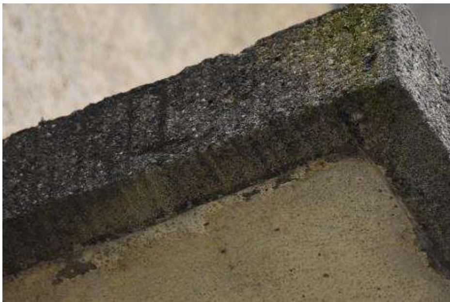
Fot. 284: Fragment elewacji zachodniej: nad wejściem daszek żelbetowy; powierzchnie boczne gradzinowane;
