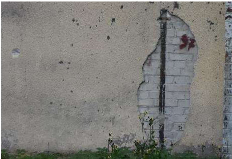
Fot. 340: Fragment elewacji wschodniej: lokalnie ubytki tynku;
