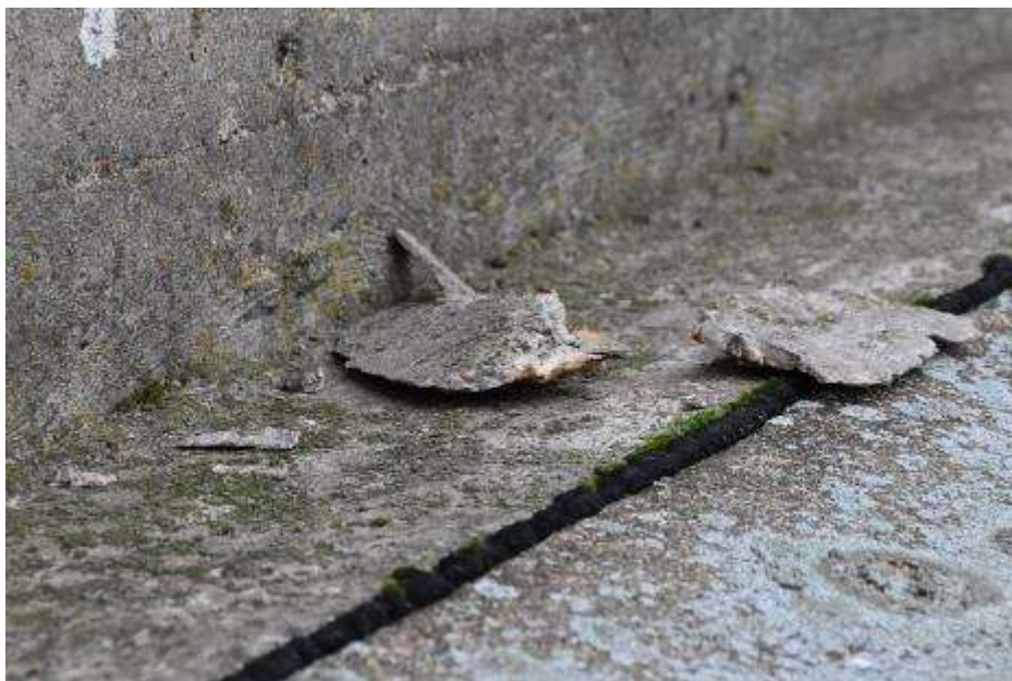
Fot. 417: Fragment elewacji południowej: ubytki otuliny zalegają na dolnej półce belki;
