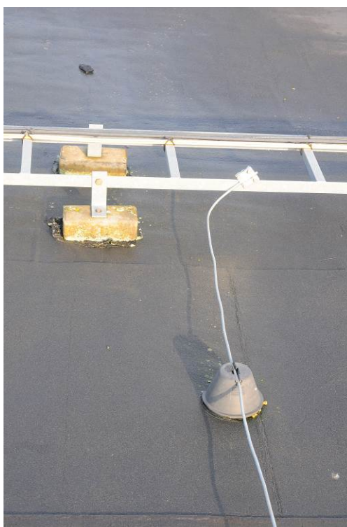
6.10 Widok na mocowanie konstrukcji wsporczej dla przewodów GSM (do zachowania).
