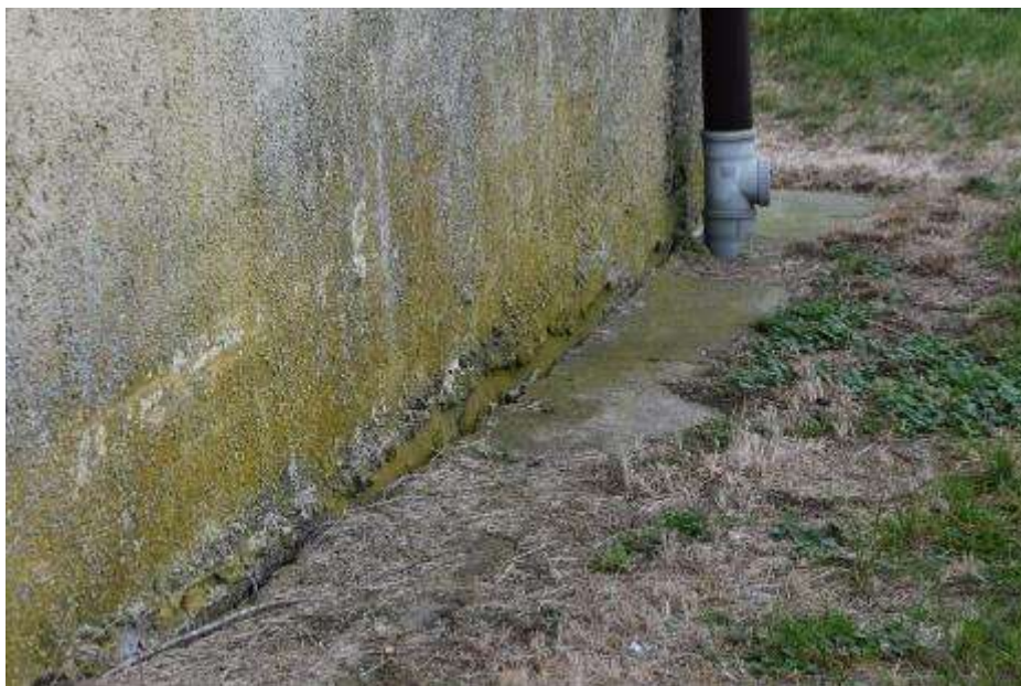
Fot. 274: Fragment elewacji zachodniej: przy elewacji opaska betonowa;
