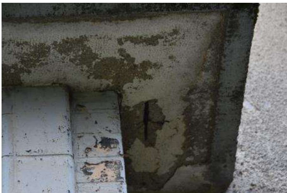
Fot. 348: Fragment elewacji wschodniej: na podniebieniu tynk odspojony; lokalnie brak otuliny prętów;
