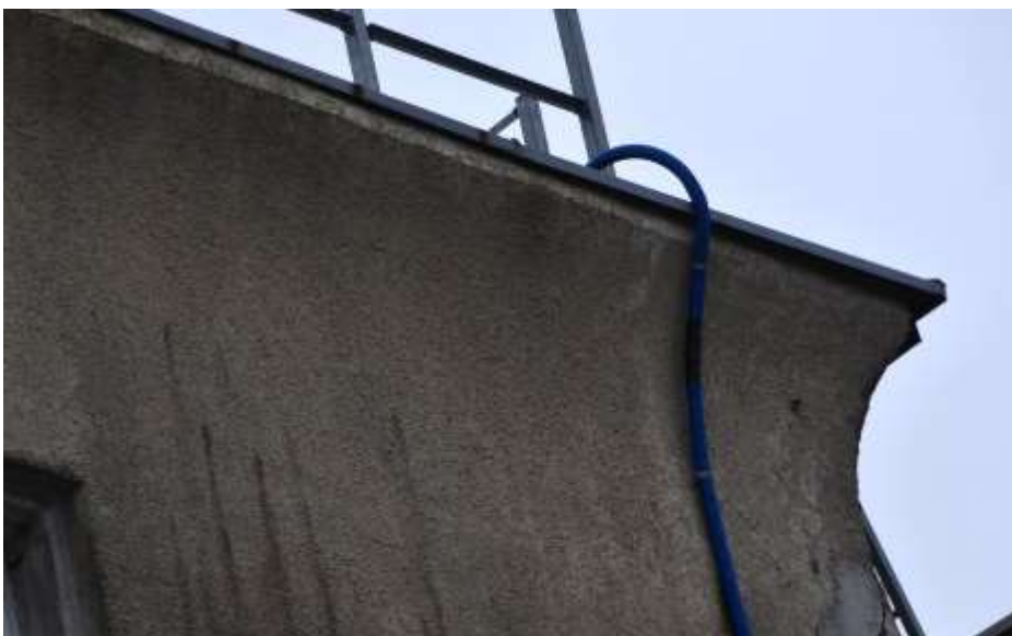
Fot. 332: Fragment elewacji północnej: ściana zwieńczona wyoblonym gzymsem; od góry zabezpieczona obróbką z blachy;
