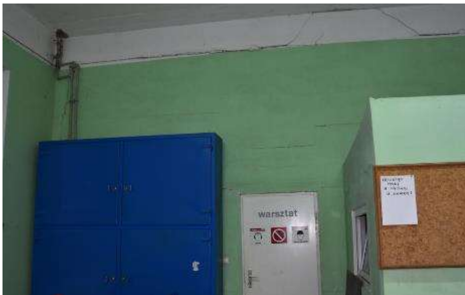
Fot. 112. Fragment ściany wewnętrznej: w poziomie parteru ściana wewnętrzna dzieląca budynki „C” i „B”; ściana szkieletowa z wypełnieniem murowanym z cegły ceramicznej; tynkowana; z okładziną z płyt G-K;
