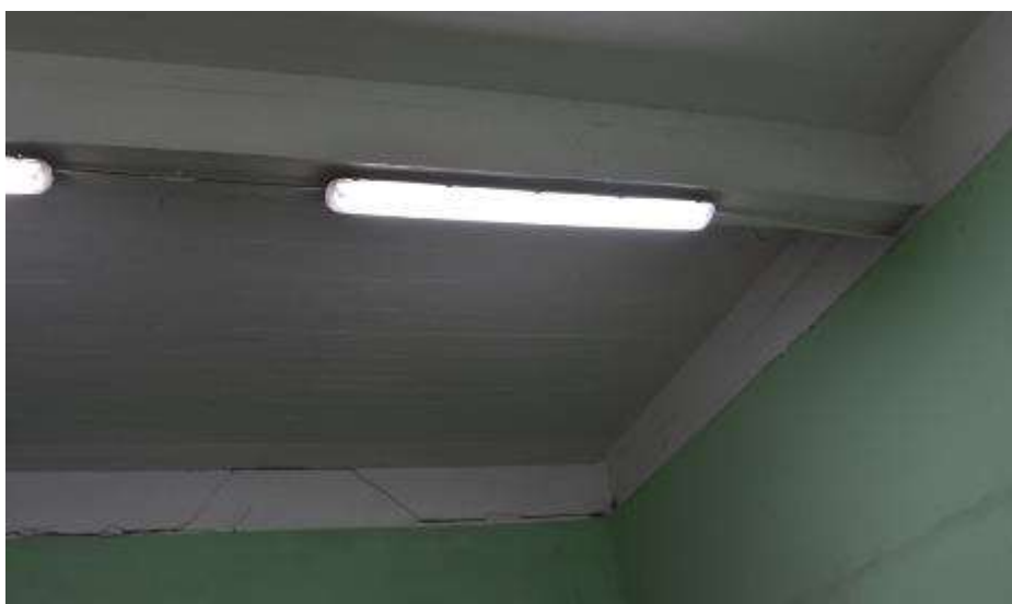
Fot. 166. Fragment stropu nad parterem: strop płytowo żebrowy; monolityczny; widoczne ślady po szalunkach drewnianych;
