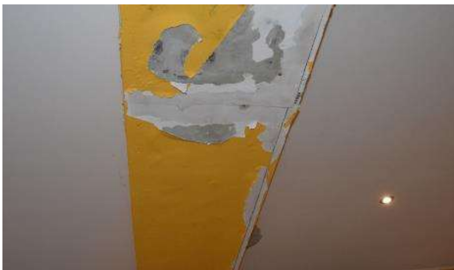
Fot. 178. Fragment stropu nad I piętrem: w pomieszczeniu nr 28 na styku budynków „E” i „D” dylatacja; w linii dylatacji podciąg z obudową z płyt G-K; pęknięcie na styku płyt;
