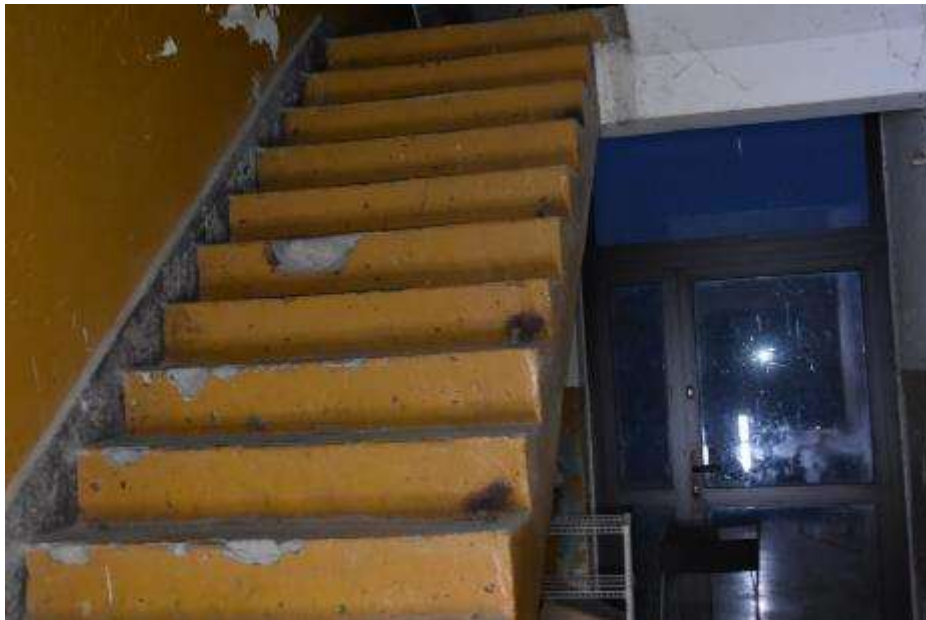
Fot. 184. Fragment biegu schodowego: schody płytowe; żelbetowe; stopnie i podstopnice malowane; lokalnie uszkodzenia mechaniczne;
