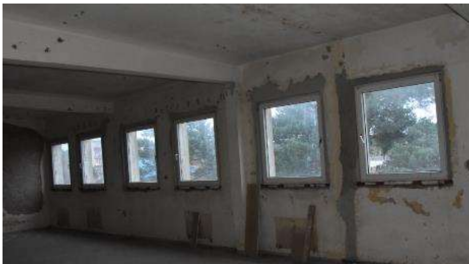
Fot. 141. Fragment ściany zewnętrznej: tynki skorodowane; złuszczenia warstw malarskich; ślady napraw;
