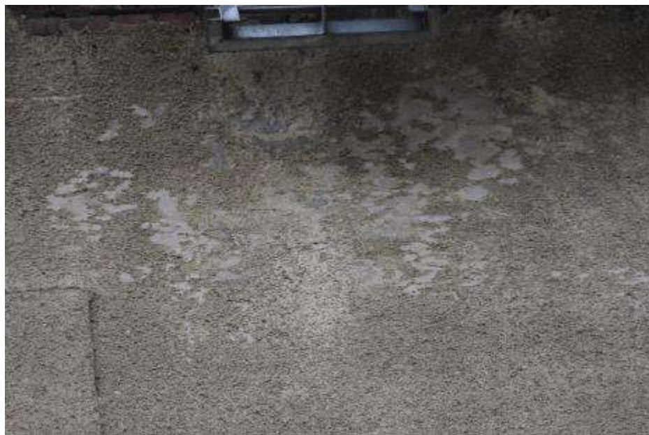
Fot. 366: Fragment elewacji wschodniej: pod stacją zawilgocenia; korozja wyprawy tynkarskiej;
