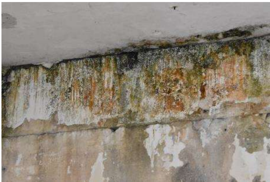
Fot. 33. Fragment ściany wewnętrznej: belka żelbetowa zawilgocona; beton skorodowany; na powierzchni rozwój glonów i grzybów pleśniowych;
