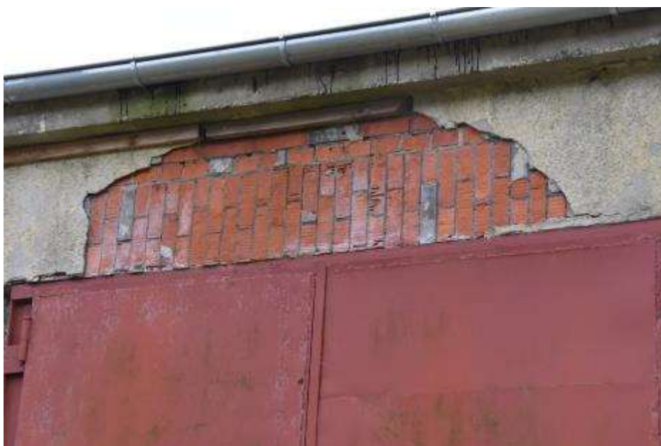
Fot. 310: Fragment elewacji frontowej: rozległy ubytek tynku na nadprożu bramy w osi siódmej od zachodu; uszkodzenia lica cegły;
