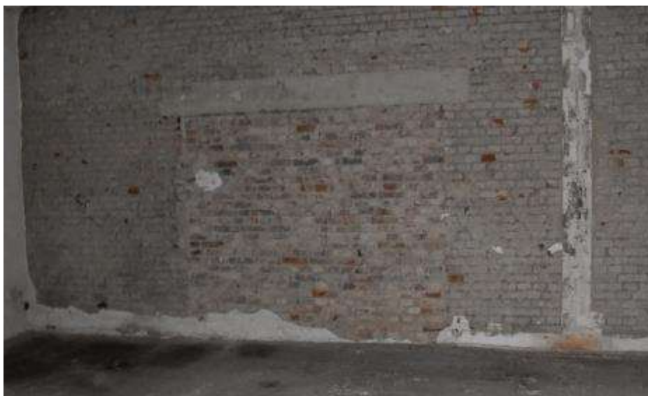
Fot. 84. Fragment ściany wewnętrznej: od strony garażu nr G7 ściana wypełniająca murowana z cegły ceramicznej;
