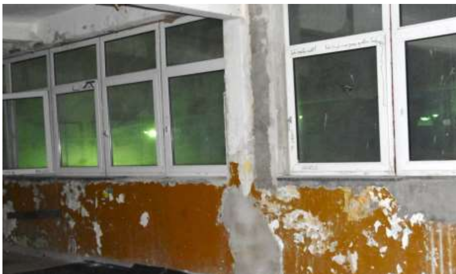
Fot. 31. Fragment ściany wewnętrznej: w pomieszczeniu nr 16 ściana zawilgocona; - w pomieszczeniu nr 20 ściana silnie zawilgocona w narożniku przy osi 5-5; złuszczenia warstw tynkarskich;
