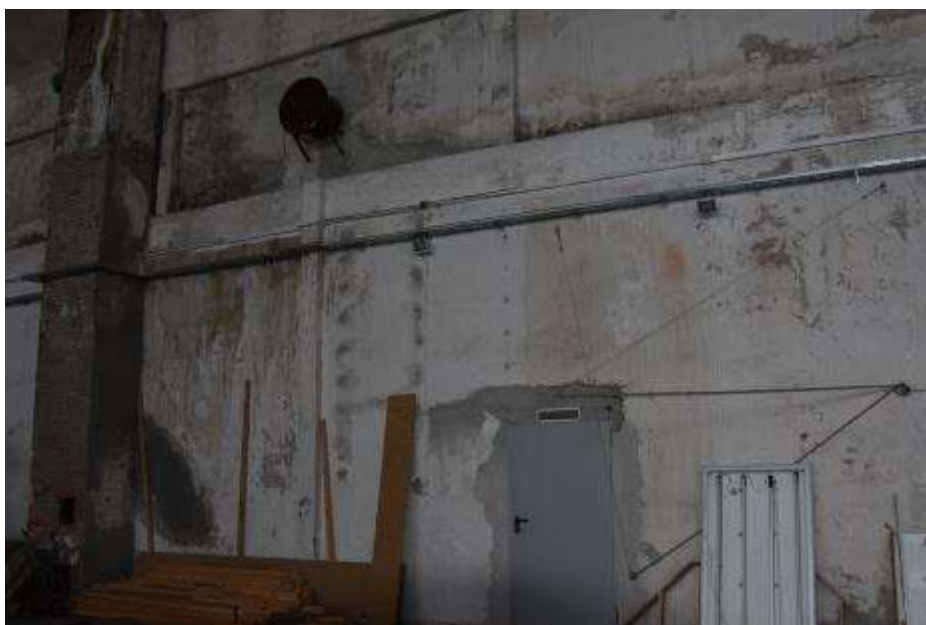
Fot. 35. Fragment ściany zewnętrznej: ściana wypełniająca murowana z cegły ceramicznej; tynkowana; przy ścianie pilaster żelbetowy o szerokości 26 cm;
