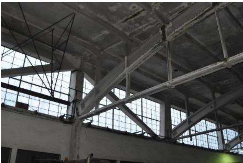
Fot. 202. Fragment dźwigara w osi III-III: od strony południowej dźwigar z zaciekami; - na powierzchni ściągu zacieki; rozwój kolonii glonów;
