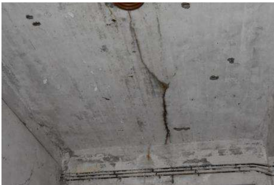
Fot. 239. Fragment stropodachu nad parterem: zarysowanie w środku rozpiętości płyty;
