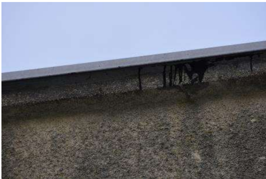
Fot. 427: Fragment elewacji południowej: ściana zwieńczona prostym wysuniętym gzymsem; gzyms od góry zabezpieczony obróbką z blachy;
