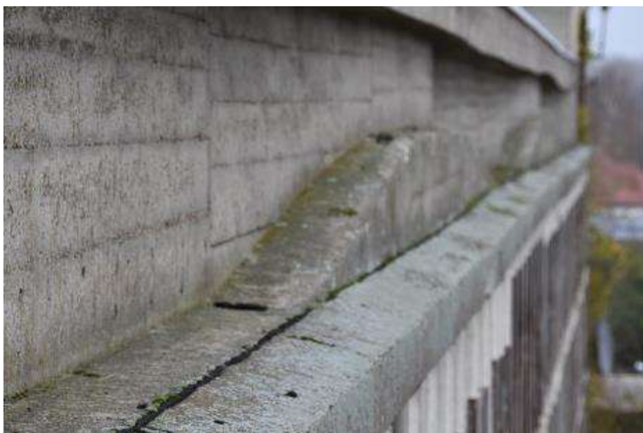
Fot. 418: Fragment elewacji południowej: przy dolnej półce belki kratownicy dodatkowa belka pełniąca rolę gzymsu; belka o szerokości 24 cm i wysokości 18 cm;
