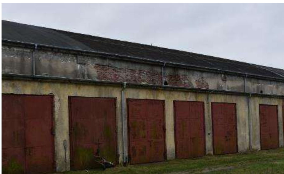
Fot. 318: Fragment elewacji północnej: w poziomie parteru elewacja przysłonięta budynkiem „C”; powyżej elewacja tynkowana; o konstrukcji szkieletowej; żelbetowej; wypełnienie murowane z cegły ceramicznej;
