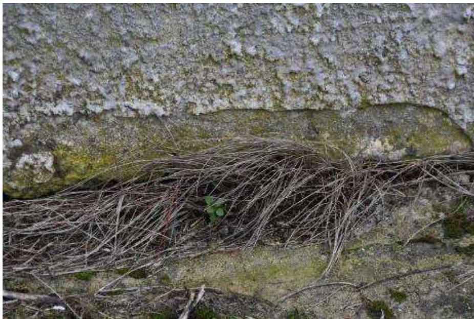
Fot. 296: Fragment elewacji zachodniej: przy elewacji opaska betonowa; w szczelinie pomiędzy opaską a elewacją wegetacji roślin trawiastych;
