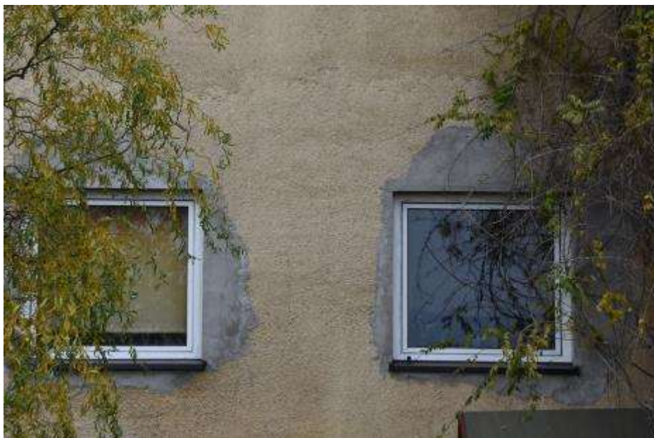
Fot. 378: Fragment elewacji południowej: uzupełnienia tynku wokół otworów okiennych w poziomie parteru;
