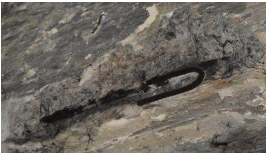
Fot. 144. Fragment ściany wewnętrznej: w górnej części ściany belka żelbetowa; lokalnie odsłonięte zbrojenie; pręt powierzchniowo skorodowany;
