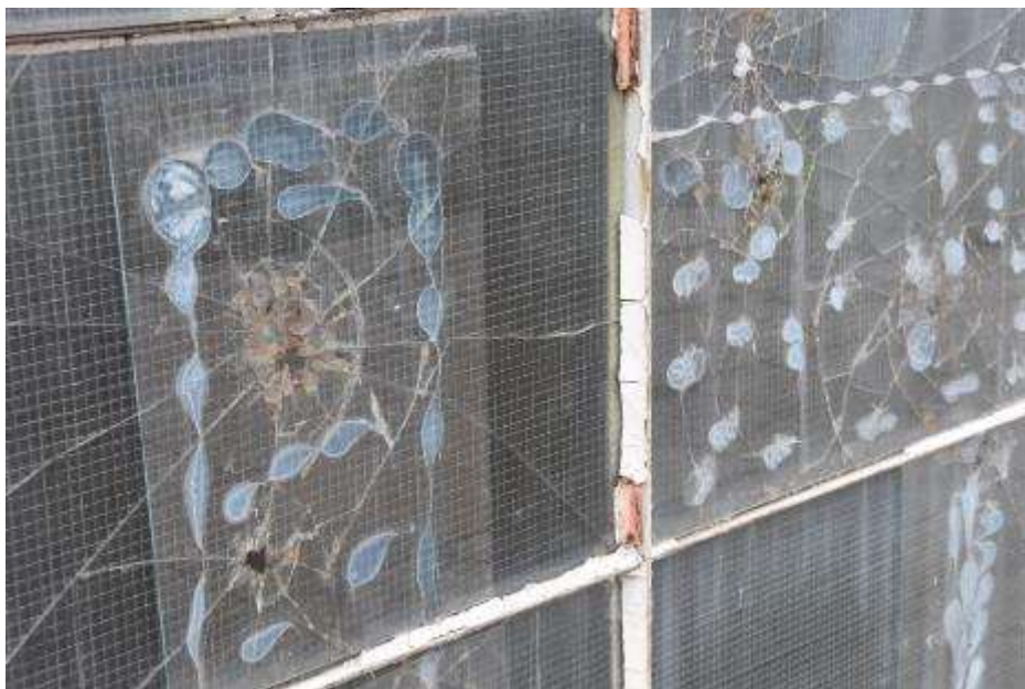
Fot. 389: Fragment elewacji południowej: ślady napraw wykonanych w przeszłości; - za elewacją szklaną widoczna kratownica żelbetowa;
