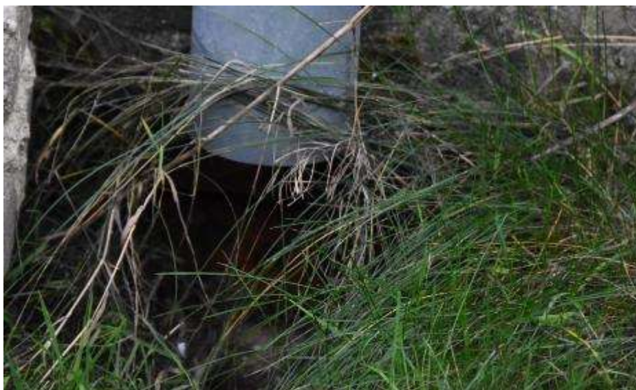
Fot. 265. Fragment elewacji północnej: rura spustowa na filarze szóstym od zachodu bez końcówki; woda odprowadzona bezpośrednio na teren;
