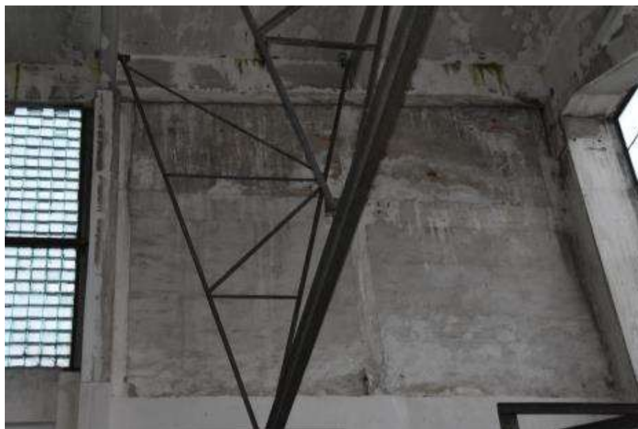
Fot. 96. Fragment ściany zewnętrznej: powyżej tynki skorodowane; na powierzchni ciemne naloty;
