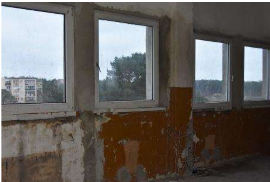
Fot. 165. Fragment ściany zewnętrznej: na powierzchni tynku ślady zawilgocenia; wyprawy skorodowane; złuszczenia warstw malarskich;
