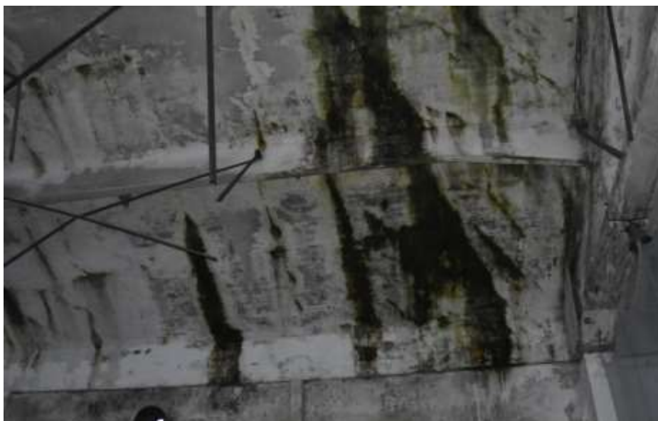
Fot. 224. Fragment płyty dachowej: rozległy zaciek przy dźwigarze w osi V-V; na powierzchni płyty rozwój kolonii glonów;
