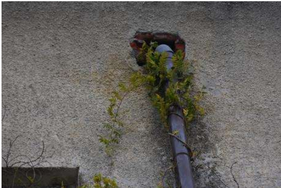
Fot. 381: Fragment elewacji południowej: przy wylocie rury spustowej zacieki; korozja tynku;
