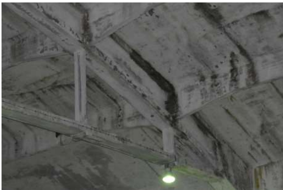
Fot. 197. Fragment dźwigara w osi I-I: od strony północnej z zaciekami; rozwój kolonii glonów na styku z płytą dachową;
