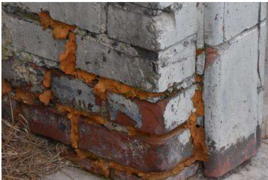
Fot. 283: Fragment elewacji zachodniej: głębokie ubytki zaprawy w spoinach;
