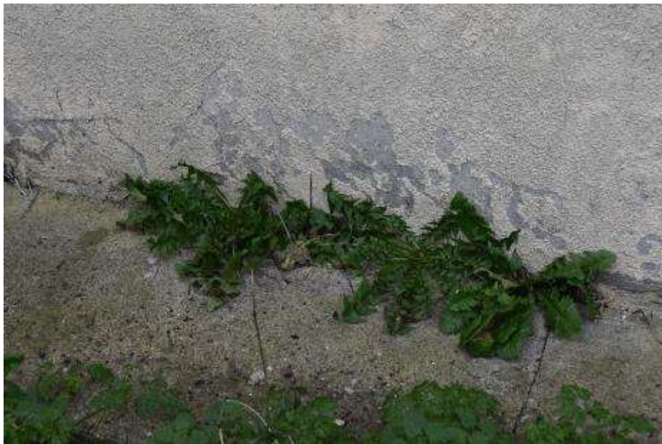
Fot. 341: Fragment elewacji wschodniej: przy elewacji opaska betonowa; w szczelinie pomiędzy opaską a ścianą wegetacja roślin jednorocznych;
