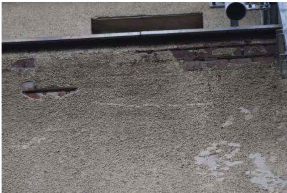
Fot. 367: Fragment elewacji wschodniej: ściana zwieńczona wyoblonym gzymsem; od góry zabezpieczona obróbką z blachy; gzyms murowany z cegły; ubytki wyprawy tynkarskiej;
