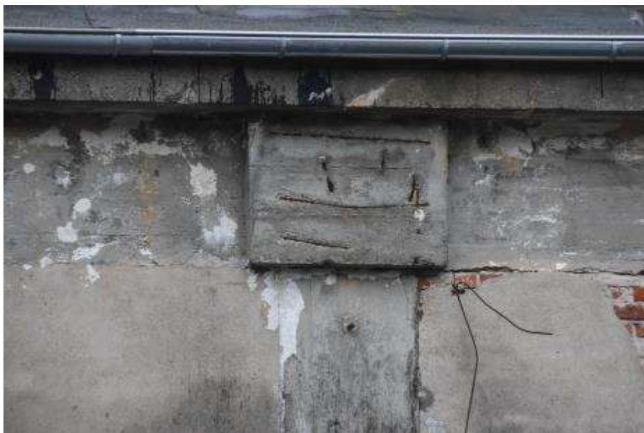
Fot. 323: Fragment elewacji północnej: na dźwigarze odsłonięte zbrojenie;
