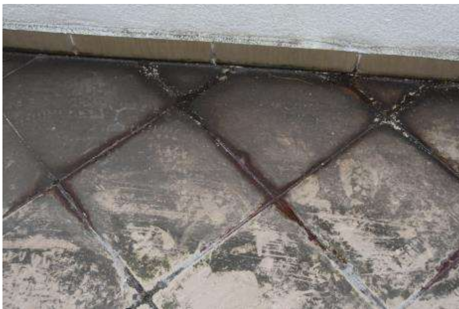
Fot. 192. Fragment tarasu: nad częścią niską budynku „E” w polu między osiami D-E i 1-2 taras na stropie I piętra; na posadzce płytki ceramiczne; ślady po zastoiskach wody;
