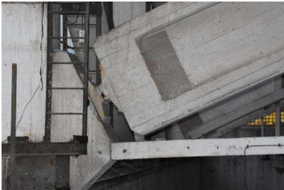
Fot. 214. Fragment dźwigara w osi III-III: węzeł łączący pas dolny i górny dźwigara ze słupem; pas dolny nie połączony z łukiem;
