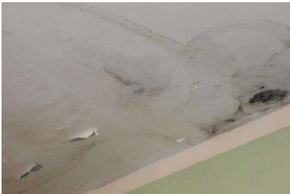
Fot. 168. Fragment stropu nad parterem: w pomieszczeniach sanitariatów sufit podwieszony; tynkowany i malowany; złuszczenia warstw malarskich;
