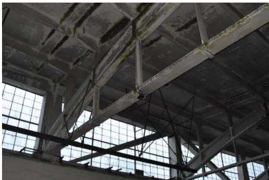
Fot. 217. Fragment dźwigara w osi IV-IV: od strony południowej dźwigar z zaciekami; na powierzchni rozwój kolonii glonów;
