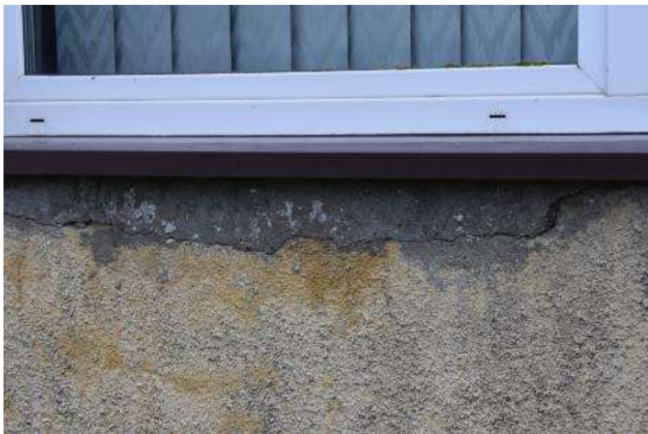
Fot. 279: Fragment elewacji zachodniej: uszkodzenia w partiach podokiennych;
