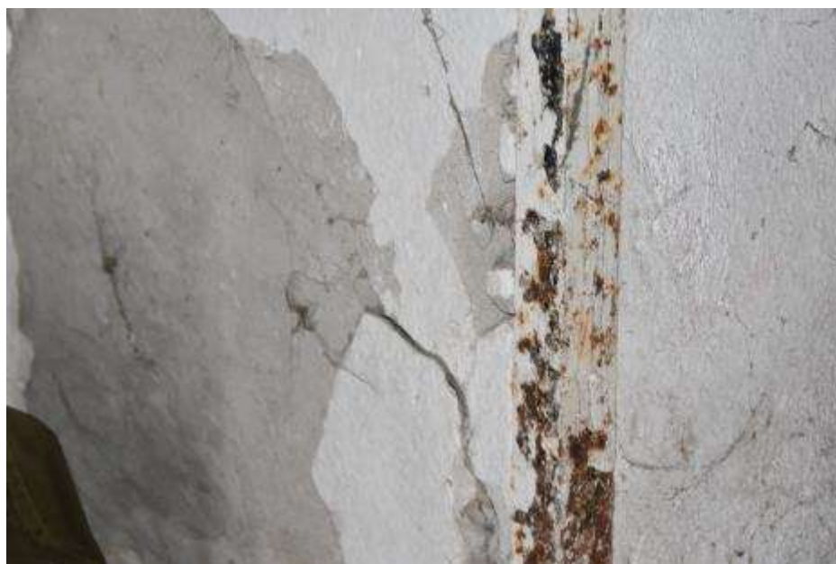
Fot. 124. Fragment ściany zewnętrznej: w dolnej części ściana zawilgocona; wyprawy tynkarskie skorodowane; odspojone; we fragmentach złuszczenia warstwy zewnętrznej tynku;
