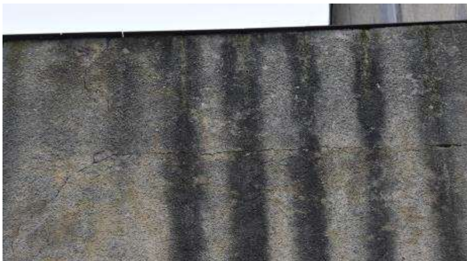
Fot. 371: Fragment elewacji wschodniej: poziome pęknięcie w poziomie stropu nad I piętrem;
