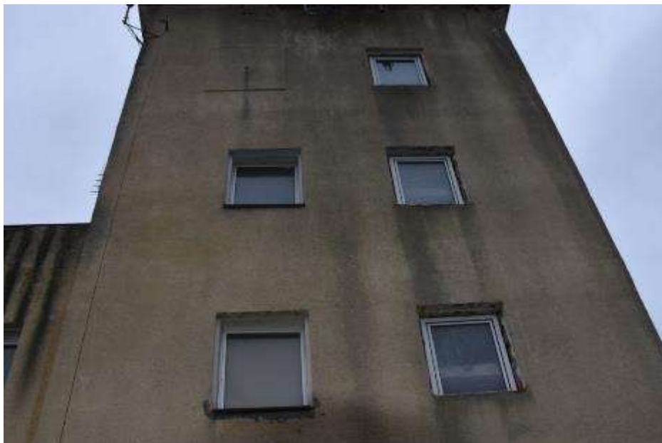
Fot. 361: Fragment elewacji wschodniej: na powierzchni tynku zacieki; ciemne naloty;
