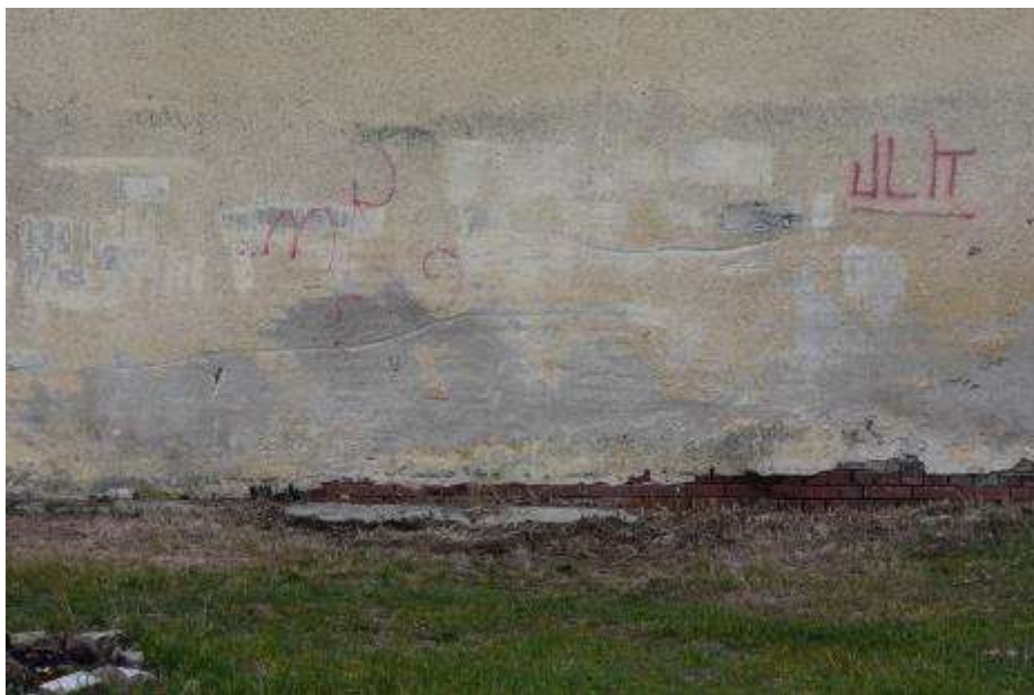
Fot. 424: Fragment elewacji południowej: w dolnej części ściana zawilgocona; tynk skorodowany;
