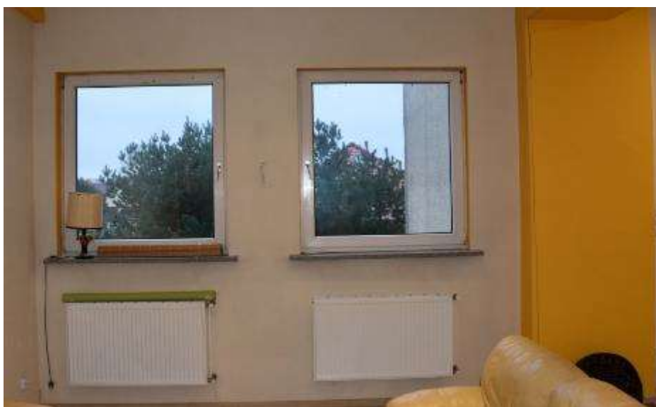
Fot. 137. Fragment ściany zewnętrznej: ściana tynkowana i malowana; po pracach remontowych; w ścianie otwór okienny; stolarka plastikowa;
