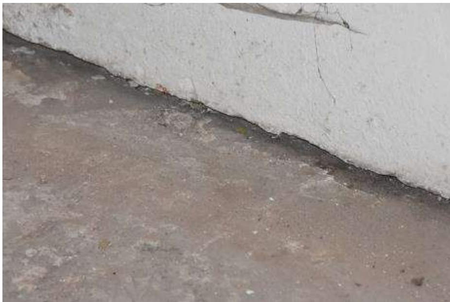
Fot. 127. Fragment ściany zewnętrznej: widoczne zjawisko osiadania posadzki garażu;
