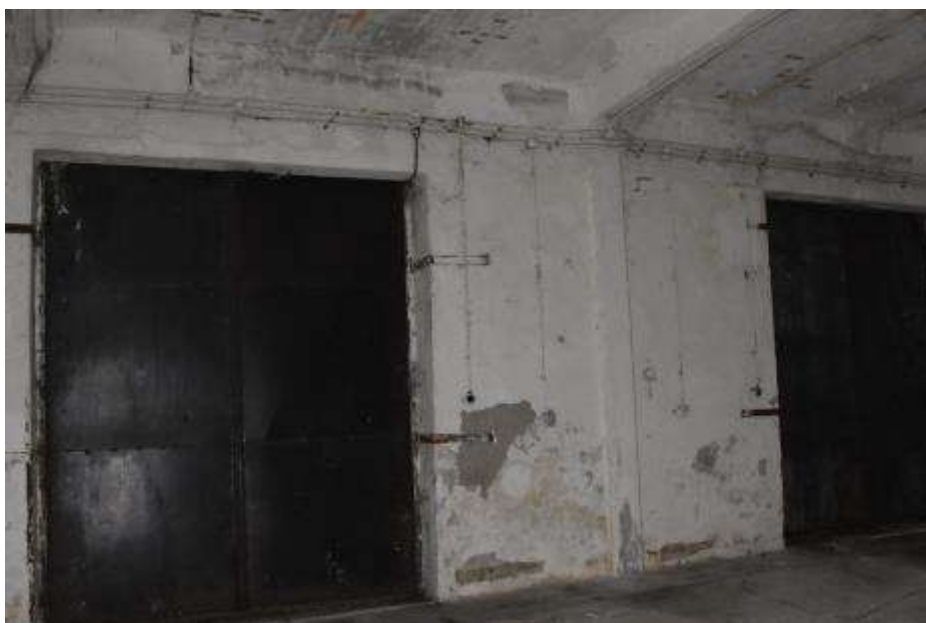
Fot. 120. Fragment ściany zewnętrznej: ściana o konstrukcji szkieletowej; w górnej części belka żelbetowa; na filarze między bramami widoczny słup żelbetowy; wypełnienie murowane z cegły; tynkowane;
