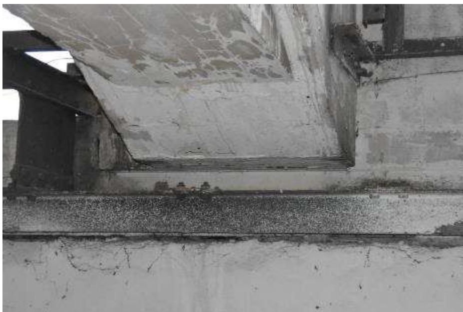
Fot. 218. Fragment dźwigara w osi IV-IV: połączenie wiazara z belką dolną kratownicy przy ścianie frontowej;
