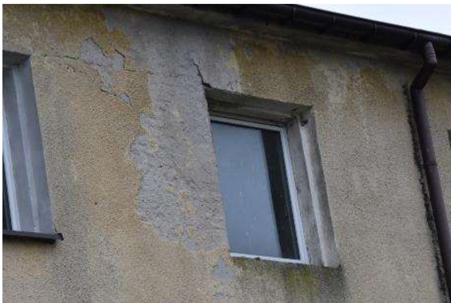
Fot. 352: Fragment elewacji wschodniej: w osi nad wejściem rozległy zaciek pod gzymsem oraz w rejonie okna I piętra; w miejscu zawilgocenia tynk skorodowany; odpada;
