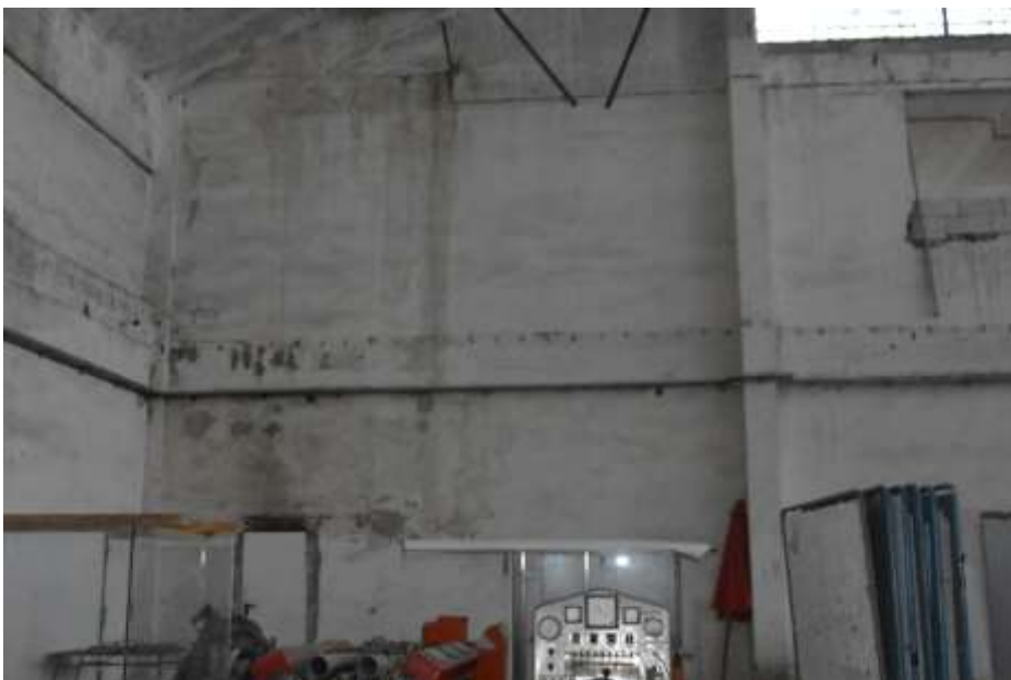
Fot. 89. Fragment ściany zewnętrznej: od strony ściany w osi 5-5 rozległy zaciek; w miejscu zawilgocenia wyprawy tynkarskie skorodowane;
