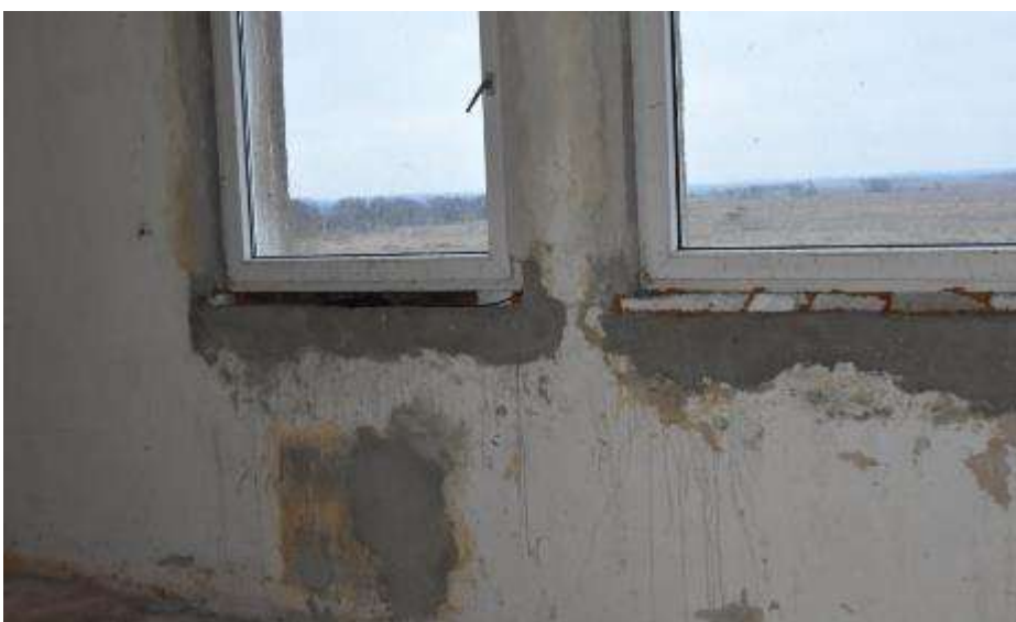
Fot. 159. Fragment ściany zewnętrznej: ściana tynkowana i malowana; w ścianie otwory okienne; stolarka plastikowa; na powierzchni tynku ślady zacieków;
