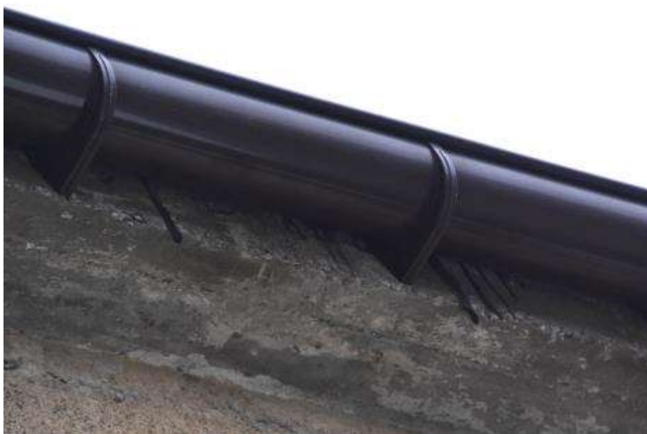
Fot. 351: Fragment elewacji wschodniej: ściana zwieńczona prostym wysuniętym gzymsem żelbetowym; na powierzchni zacieki;
