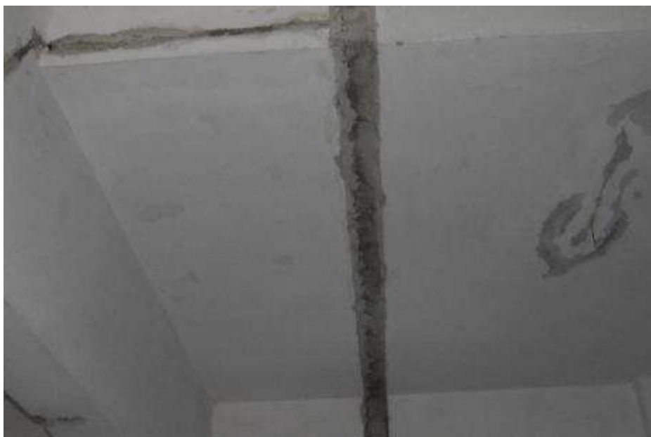
Fot. 244. Fragment stropodachu nad III piętrem: na suficie ślady po rozebranych ściankach działowych;
