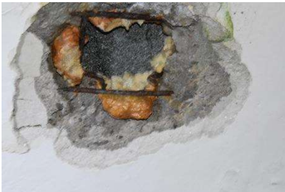
Fot. 234. Fragment stropodachu nad I piętrem: płyta grubości 10 cm; odsłonięte zbrojenie powierzchniowo skorodowane;
