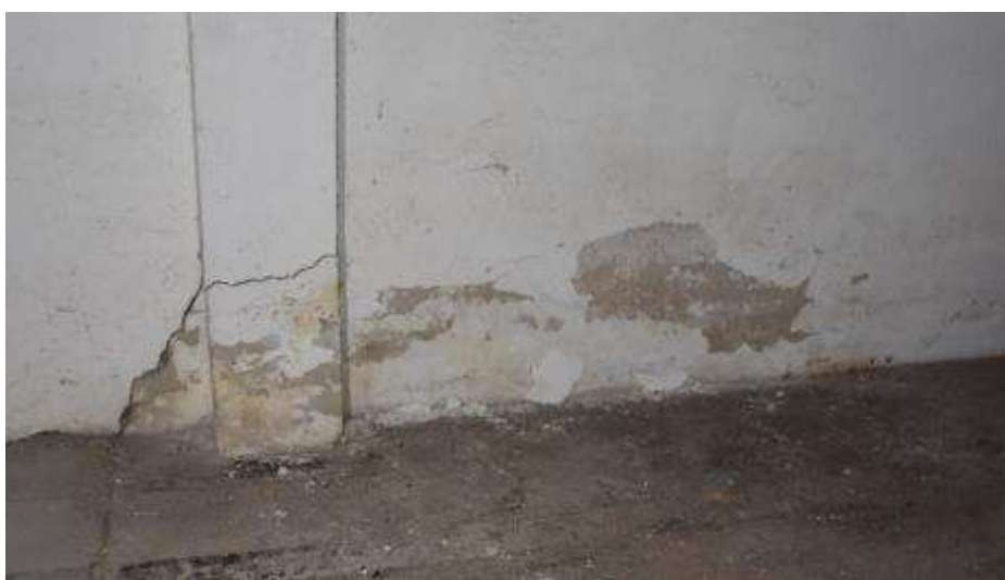
Fot. 126. Fragment ściany zewnętrznej: w dolnej części ściana zawilgocona; tynk skorodowany; odspojony; spękany;
