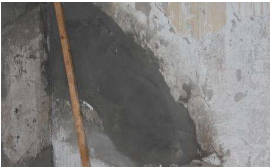
Fot. 37. Fragment ściany zewnętrznej: ślady napraw wyprawy tynkarskiej;
