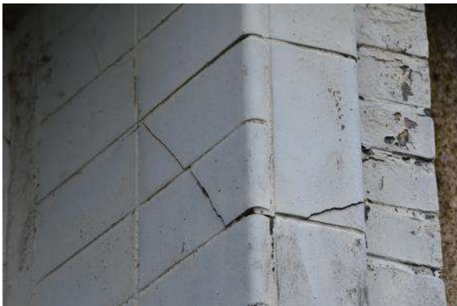
Fot. 345: Fragment elewacji wschodniej: w górnej części zarysowanie o przebiegu ukośnym;
