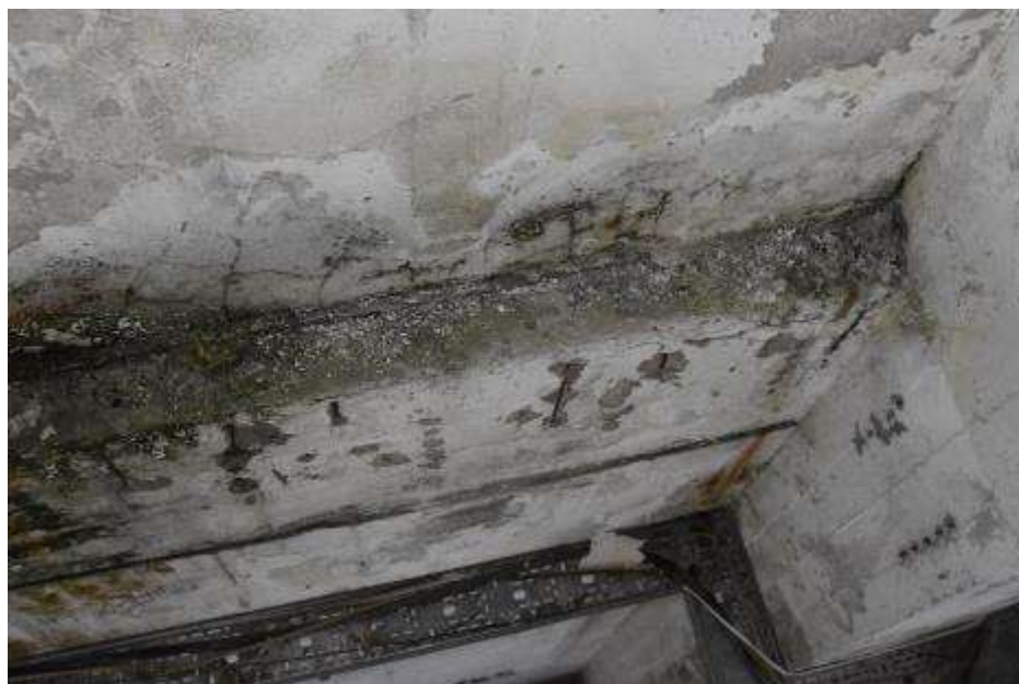
Fot. 73. Fragment ściany zewnętrznej: od góry belka z odsadzką 15 cm;
