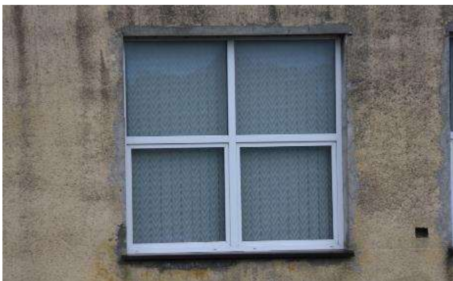
Fot. 272: Fragment elewacji zachodniej: elewacja murowana z cegły ceramicznej; tynkowana i malowana; warstwa zewnętrzna tynku tzw. „baranek”;
