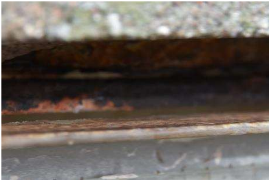
Fot. 421: Fragment elewacji południowej: pod gzymsem płaskownik stalowy 30 x 10 mm; profil powierzchniowo skorodowany;
