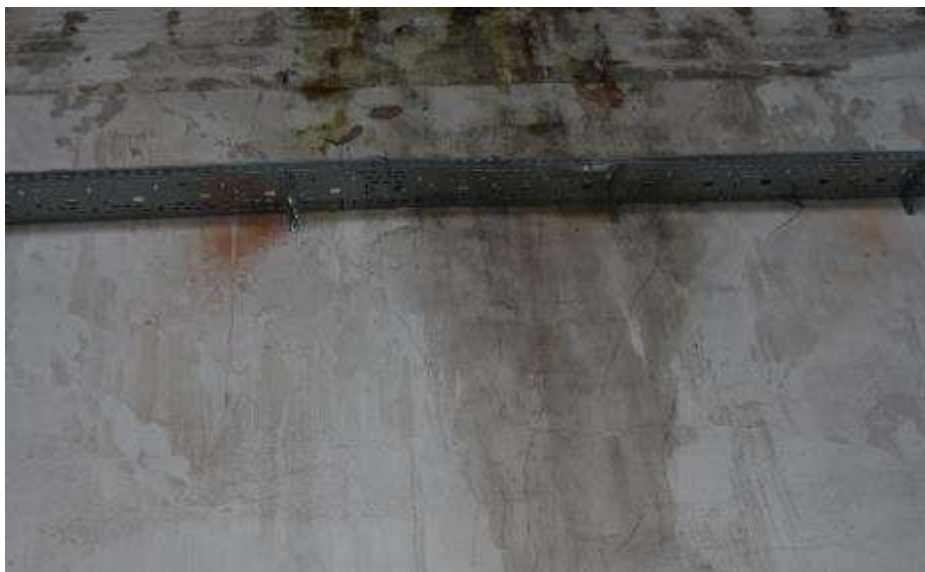
Fot. 56. Fragment ściany zewnętrznej: na ścianie rozległe zacieki; w miejscu zawilgocenia rozwój kolonii glonów; tynk skorodowany; odspojony od podłoża; zarysowania wyprawy;
