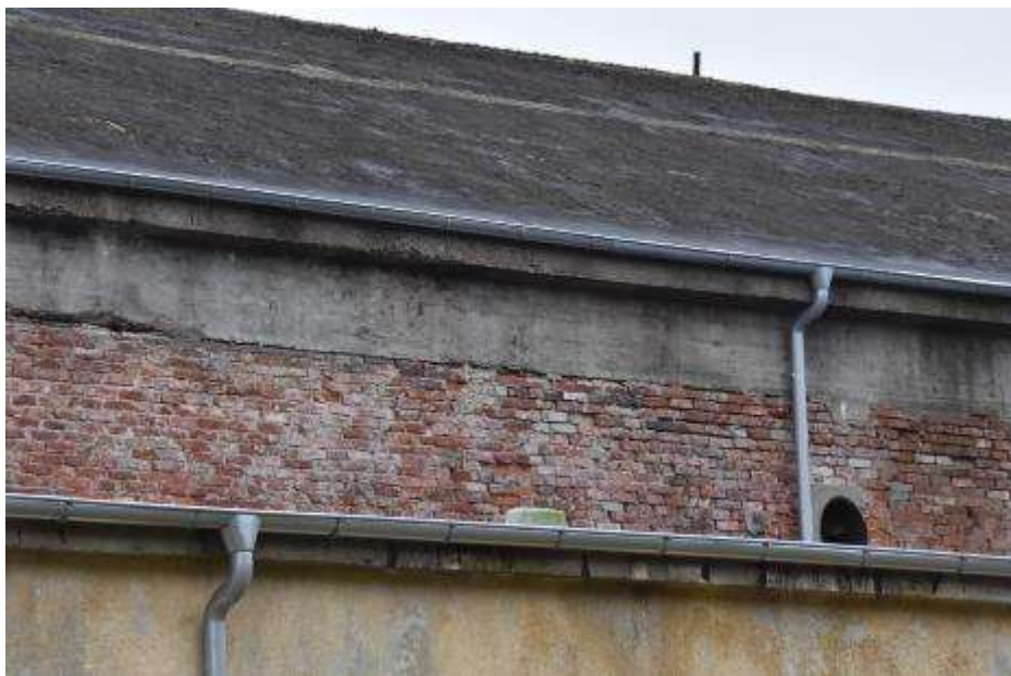
Fot. 320: Fragment elewacji północnej: rozległe ubytki wyprawy tynkarskiej; odsłonięta cegła skorodowana;
