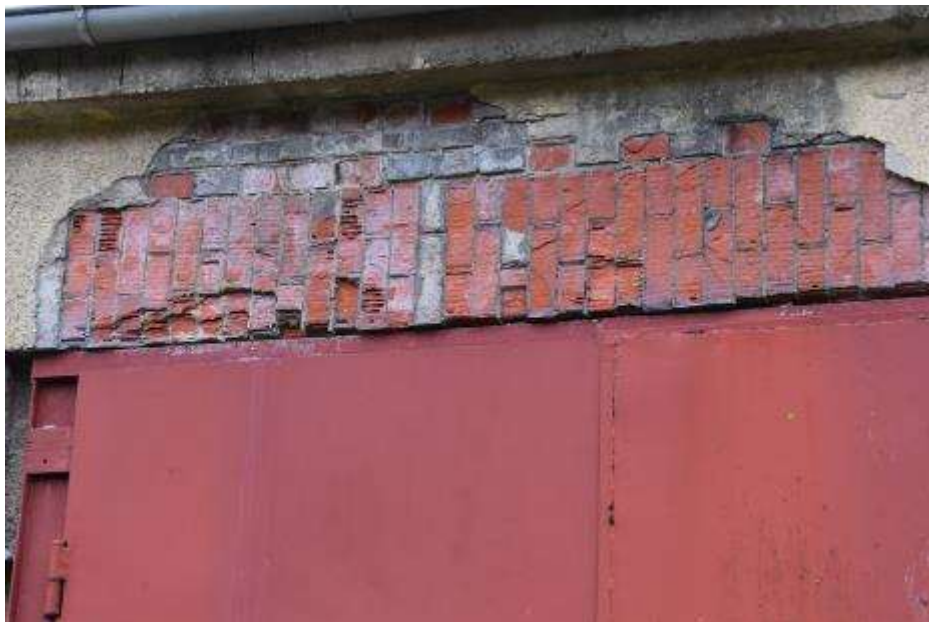
Fot. 313: Fragment elewacji północnej: rozległy ubytek tynku na nadprożu bramy w osi trzynastej od zachodu; uszkodzenia lica cegły;
