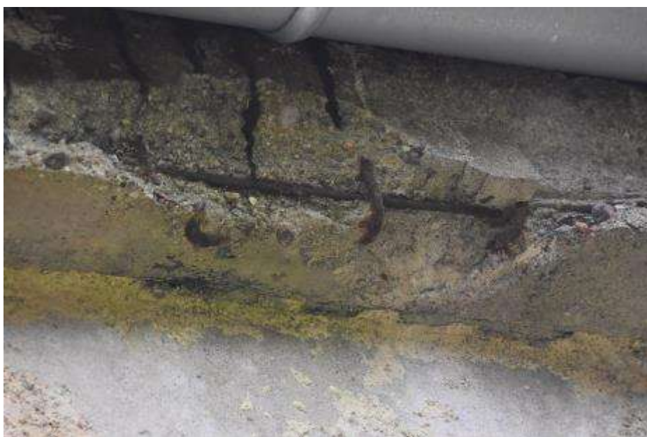
Fot. 312: Fragment elewacji północnej: ściana zwieńczona gzymsem żelbetowym; lokalnie gzyms uszkodzony; odsłonięte pręty skorodowane;
