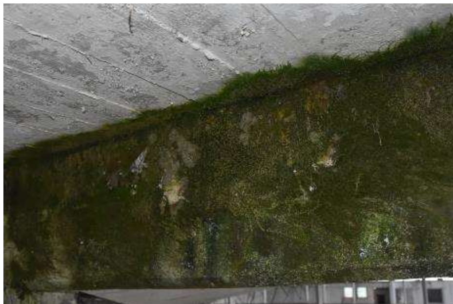
Fot. 207. Fragment dźwigara w osi III-III: pod płytą dachową belka żelbetowa o wysokości 42 cm i szerokości 26 cm; krawędzie fazowane na 3 cm; belka silnie zawilgocona; na powierzchni narośle grzybów pleśniowych i glonów;
