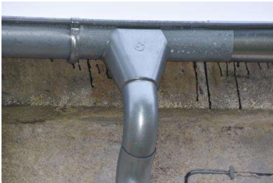
Fot. 263. Fragment elewacji północnej: rynny i rury spustowe z blachy tytan-cynk;
