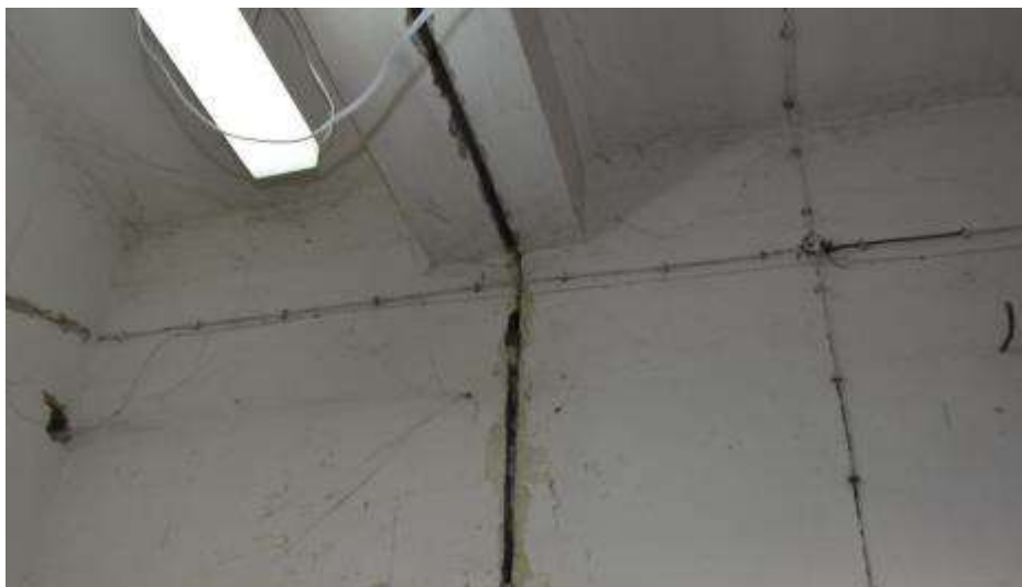
Fot. 99. Fragment ściany wewnętrznej: w pomieszczeniu nr 12 w ścianie widoczna dylatacja;
