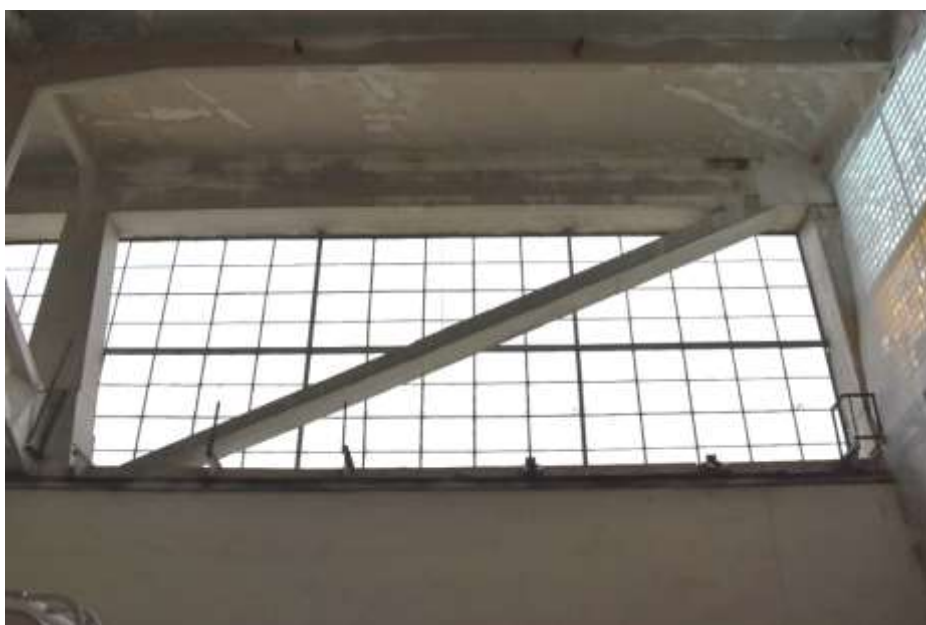
Fot. 3. Fragment ściany zewnętrznej: w górnej części kratownica żelbetowa; pomiędzy słupem w osi B-B a dźwigarem I-I krzyżulec żelbetowy;
