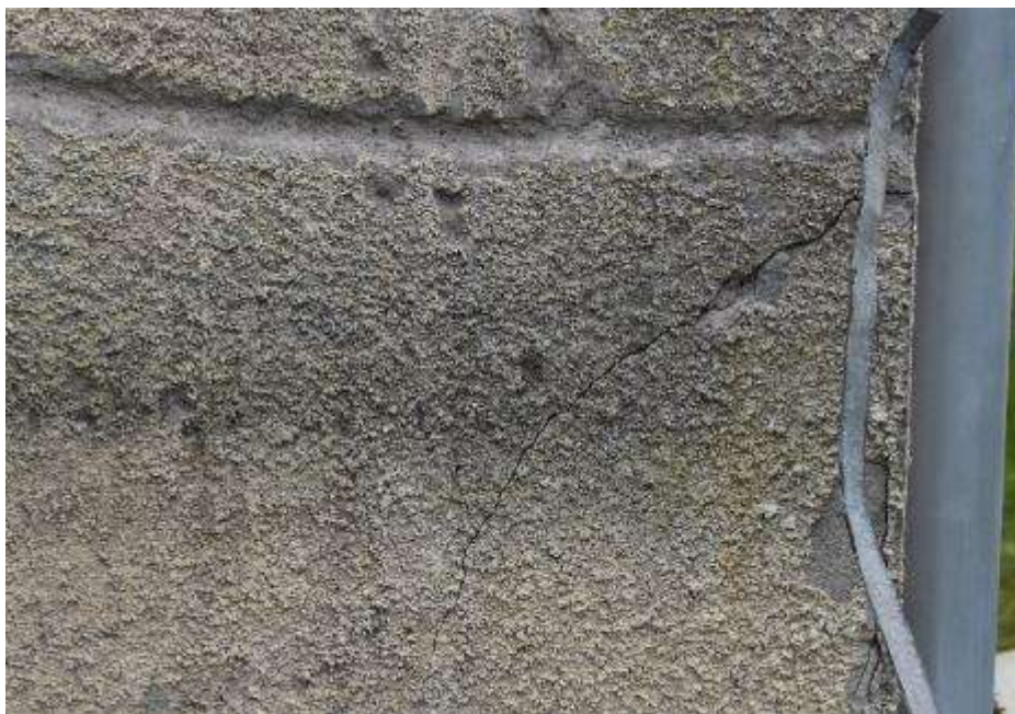
Fot. 335: Fragment elewacji wschodniej: w narożniku północno-wschodnim zarysowanie o przebiegu ukośnym;
