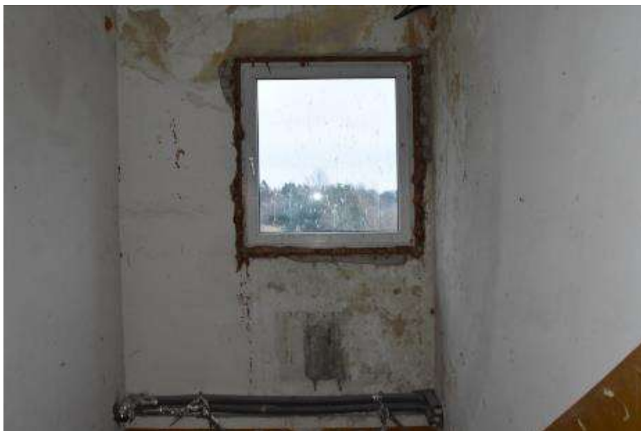
Fot. 140. Fragment ściany zewnętrznej: rozległe zacieki w górnej partii ściany oraz w pasie podokiennym; w miejscach zawilgocenia tynk skorodowany; odspojony od podłoża; złuszczenia warstw malarskich;
