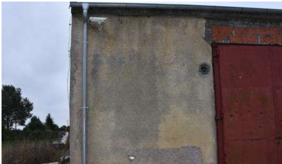
Fot. 317: Fragment elewacji północnej: przy narożniku północno-wschodnim zarysowania o przebiegu ukośnym o rozwarciu do 1,5 mm;
