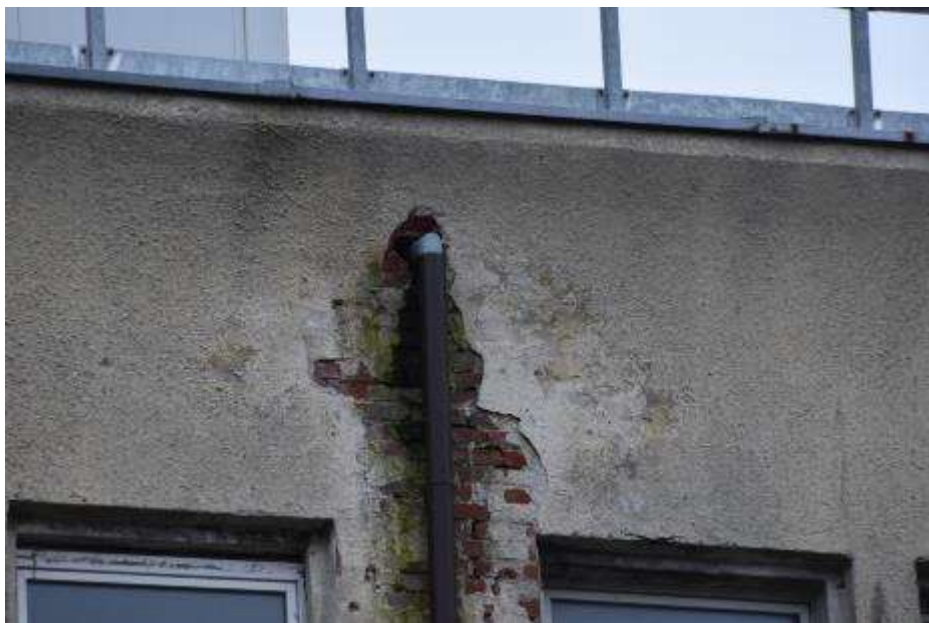
Fot. 331: Fragment elewacji północnej: w rejonie rury spustowej zawilgocenie; ubytki tynku; na powierzchni rozwój kolonii glonów;
