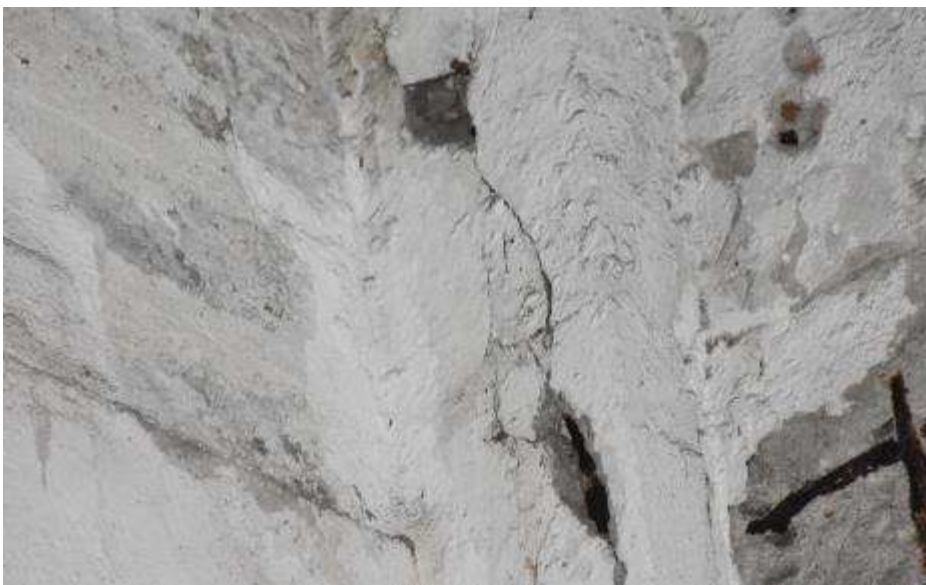
Fot. 83. Fragment ściany zewnętrznej: skrajny słup w ścianie w osi C-C na wysokości belki z ubytkiem otuliny prętów;
