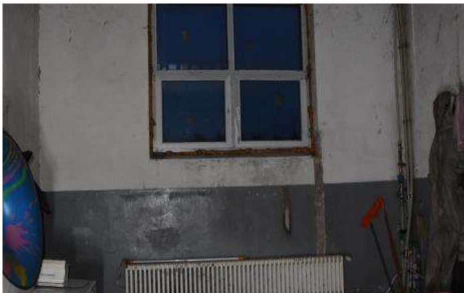
Fot. 130. Fragment ściany zewnętrznej: ściana o konstrukcji szkieletowej; w górnej części belka żelbetowa; wypełnienie murowane;
