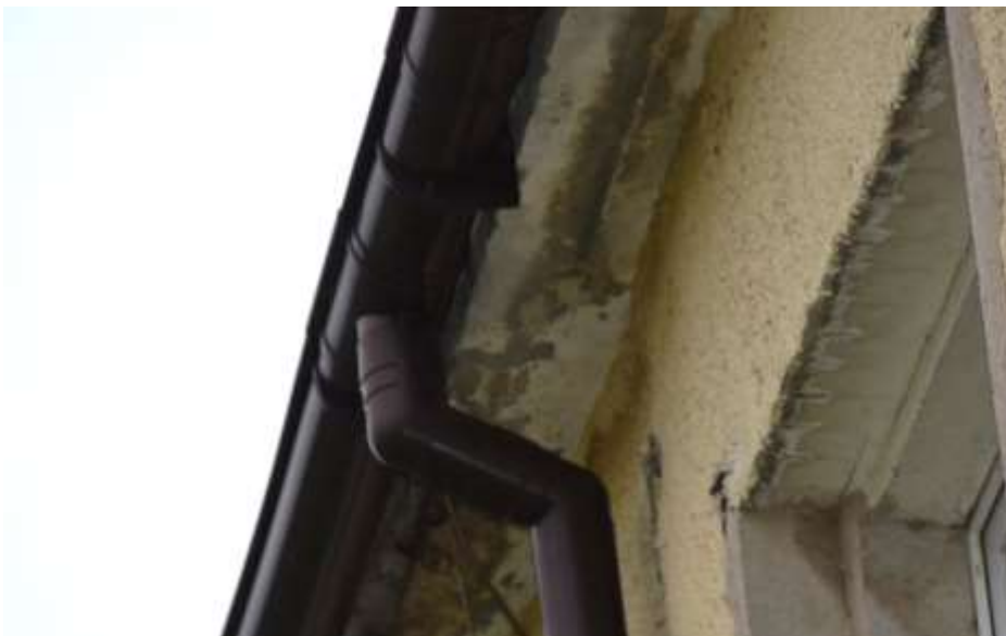
Fot. 262. Fragment elewacji zachodniej: rynny i rury spustowe z PCV;
