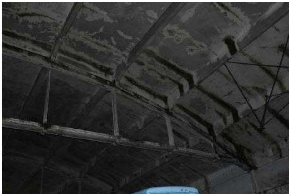
Fot. 201. Fragment dźwigara w osi III-III: od strony północnej z zaciekami; na powierzchni rozwój kolonii glonów;
