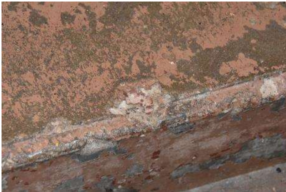
Fot. 186. Fragment biegu schodowego: stopnie betonowe; malowane; lokalnie uszkodzenia mechaniczne;
