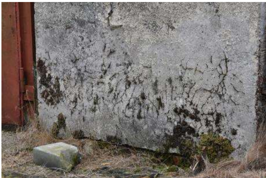
Fot. 308: Fragment elewacji północnej: filarki zawilgocone w dolnej części; na powierzchni wegetacja mchów i porostów;
