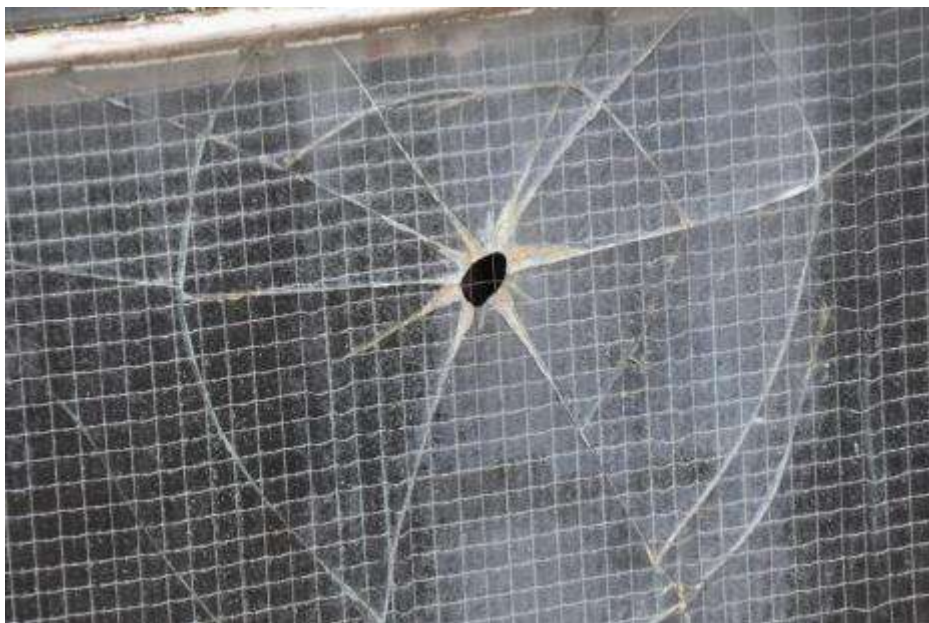
Fot. 388: Fragment elewacji południowej: szkło zbrojone; liczne otwory w szybach;
