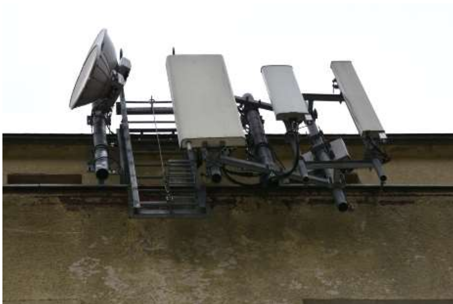
Fot. 365: Fragment elewacji wschodniej: na elewacji zamontowana stacja sieci GSM; - pod stacją zawilgocenia; korozja wyprawy tynkarskiej;
