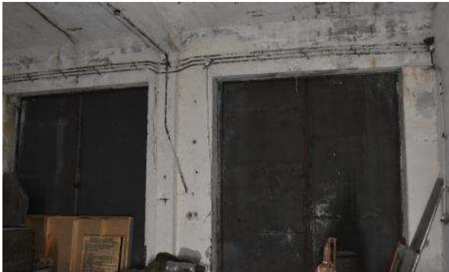
Fot. 123. Fragment ściany zewnętrznej: ściana o konstrukcji szkieletowej; w górnej części belka żelbetowa; na filarze między bramami widoczny słup żelbetowy; wypełnienie murowane z cegły; tynkowane;
