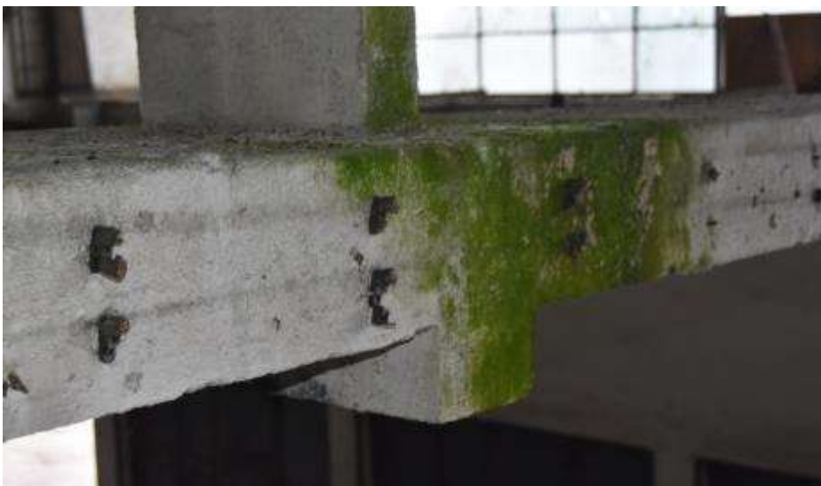
Fot. 203. Fragment dźwigara w osi III-III: dźwigar łukowy, dwuteowy ze ściągiem - zacieki i rozwój kolonii glonów w miejscu połączenia wieszaka z łukiem dźwigara;
