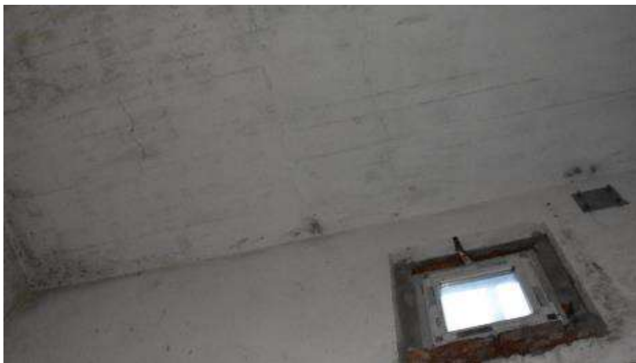
Fot. 245. Fragment stropodachu nad IV piętrem: nad klatką schodową prowadzącą na dach wykonana płyta żelbetowa; złuszczenia warstw malarskich na suficie;
