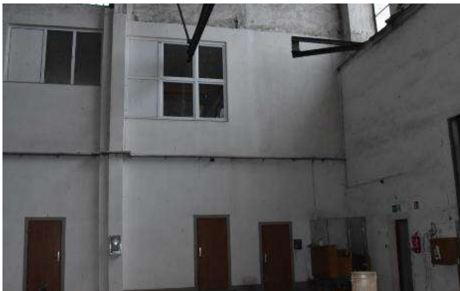
Fot. 95. Fragment ściany zewnętrznej: dwa otwory okienne w poziomie I piętra po obu stronach słupa w osi pierwszej od południa; w poziomie przyziemia i I piętra tynki wykonane w ostatnim okresie;
