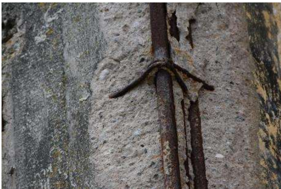
Fot. 392: Fragment elewacji południowej: odsłonięte zbrojenie prętami \varnothing 30 mm; strzemiona z prętów \varnothing 8 mm w rozstawie co 35-40 cm;
