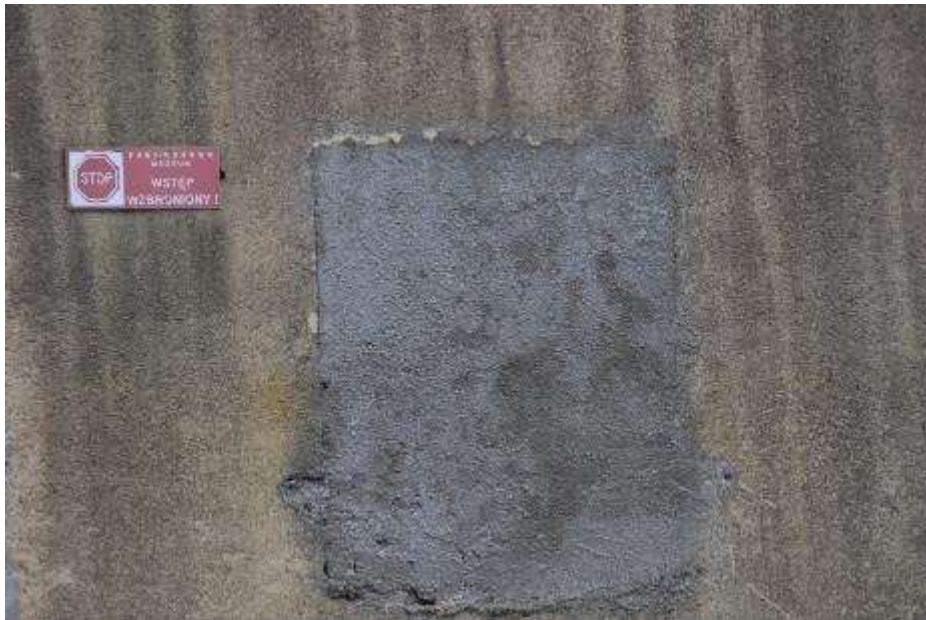
Fot. 273: Fragment elewacji zachodniej: skrajny otwór okienny od strony południowej zamurowany;
