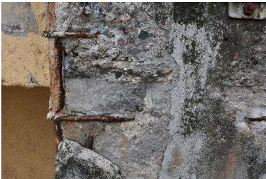
Fot. 398: Fragment elewacji południowej: strzemiona z prętów \varnothing 12 mm w rozstawie co 20 cm;
