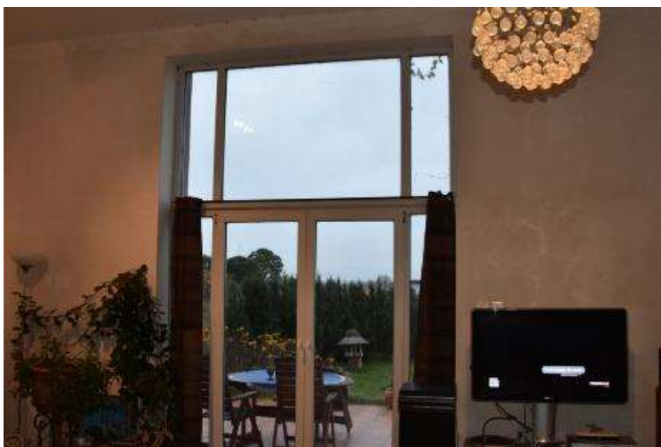
Fot. 154. Fragment ściany zewnętrznej: ściana tynkowana i malowana; po pracach remontowych; w ścianie otwór; stolarka plastikowa - drzwiowy na taras z naświetlem;
