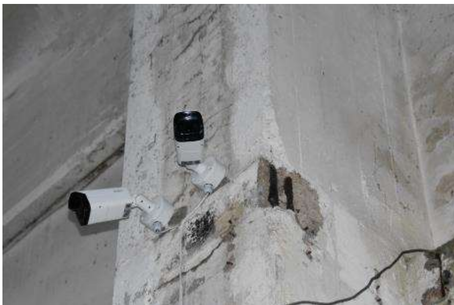
Fot. 53. Fragment ściany zewnętrznej: w górnej części ubytek otuliny; odsłonięte pręty powierzchniowo skorodowane;
