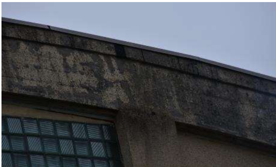
Fot. 355: Fragment elewacji wschodniej: belka wieńcząca z licznymi zaciekami; korozja; złuszczenia wyprawy tynkarskiej;
