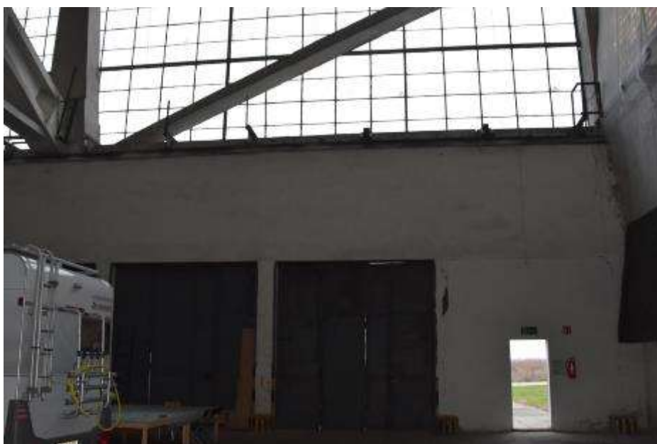
Fot. 1. Fragment ściany zewnętrznej: przy osi B-B otwór drzwiowy; w miejscu zamurowanej bramy;
