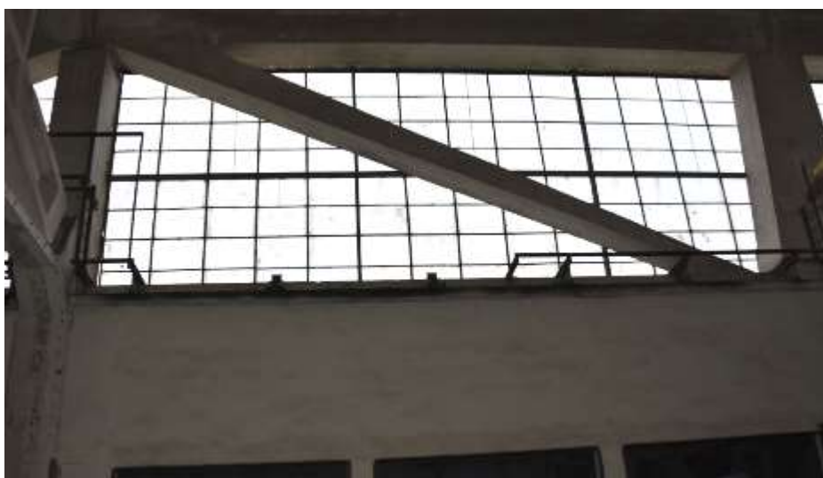
Fot. 7. Fragment ściany zewnętrznej: w dolnej części bramy garażowe; w górnej części kratownica żelbetowa; pomiędzy słupem w osi III a dźwigarem II krzyżulec;
