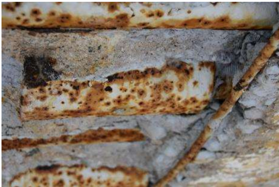
Fot. 410: Fragment elewacji południowej: w rejonie połączenia widoczny gwint;
