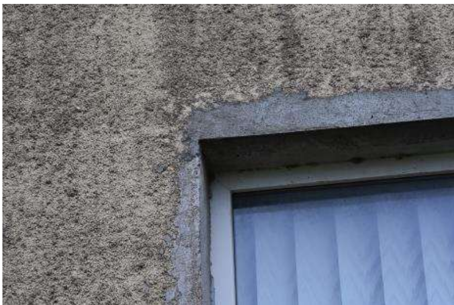
Fot. 278: Fragment elewacji zachodniej: wokół otworów okiennych uzupełnienia zaprawą cementową;
