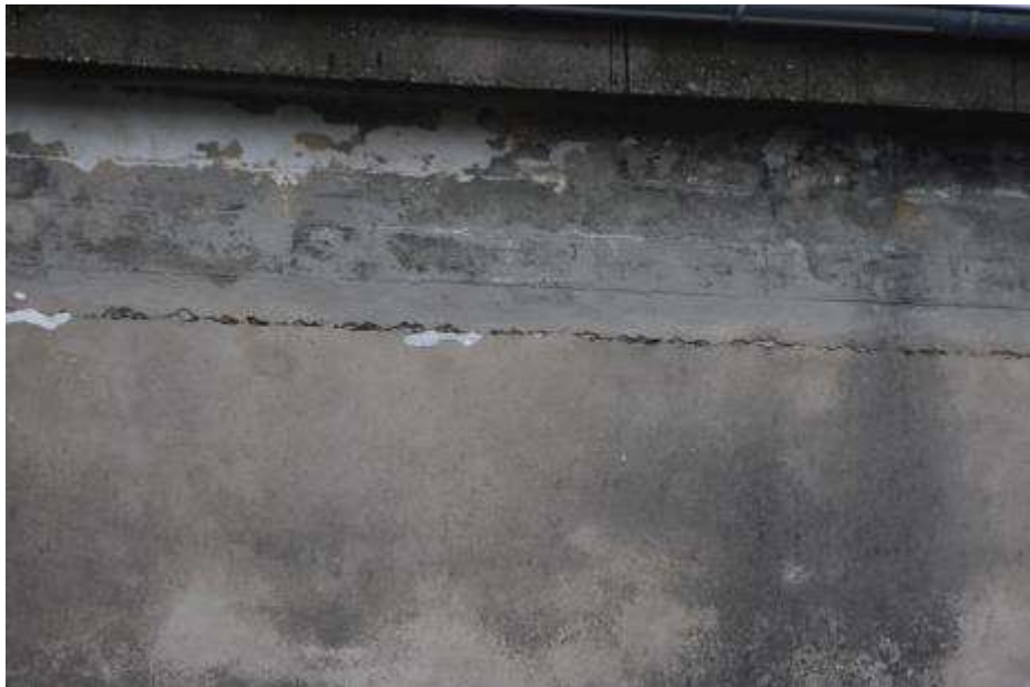
Fot. 319: Fragment elewacji północnej: zachowane tynki skorodowane; z licznymi zaciekami;
