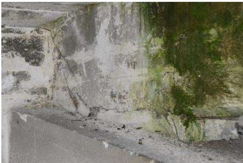
Fot. 208. Fragment dźwigara w osi III-III: węzeł łączący płatew pod stropem z górnym pasem łuku i płatwią w osi 4 z południa; połączenie spękanе; na półce luzne odpryski otuliny;
