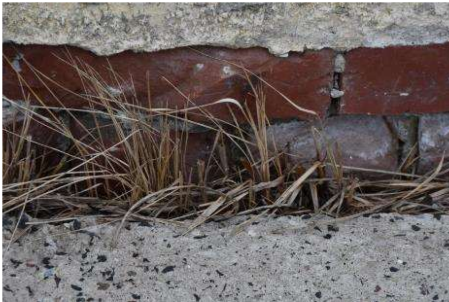
Fot. 425: Fragment elewacji południowej: przy elewacji opaska betonowa; w szczelinie pomiędzy opaską a ścianą wegetacja roślin trawiastych;
