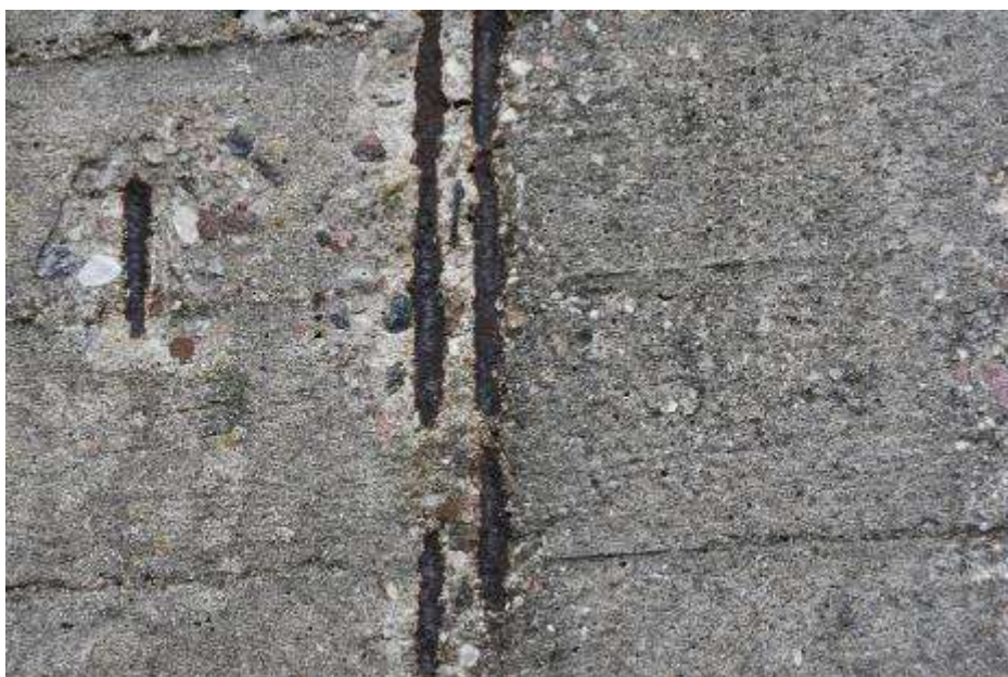
Fot. 414: Fragment elewacji południowej: lokalnie odsłonięte strzemiona;
