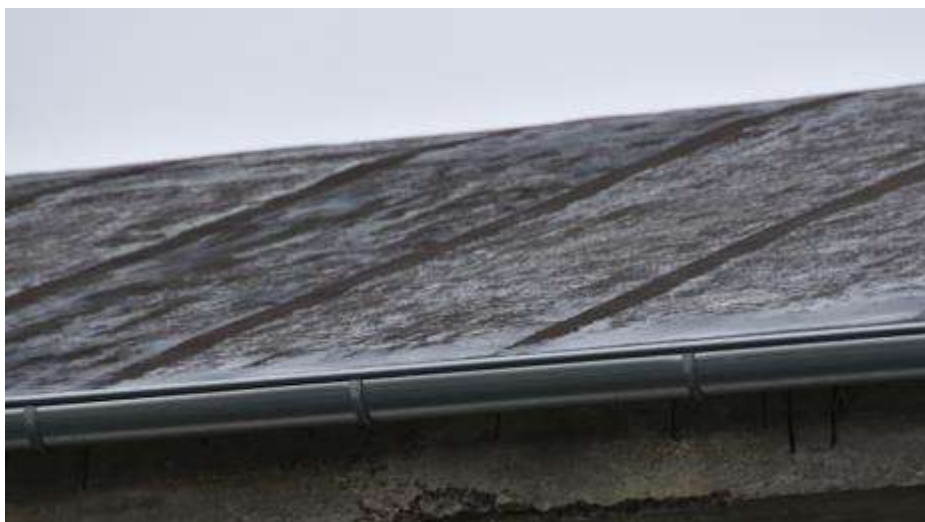
Fot. 255. Fragment pokrycia budynku „E”: pokrycie skorodowane
