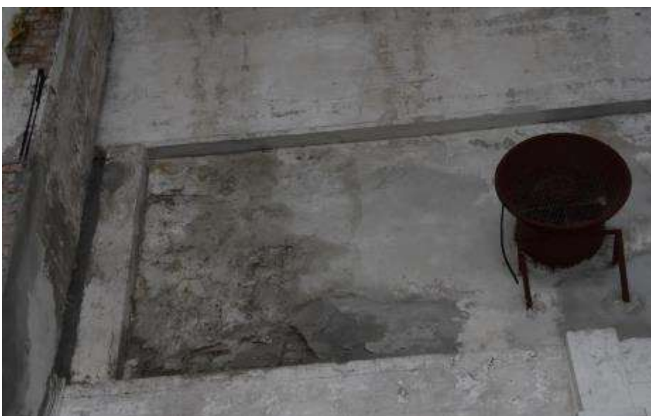
Fot. 38. Fragment ściany zewnętrznej: wypełnienie pomiędzy słupkami w polu przy kominie silnie zawilgocone;
