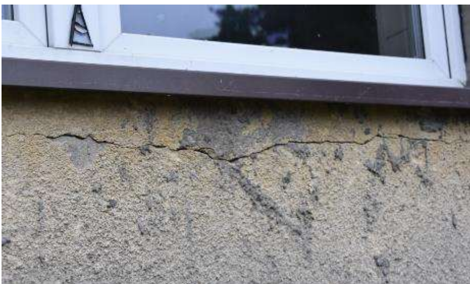
Fot. 342: Fragment elewacji wschodniej: pęknięcie pod parapetem;
