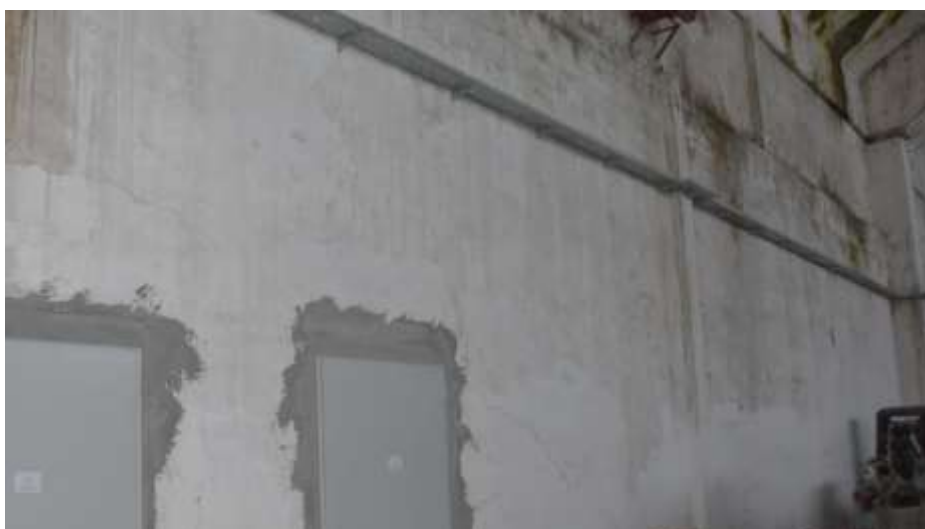
Fot. 63. Fragment ściany zewnętrznej: ściana wypełniająca murowana z cegły ceramicznej; tynkowana; przy ścianie pilaster żelbetowy o szerokości 26 cm;
