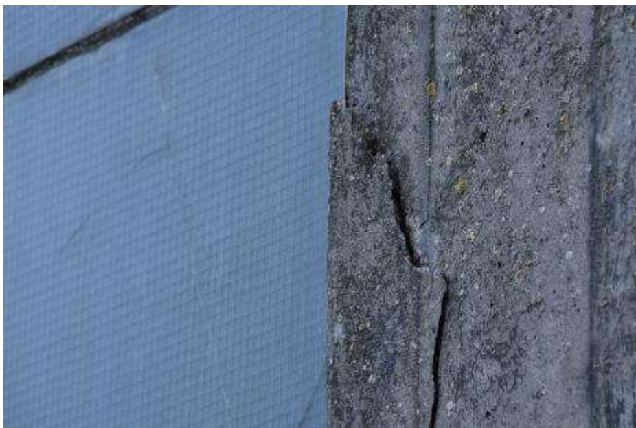
Fot. 399: Fragment elewacji południowej: odspojenie otuliny w górnej części słupa;
