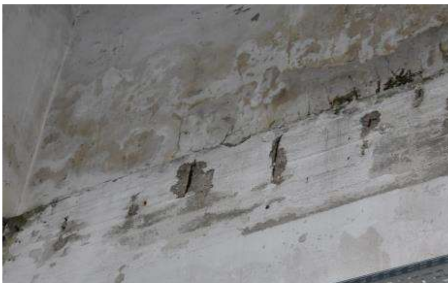
Fot. 57. Fragment ściany zewnętrznej: odspojona otulina strzemion belki żelbetowej; odsłonięte zbrojenie skorodowane;
