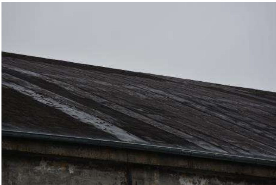
Fot. 253. Fragment dachu nad hangarem: na odcinku od dźwigara w osi III-III ściany w osi B-B pokrycie z papy asfaltowej na lepiku;
