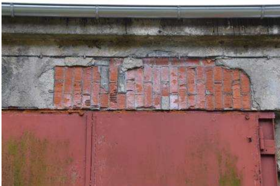
Fot. 309: Fragment elewacji frontowej: rozległy ubytek tynku na nadprożu bramy w osi szóstej od zachodu; uszkodzenia lica cegły;
