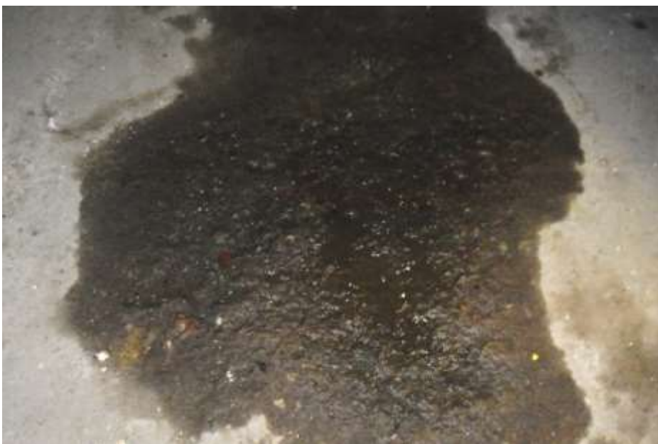
Fot. 229. Fragment płyty dachowej: lokalnie zacieki na posadzce hangaru;
