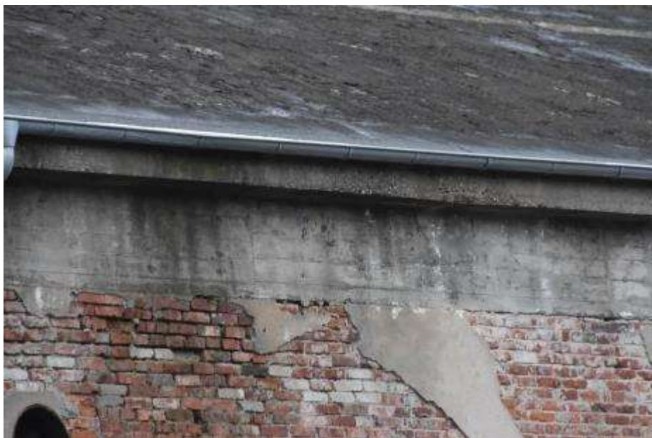
Fot. 321: Fragment elewacji północnej: belka wieńcząca żelbetowa; z zaciekami;
