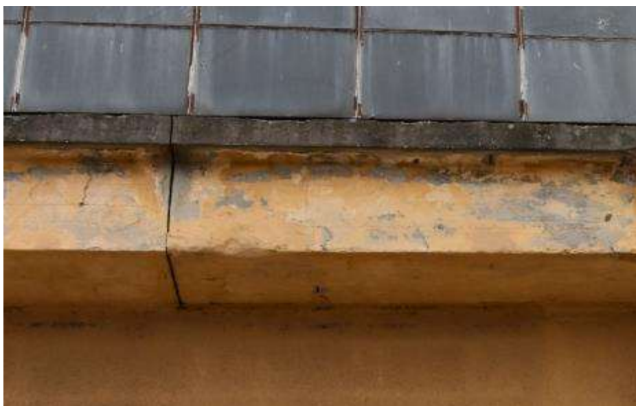
Fot. 400: Fragment elewacji południowej: pas dolny kratownicy o wysokości łącznej 85 cm i szerokości 90 cm; w górnej części belki poszerzenie o 21 cm na wysokość 21 cm;
