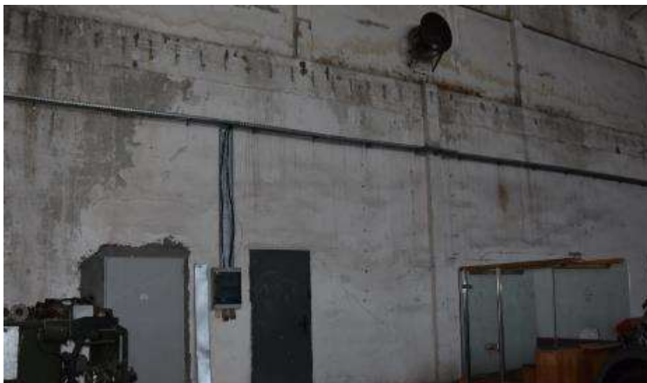
Fot. 78. Fragment ściany zewnętrznej: ściana wypełniająca murowana z cegły ceramicznej; tynkowana; przy ścianie pilaster żelbetowy o szerokości 26 cm;
