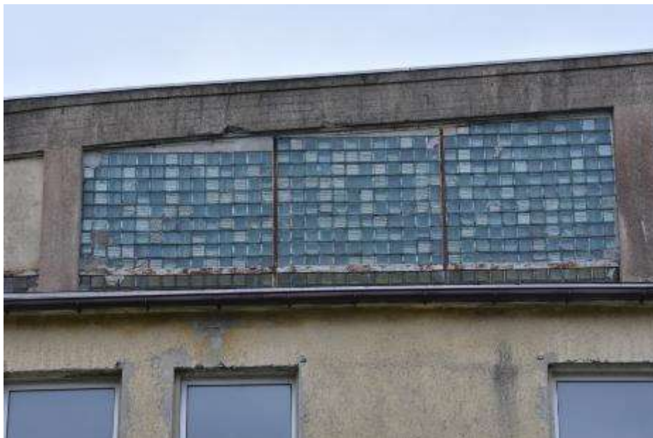
Fot. 290: Fragment elewacji zachodniej: wypełnienie luksferami;
