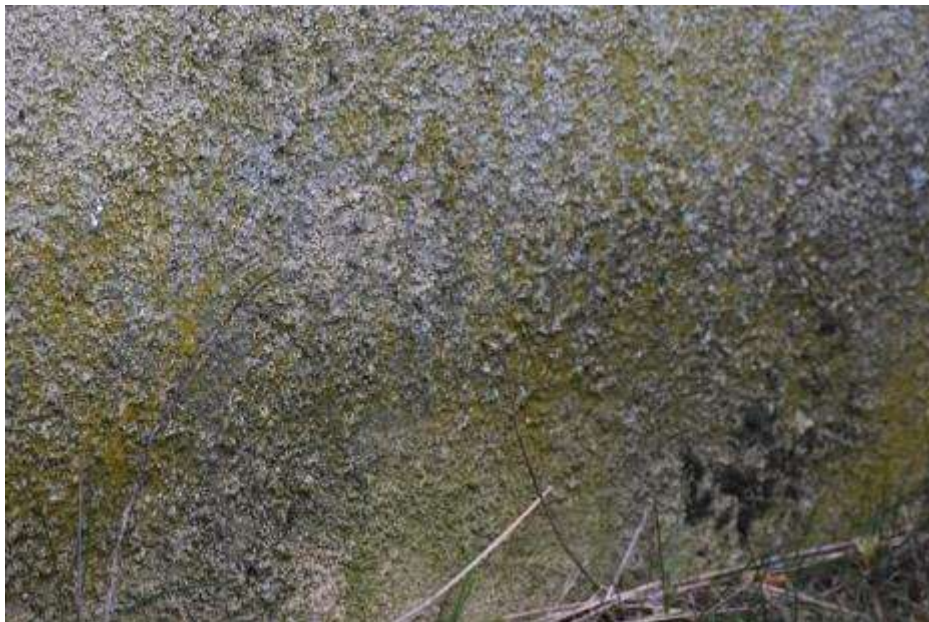
Fot. 359: Fragment elewacji wschodniej: w dolnej części ściana zawilgocona; na powierzchni wegetacja kolonii glonów;
