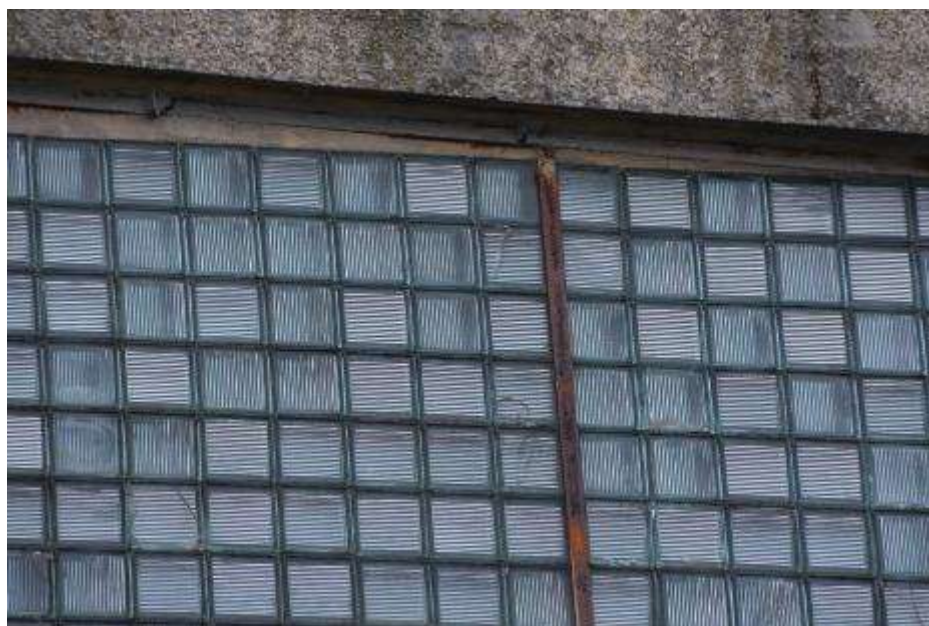
Fot. 354: Fragment elewacji wschodniej: wypełnienie luksferami;
