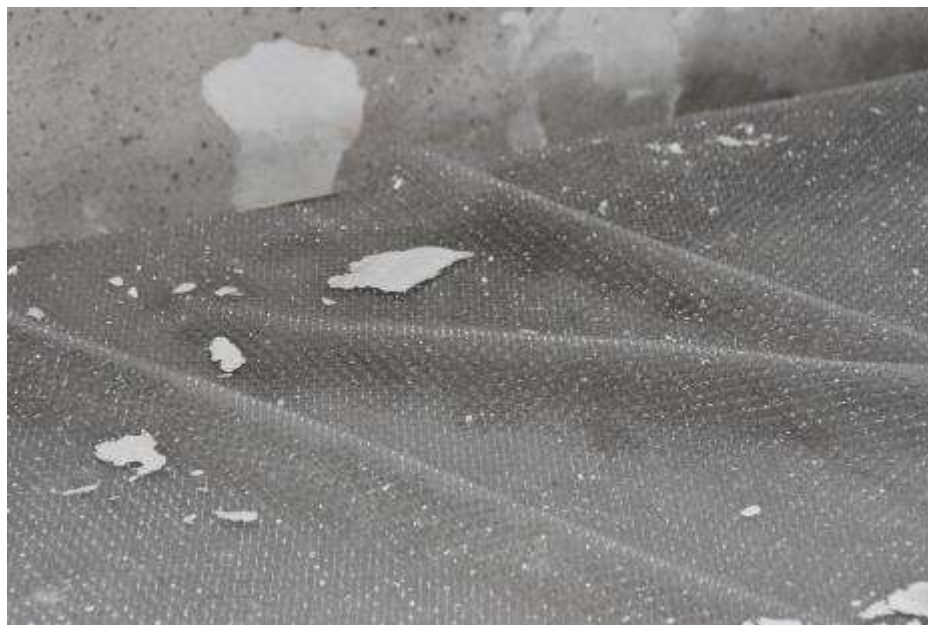
Fot. 44. Fragment ściany zewnętrznej: złuszczone fragmenty zalegają na posadce; - ciemne zacieki w górnej części ściany;
