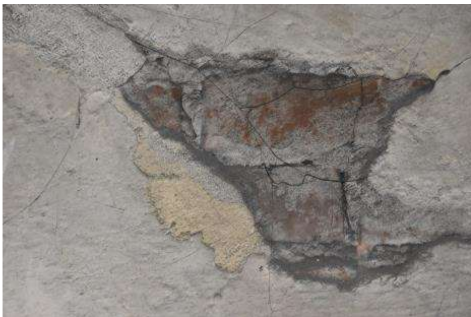
Fot. 143. Fragment ściany wewnętrznej: ściana szkieletowa z wypełnieniem murowanym z cegły ceramicznej; tynkowana; tynk skorodowany; odspojony od podłoża; spękany;
