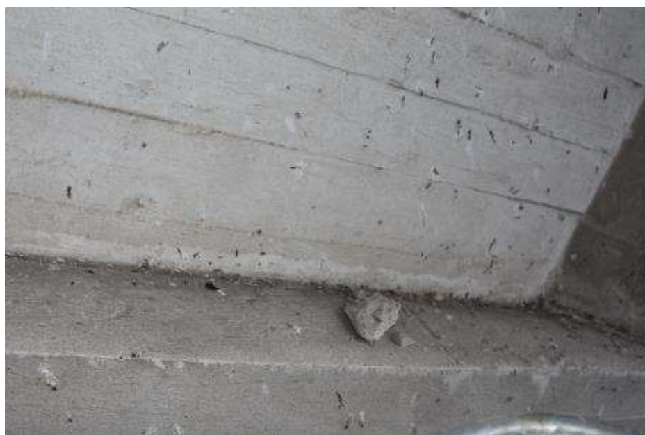
Fot. 213. Fragment dźwigara w osi III-III: odspojone fragmenty betonu zalegają na dolnej półce łuku;
