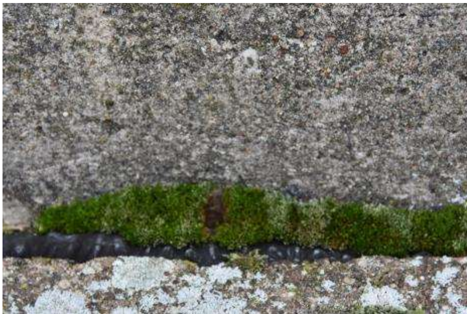
Fot. 420: Fragment elewacji południowej: przy szczelinie wegetacja mchów;
