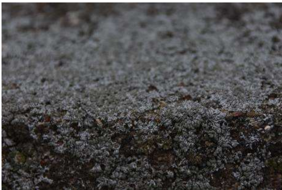
Fot. 422: Fragment elewacji południowej: na powierzchni gzymsu wegetacja porostów;
