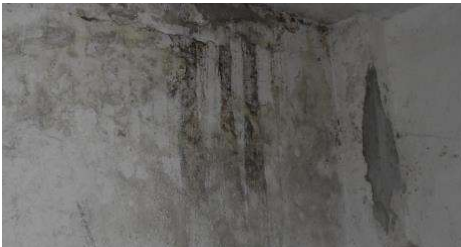
Fot. 152. Fragment ściany zewnętrznej: na ścianie rozległe zacieki; tynk skorodowany; złuszczenia warstwy licowej; na powierzchni ciemne naloty;
