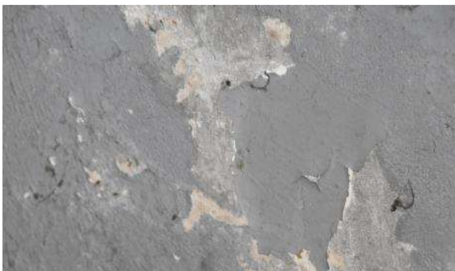
Fot. 131. Fragment ściany zewnętrznej: ściana zawilgocona; tynk skorodowany;
