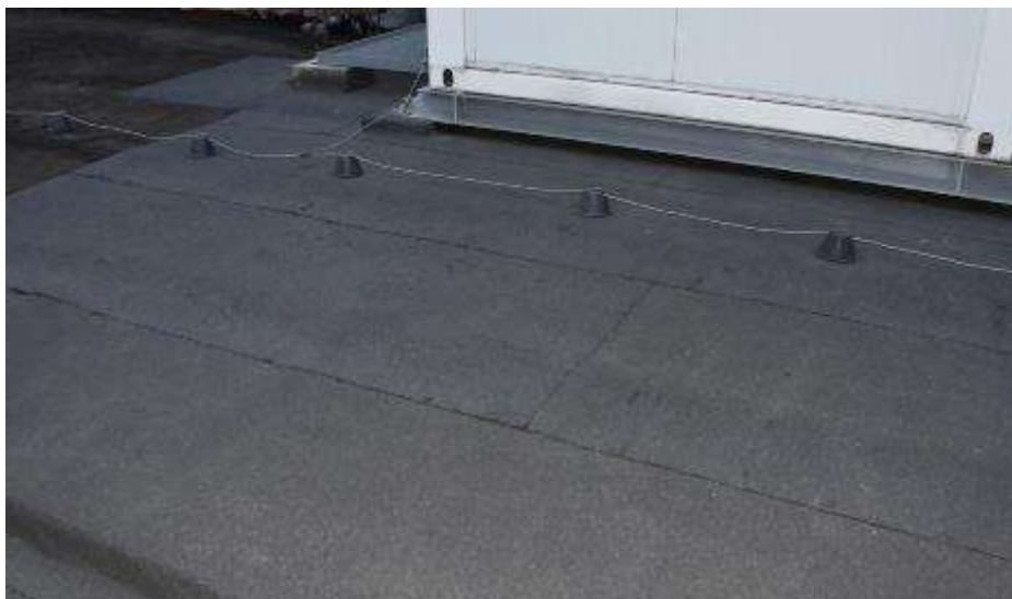
Fot. 260. Fragment dachu nad III piętrem: w obrębie stacji pokrycie wymienione; papa termozgrzewalna;
