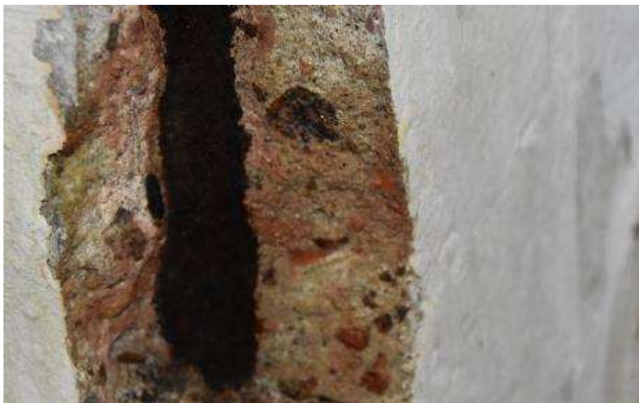
Fot. 62. Fragment ściany zewnętrznej: po przeprowadzeniu badania kontrolnego karbonatyzacji stwierdzono brak ochrony betonu przed korozją;
