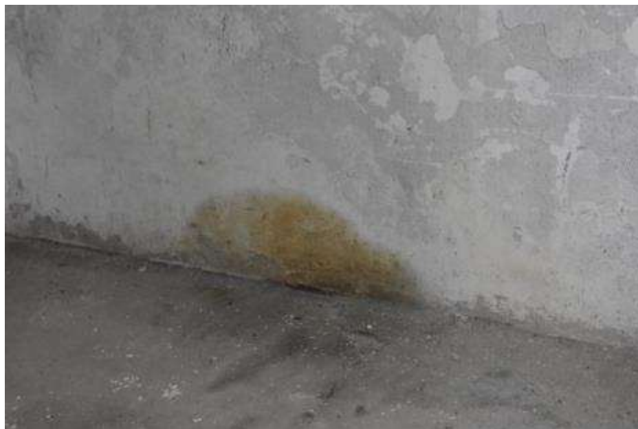
Fot. 55. Fragment ściany zewnętrznej: ściana zawilgocona w dolnej części;
