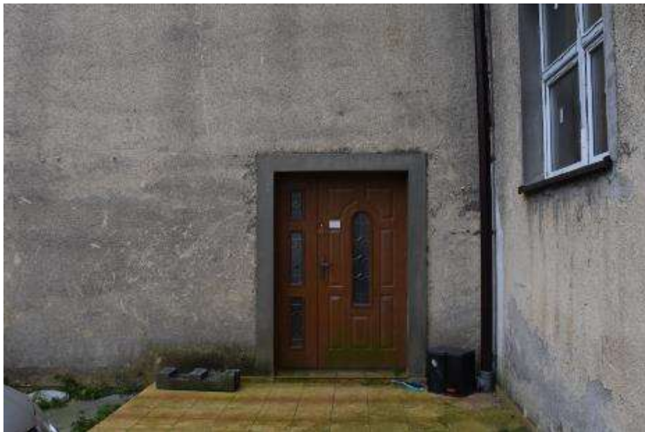
Fot. 327: Fragment elewacji północnej: w poziomie parteru otwór drzwiowy; ujęty opaską wykonaną w tynku;
