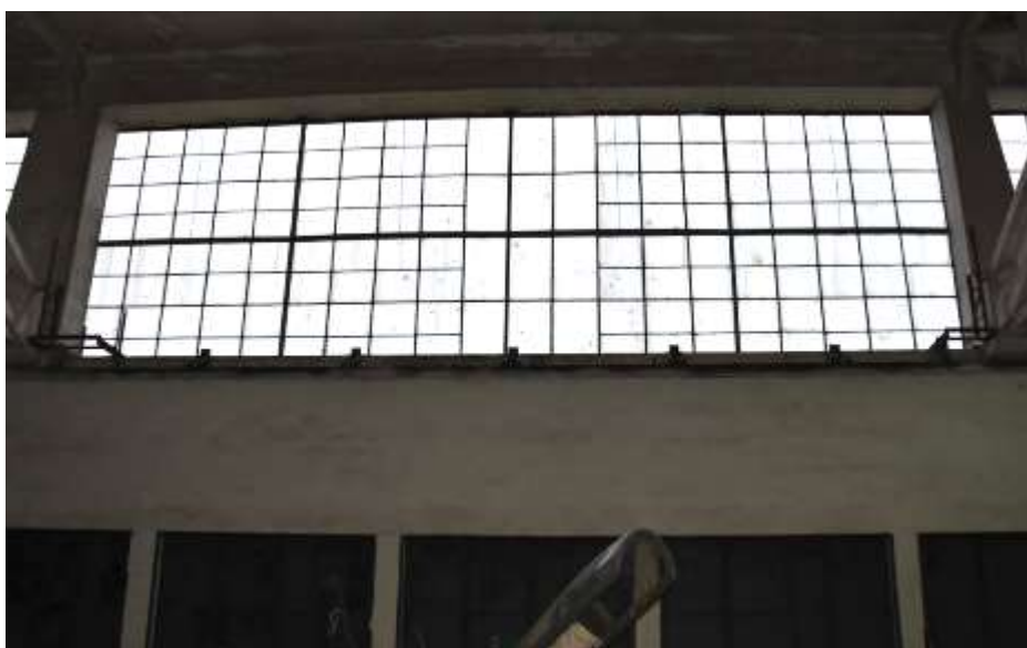
Fot. 5. Fragment ściany zewnętrznej: w dolnej części bramy garażowe; powyżej dolnej belki żelbetowej kratownicy elewacja szklana;
