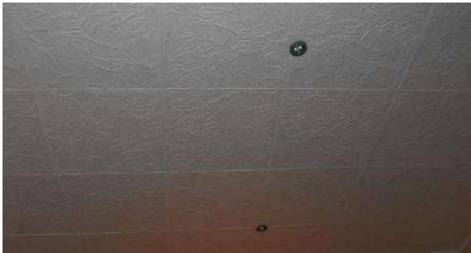
Fot. 177. Fragment stropu nad parterem: w pomieszczeniu nr 13 sufit podwieszony; na suficie styropianowe kasetony;
