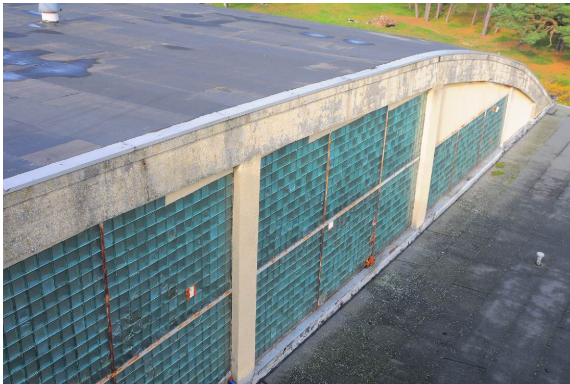
6.5 Widok dachu – część łukowa wraz z obróbką, elewacja wschodnia (do remontu).
