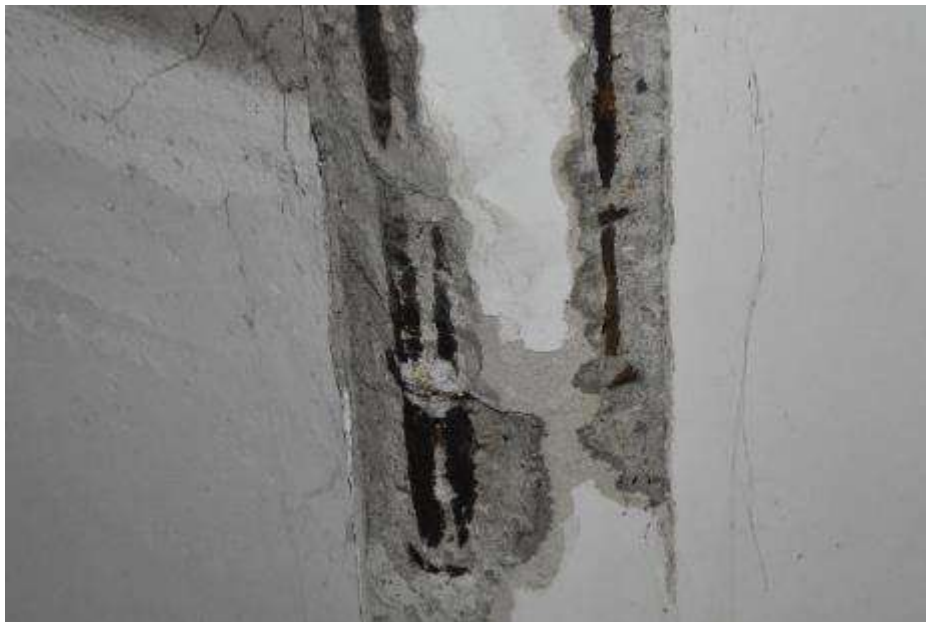
Fot. 188. Fragment biegu schodowego: spoczniki monolityczne; lokalnie brak otuliny prętów belki spocznika między I i II piętrem;
