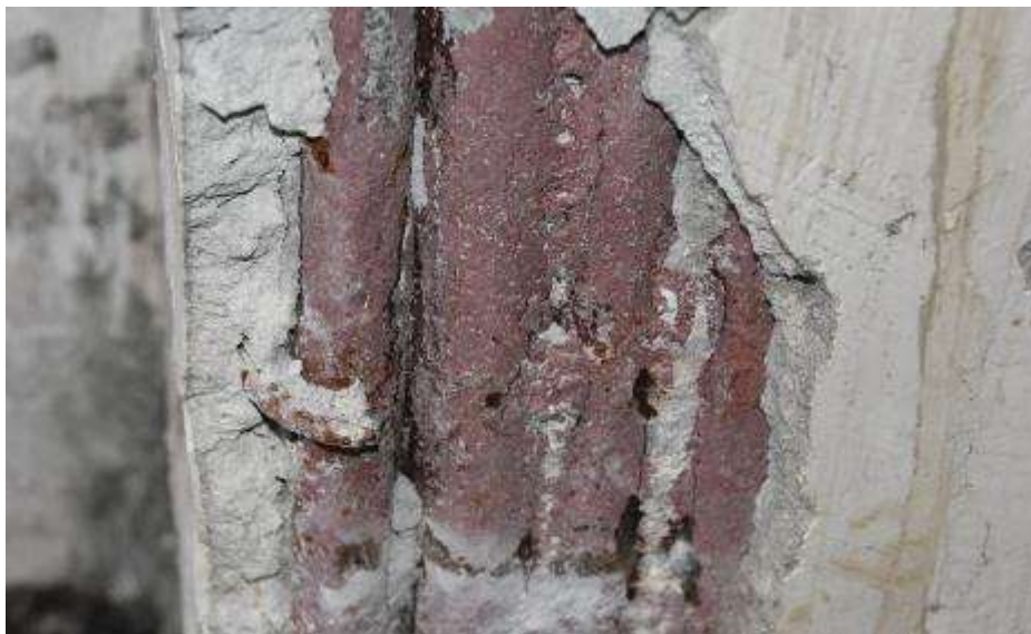
Fot. 19. Fragment ściany zewnętrznej: po wykonaniu odkrywki odsłonięte zbrojenie skorodowane;
