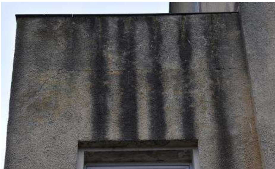
Fot. 370: Fragment elewacji wschodniej: nad otworem okiennym ciemne naloty;
