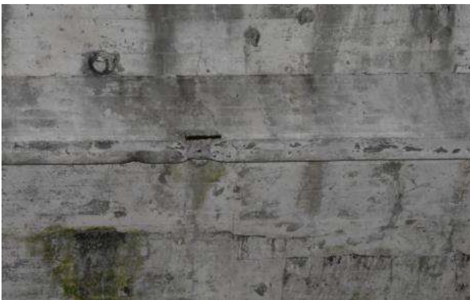
Fot. 223. Fragment płyty dachowej: liczne zarysowania płyty; lokalnie płatew z odsłoniętym zbrojeniem; pręt powierzchniowo skorodowany;
