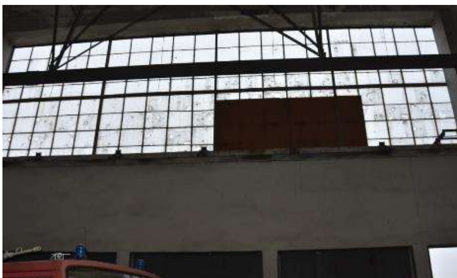
Fot. 15. Fragment ściany zewnętrznej: powyżej dolnej belki żelbetowej kratownicy elewacja szklana; liczne otwory w szybach;
