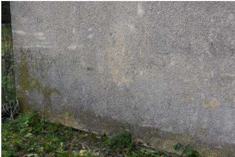
Fot. 329: Fragment elewacji północnej: w dolnej części ściana zawilgocona;
