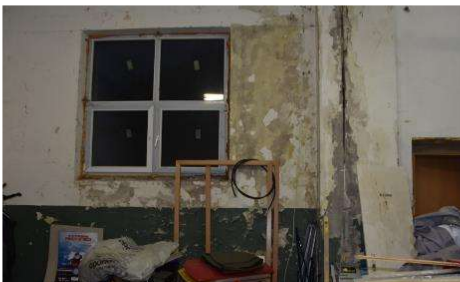
Fot. 135. Fragment ściany zewnętrznej: ściana zawilgocona; tynk skorodowany; odspojony; złuszczenia warstw malarskich;
