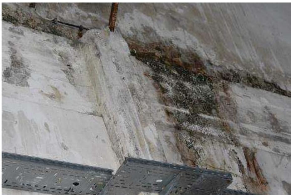
Fot. 59. Fragment ściany zewnętrznej: rozległe zacieki w rejonie pilastra;
