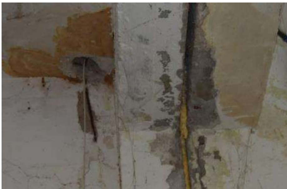
Fot. 176. Fragment stropu nad parterem: na suficie dylatacja; zdwojone żebra;
