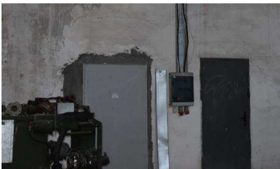
Fot. 79. Fragment ściany zewnętrznej: w rejonie otworów liczne zarysowania; - zarysowania wypełnienia w rejonie otworów drzwiowych;
