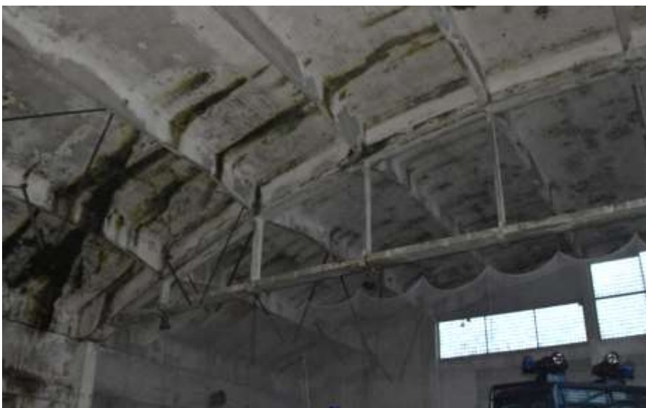
Fot. 219. Fragment dźwigara w osi V-V: dźwigar żelbetowy; od strony północnej z zaciekami na powierzchni;
