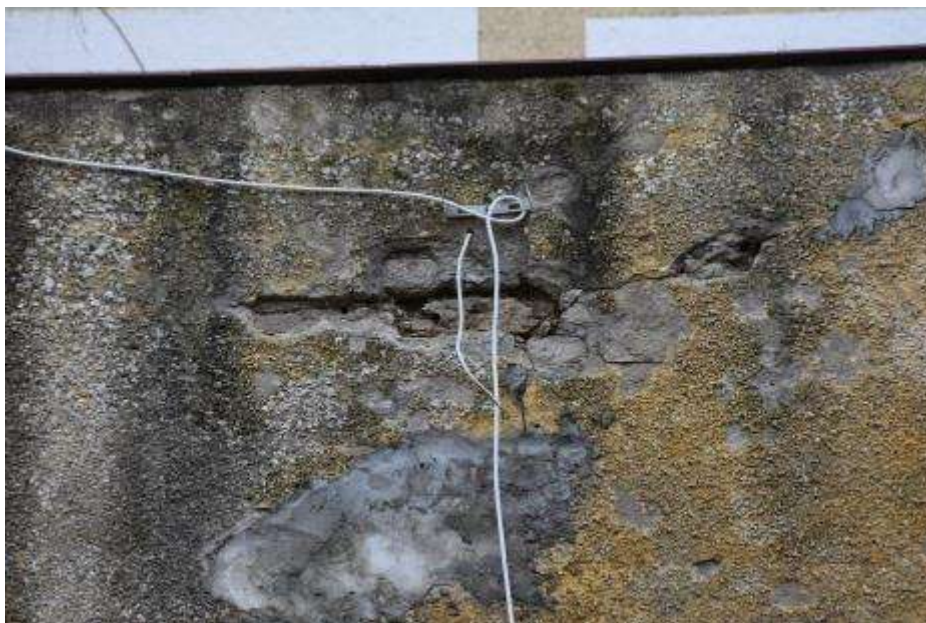
Fot. 376: Fragment elewacji południowej: lokalnie ubytki tynku;
