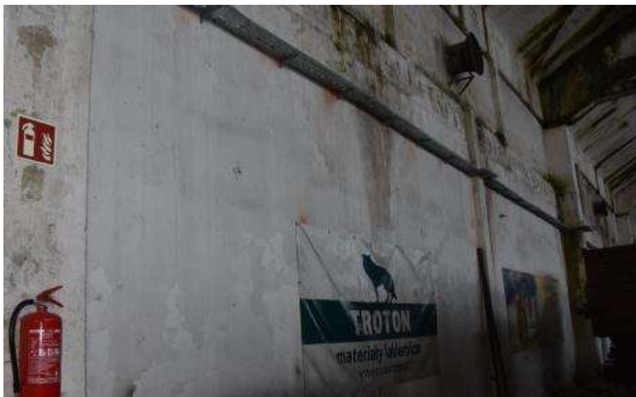
Fot. 54. Fragment ściany zewnętrznej: ściana wypełniająca murowana z cegły ceramicznej; tynkowana; przy ścianie pilaster żelbetowy o szerokości 26 cm;
