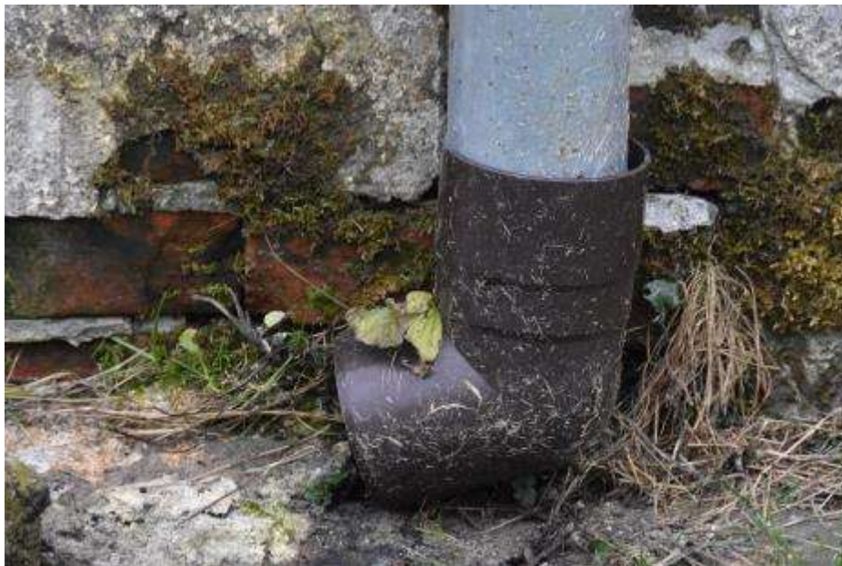
Fot. 267. Fragment elewacji północnej: rura spustowa na filarze jedenastym od zachodu zakończona kolanem; woda odprowadzona bezpośrednio na teren;
