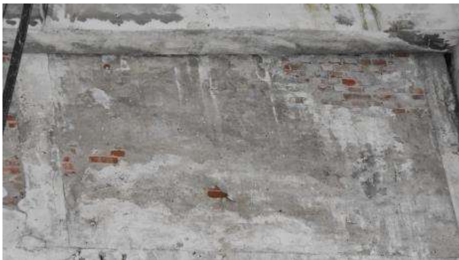
Fot. 97. Fragment ściany zewnętrznej: w górnej części ubytki wyprawy; odsłonięta cegła powierzchniowo skorodowana;
