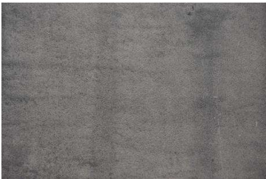
Fot. 328: Fragment elewacji północnej: tynk z warstwą zewnętrzną tzw. „barankiem”; na powierzchni zacieki;
