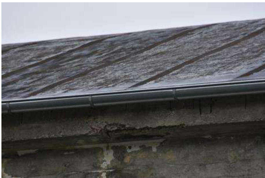
Fot. 322: Fragment elewacji północnej: ściana zwieńczona wysuniętym gzymsem żelbetowym; lokalnie ubytki otuliny prętów
