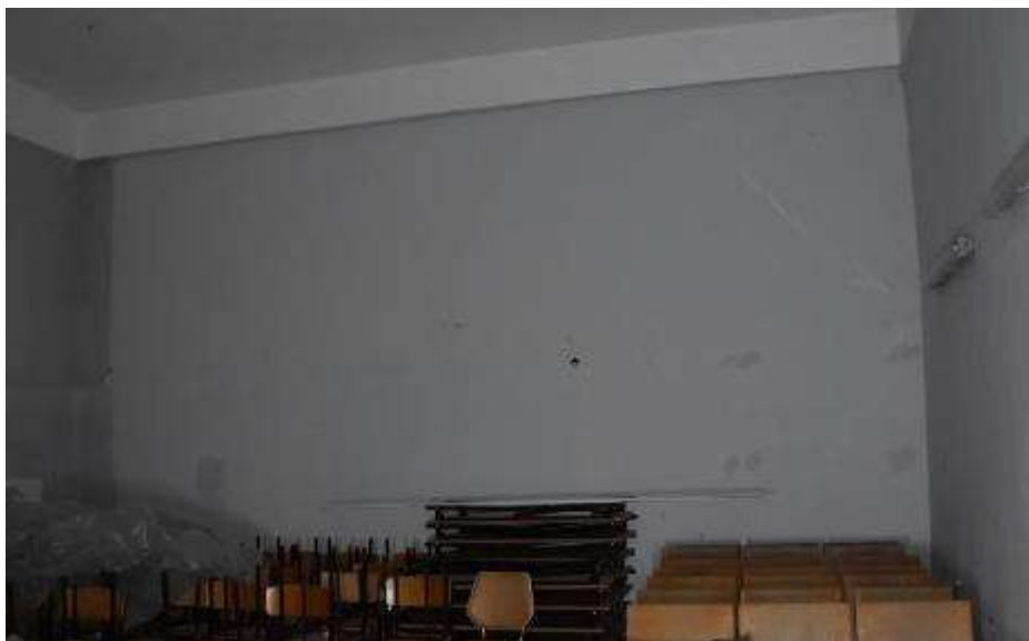
Fot. 116. Fragment ściany wewnętrznej: ściana tynkowana i malowana; wymurowana pod żebrem;
