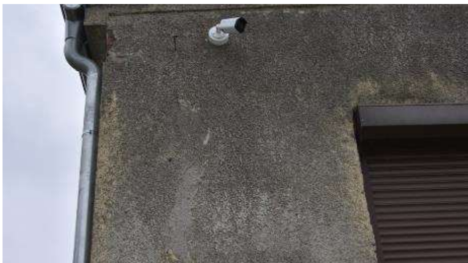
Fot. 297: Fragment elewacji zachodniej: przy narożniku od strony północnej pionowe zarysowanie w górnej części ściany;
