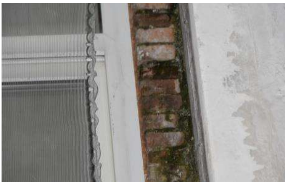
Fot. 24. Fragment ściany zewnętrznej: ściana wypełniająca pomiędzy słupami murowana z cegły ceramicznej;
