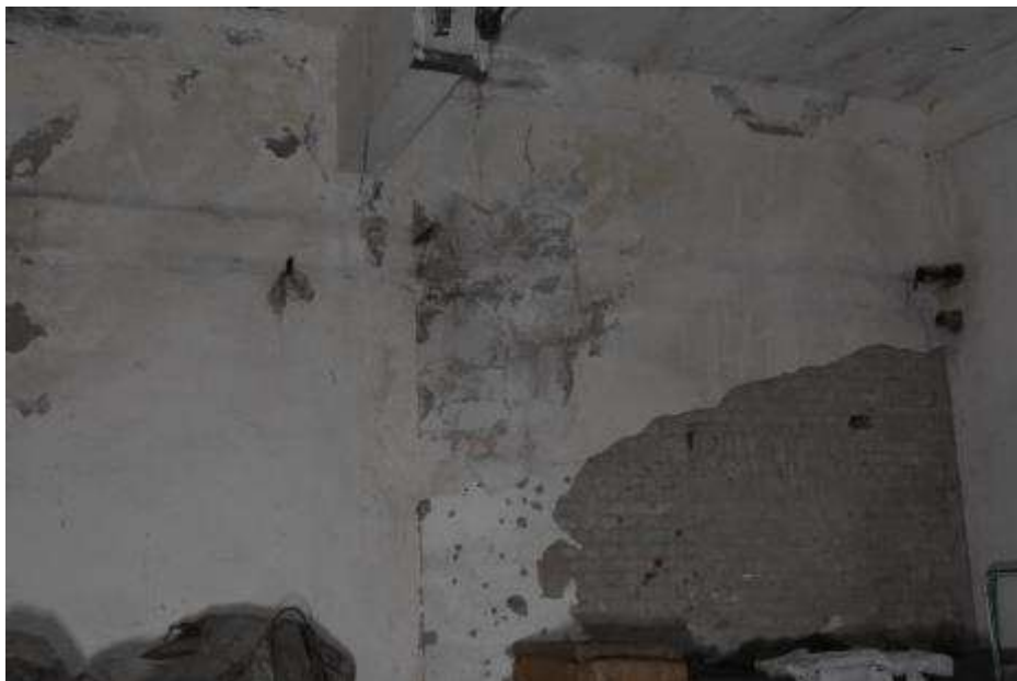
Fot. 86. Fragment ściany wewnętrznej: od strony garażu nr G7 ściana wypełniająca murowana z cegły ceramicznej; pierwotnie tynkowana; w ścianie zamurowany otwór;
