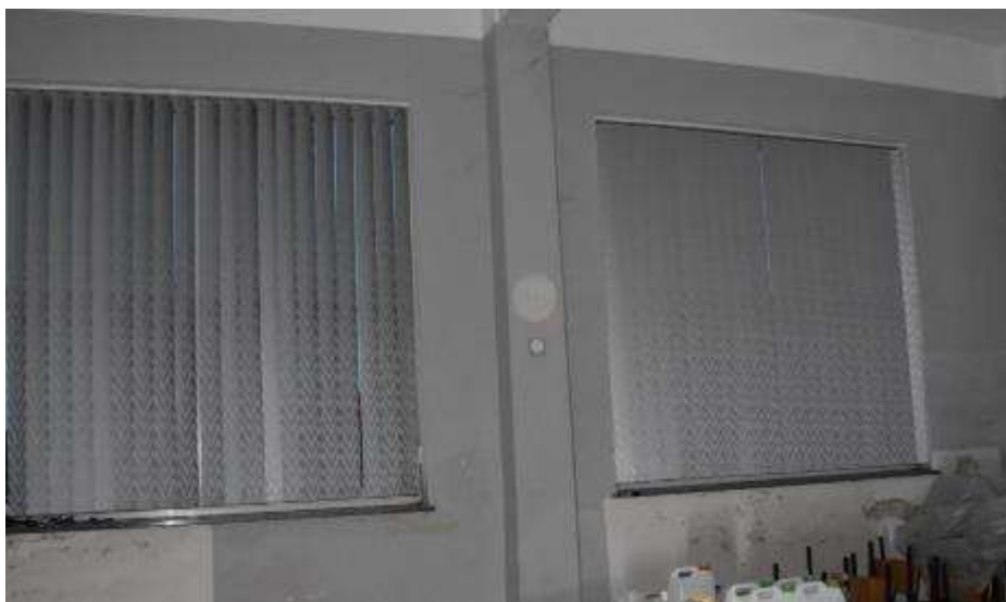
Fot. 103. Fragment ściany zewnętrznej: ściana o konstrukcji szkieletowej; wypełnienie murowane i tynkowane; po pracach modernizacyjnych; w ścianie 2 otwory okienne; stolarka plastikowa;
