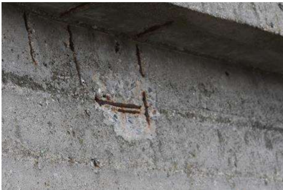
Fot. 416: Fragment elewacji południowej: ubytki betonu; odsłonięte zbrojenie skorodowane;
