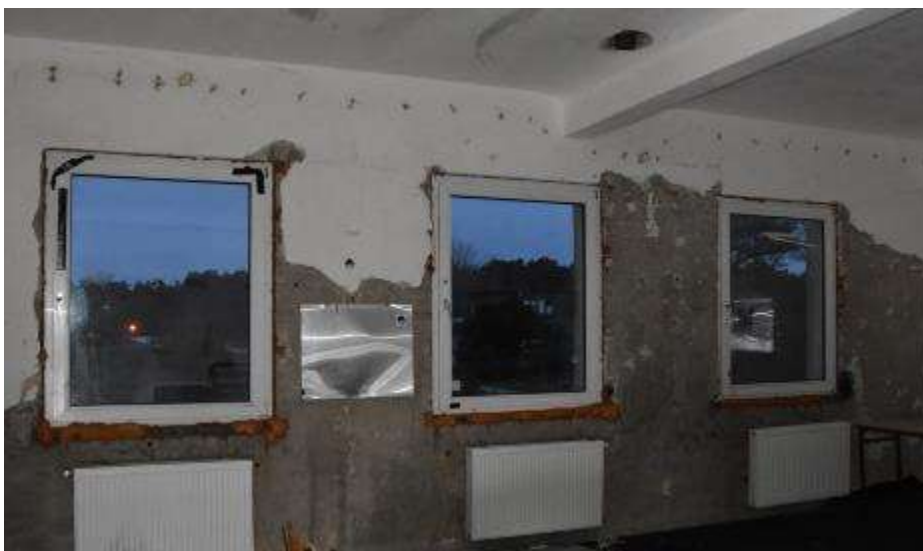
Fot. 109. Fragment ściany zewnętrznej: ściana o konstrukcji szkieletowej, wypełnienie murowane i tynkowane;
