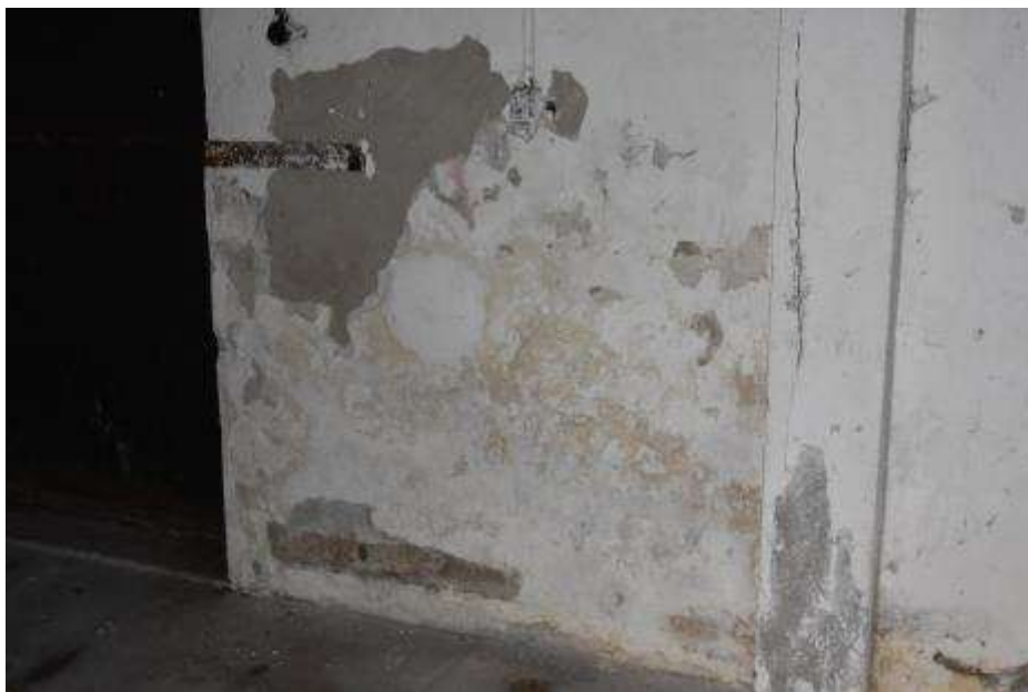
Fot. 121. Fragment ściany zewnętrznej: w dolnej części ściana zawilgocona; wyprawy tynkarskie skorodowane; odspojone; we fragmentach złuszczenia warstwy zewnętrznej tynku;
