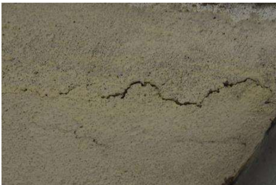
Fot. 286: Fragment elewacji zachodniej: na podniebieniu tynk odspojony; zarysowania;
