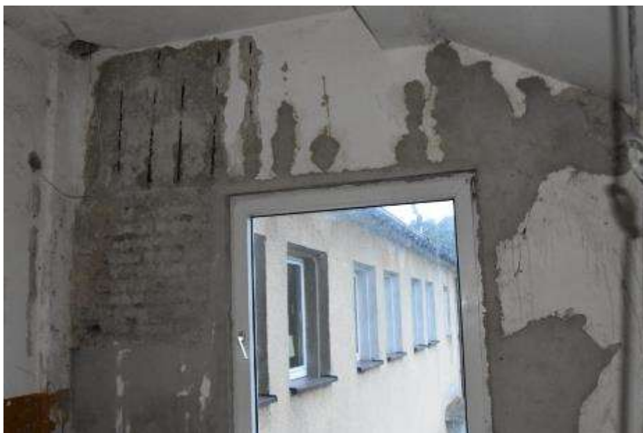
Fot. 162. Fragment ściany zewnętrznej: ściana tynkowana; rozległe ubytki wypraw; ślady napraw; w górnej części belka żelbetowa; odspojona otulina strzemion;
