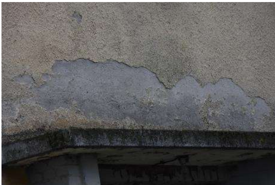
Fot. 349: Fragment elewacji wschodniej: korozja tynku w partii nad zadaszeniem wejścia;
