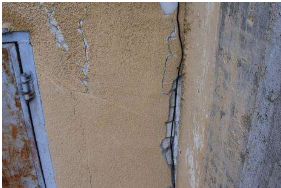
Fot. 386: Fragment elewacji południowej: ściany wypełniające oddylatowane od słupów;
