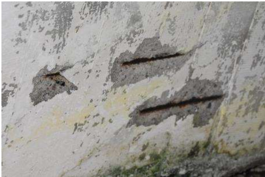
Fot. 228. Fragment płyty dachowej: lokalnie brak otuliny prętów płyty; zbrojenie prętami o średnicy \varnothing 8 mm;
