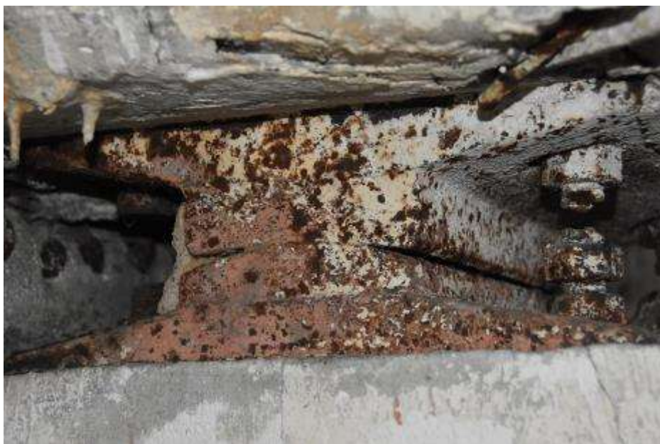
Fot. 220. Fragment dźwigara w osi V-V: połączenie słupa i dźwigara od strony północnej przegubowe; łożysko stalowe;
