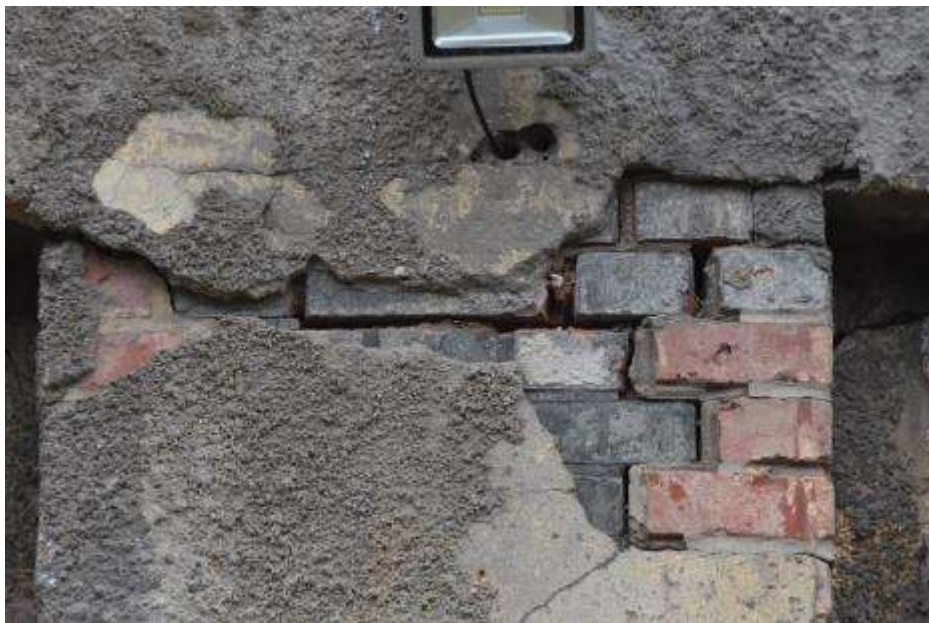
Fot. 307: Fragment elewacji północnej: filarek pomiędzy bramami w osi drugiej i trzeciej od zachodu z poziomym pęknięciem w poziomie nadproży;
