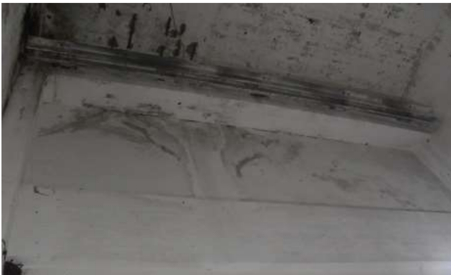
Fot. 111. Fragment ściany zewnętrznej: o konstrukcji szkieletowej; przy ścianie słup żelbetowy; wypełnienie murowane i tynkowane; ślady zacieków na powierzchni tynku;
