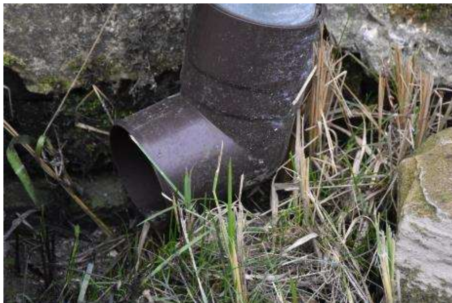
Fot. 266. Fragment elewacji północnej: rura spustowa na filarze ósmym od zachodu zakończona kolaniem; woda odprowadzona bezpośrednio na teren;
