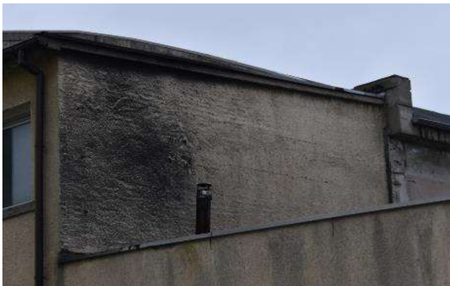
Fot. 325: Fragment elewacji północnej: elewacja tynkowana; warstwa zewnętrzna tzw. „baranek”; na powierzchni ciemne naloty;
