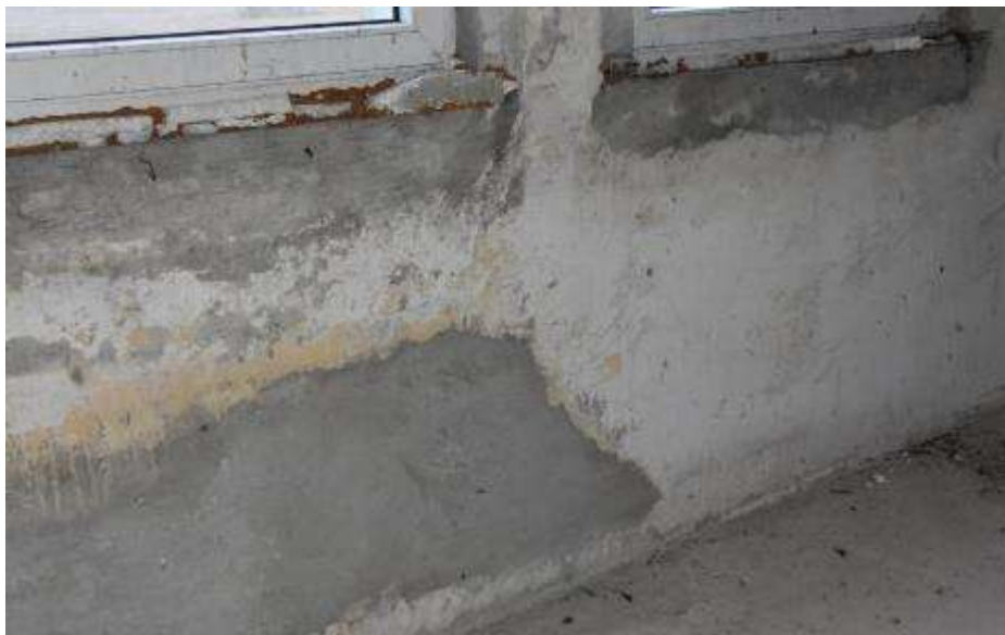
Fot. 160. Fragment ściany zewnętrznej: wyprawy tynkarskie skorodowane; ślady napraw;
