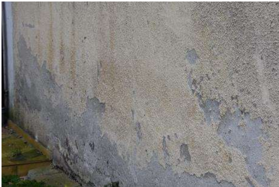
Fot. 339: Fragment elewacji wschodniej: w dolnej części ślady zawilgocenia; tynk skorodowany; ubytki warstwy zewnętrznej;
