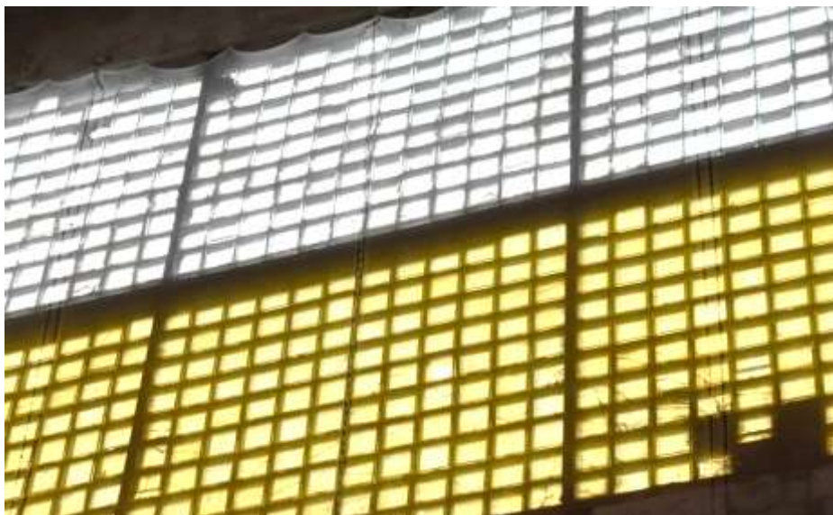
Fot. 29. Fragment ściany zewnętrznej: w górnej części ściany wypełnienie luksferami; ślady uzupełnień uszkodzonych luksferów;
