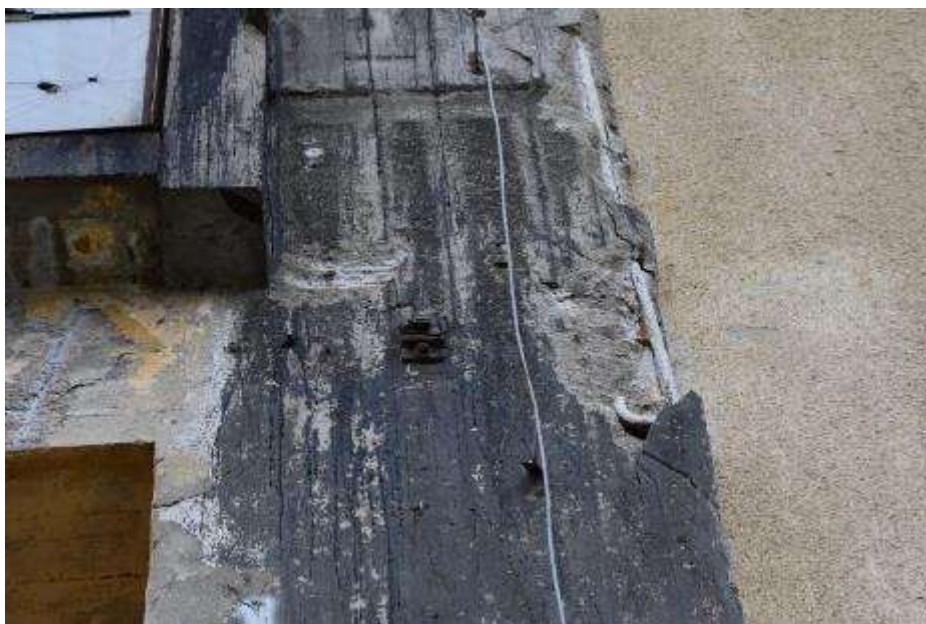
Fot. 394: Fragment elewacji południowej: słup narożny od strony wschodniej z rozległym brakiem otuliny prętów w górnej części;
