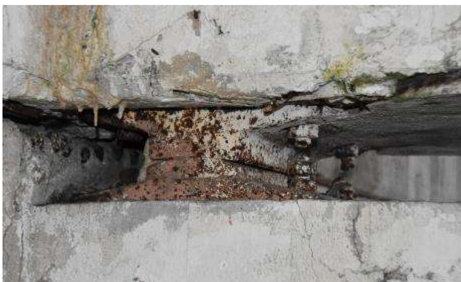
Fot. 77. Fragment ściany zewnętrznej: połączenie słupa i dźwigara przegubowe; łożysko stalowe; powierzchniowa korozja elementów stalowych;
