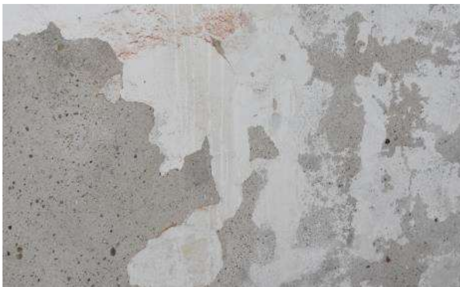
Fot. 43. Fragment ściany zewnętrznej: w miejscu zawilgocenia tynk skorodowany; - złuszczone fragmenty zalegają na posadce;
