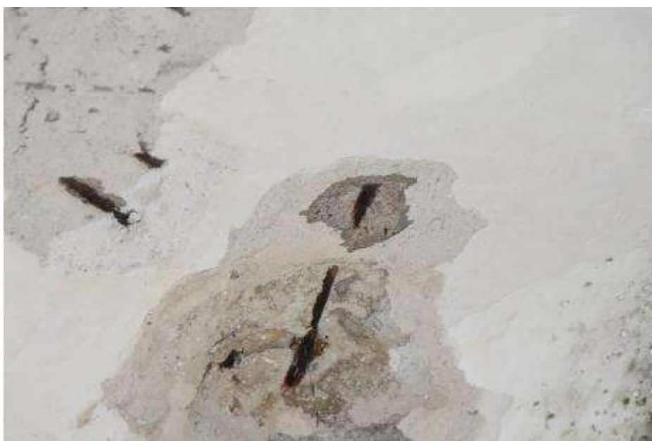
Fot. 235. Fragment stropodachu nad I piętrem: lokalnie odspojenia otuliny prętów płyty; odsłonięte zbrojenie powierzchniowo skorodowane;
