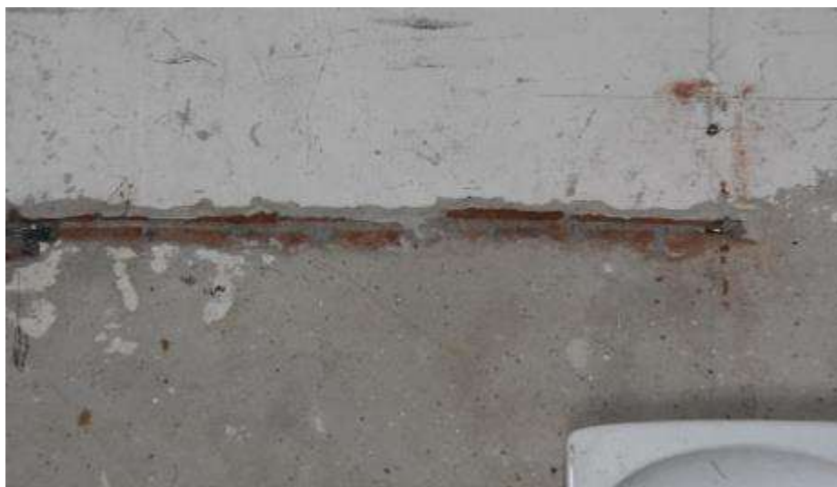
Fot. 110. Fragment ściany zewnętrznej: rozległe uszkodzenia wyprawy
