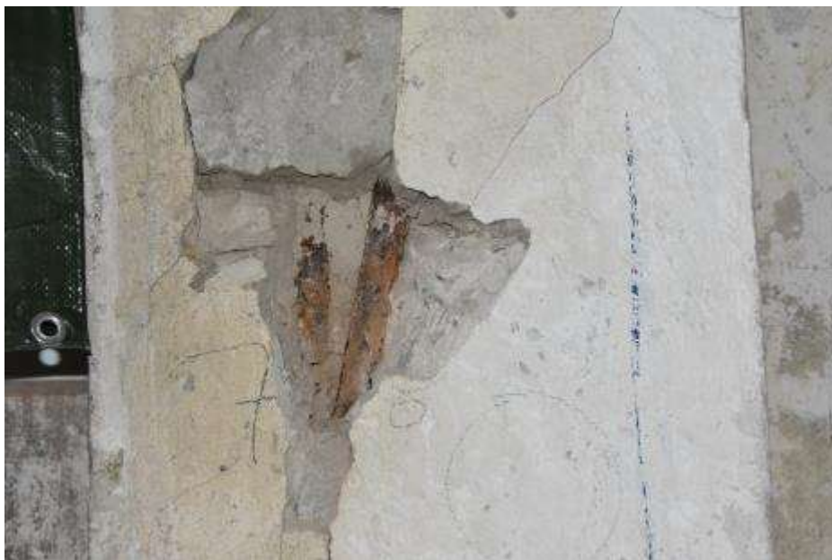
Fot. 23. Fragment ściany zewnętrznej: zbrojenie słupa prętami o średnicy \varnothing 30 mm;
