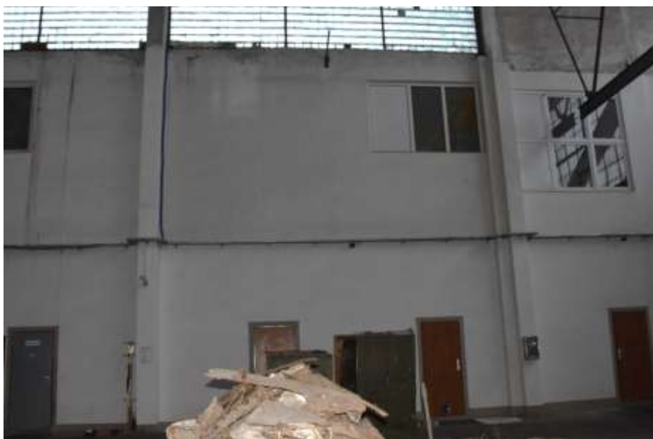
Fot. 88. Fragment ściany zewnętrznej: ściana o konstrukcji szkieletowej; przy ścianie 4 słupy żelbetowe; w poziomie przyziemia i I piętra ściana tynkowana; powyżej wypełnienie z luksferów;
