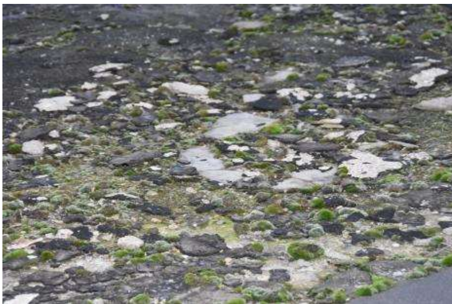
Fot. 248. Fragment dachu nad hangarem: od strony północnej fragment bez nowego pokrycia; szczątki izolacji bitumicznej; na powierzchni dachu rozwój mchów;
