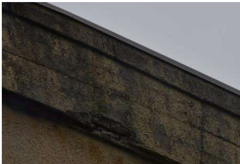
Fot. 356: Fragment elewacji wschodniej: lokalnie ubytki otuliny prętów; od góry ściana zabezpieczona obróbką z blachy;
