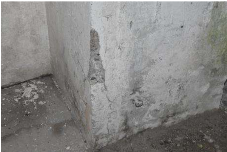
Fot. 51. Fragment ściany zewnętrznej: odspojona otulina w dolnej części słupa;
