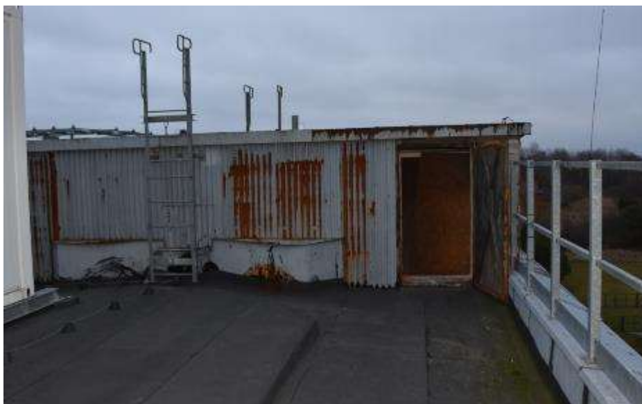
Fot. 258. Fragment nadbudówki: ściana z poszyciem z blachy stalowej; blacha skorodowana;
