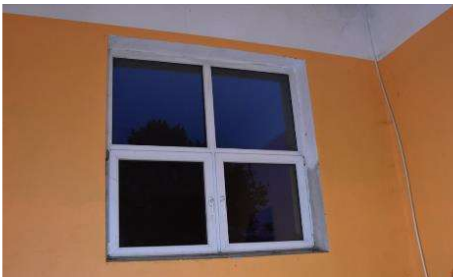
Fot. 134. Fragment ściany zewnętrznej: ściana tynkowana i malowana; po modernizacji; w ścianie otwór okienny;
