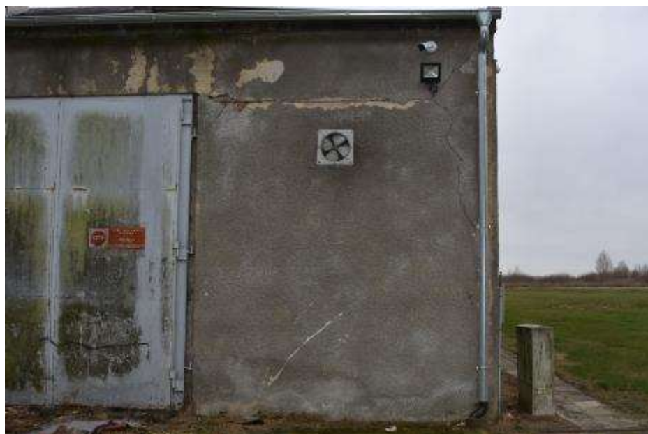
Fot. 300: Fragment elewacji północnej: ściana murowana; tynkowana; warstwa zewnętrzna tzw. „baranek”; przy narożniku północno-zachodnim pęknięcia o zróżnicowanym przebiegu;
