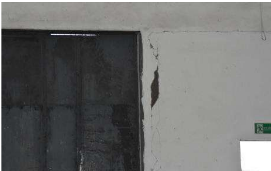
Fot. 2. Fragment ściany zewnętrznej: zarysowanie po obwodzie dawnego otworu bramnego; ubytek tynku przy bramie w osi drugiej od ściany w osi B-B;
