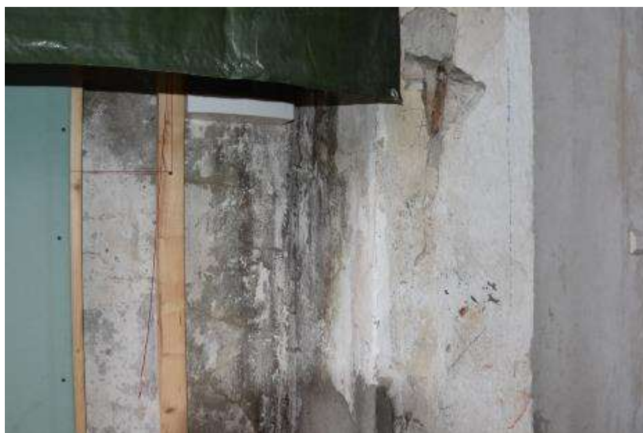
Fot. 26. Fragment ściany zewnętrznej: wyprawy tynkarskie skorodowane; liczne ślady po zaciekach;
