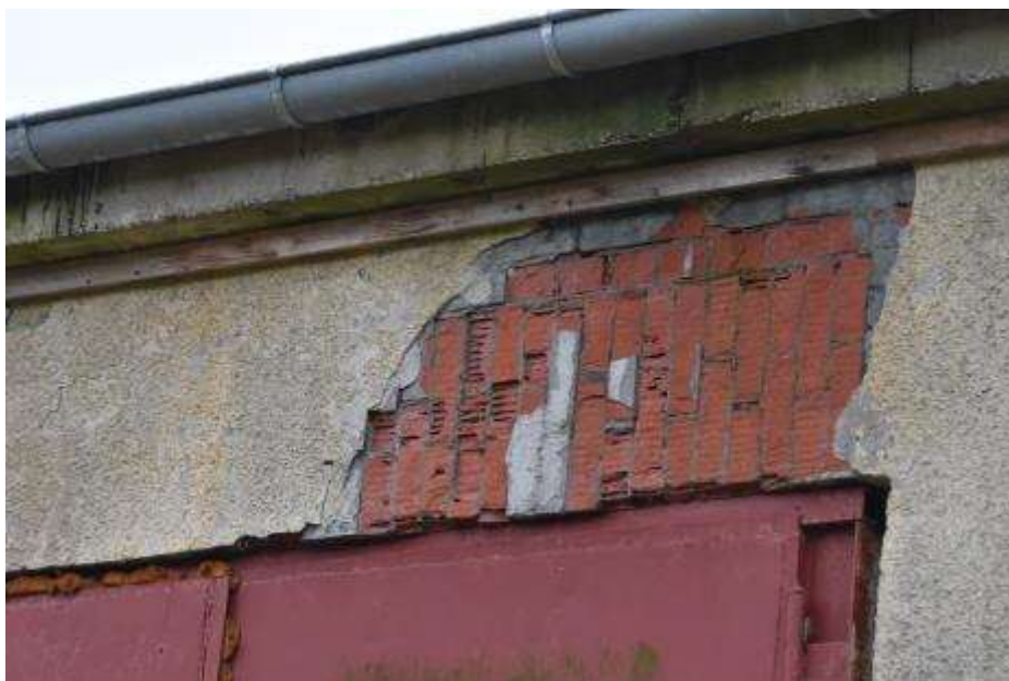
Fot. 311: Fragment elewacji północnej: rozległy ubytek tynku na nadprożu bramy w osi ósmej od zachodu; uszkodzenia lica cegły;
