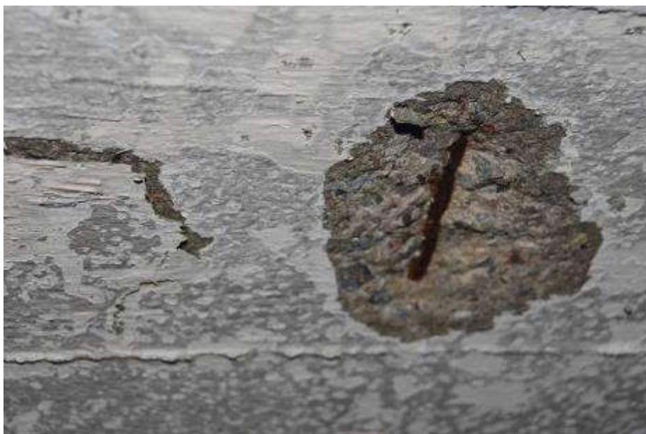
Fot. 209. Fragment dźwigara w osi III-III: otulina grubości 8 mm; odsłonięte zbrojenie powierzchniowo skorodowane;
