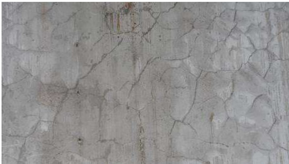
Fot. 68. Fragment ściany zewnętrznej: siatka spękań na powierzchni wyprawy tynkarskiej;
