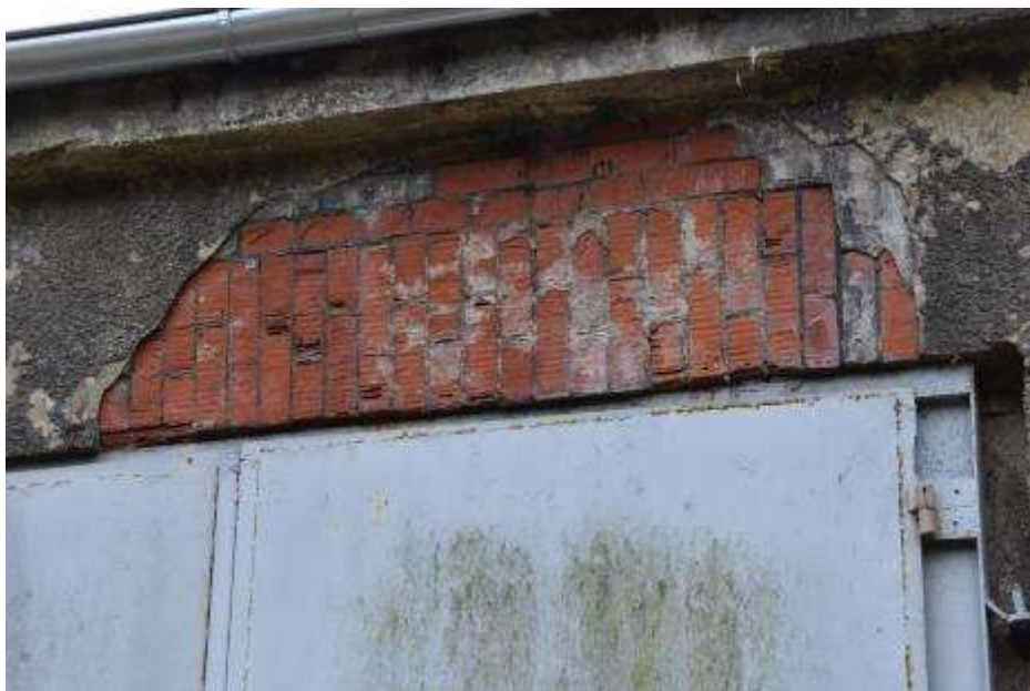
Fot. 305: Fragment elewacji północnej: rozległy ubytek tynku na nadprożu bramy w osi drugiej od zachodu; odsłonięta cegła skorodowana; uszkodzenia lica; cegła ceramiczna drążona;
