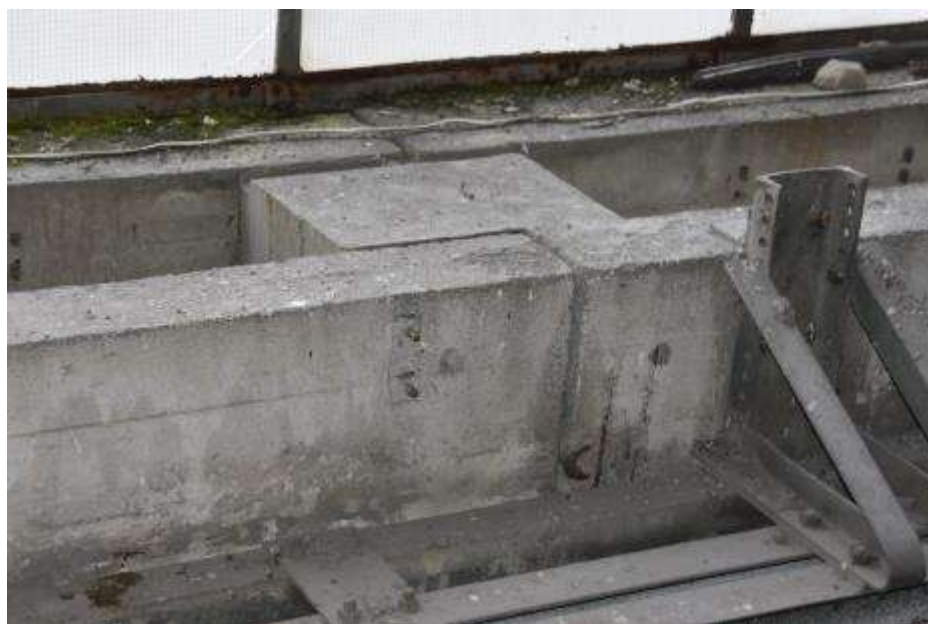
Fot. 11. Fragment ściany zewnętrznej: w odległości 330 cm od słupa połączenie dwóch odcinków belki dolnej kratownicy;
