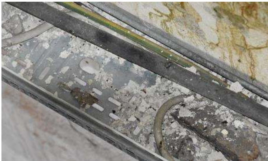
Fot. 72. Fragment ściany zewnętrznej: złuszczone fragmenty zalegają w korytku kablowym;
