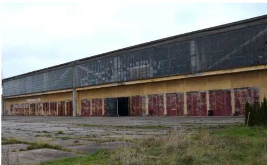
Fot. 384: Fragment elewacji południowej: ściana hangaru o konstrukcji szkieletowej; w osiach skrajnych ujęta słupami żelbetowymi; dodatkowy słup w osi środkowej;
