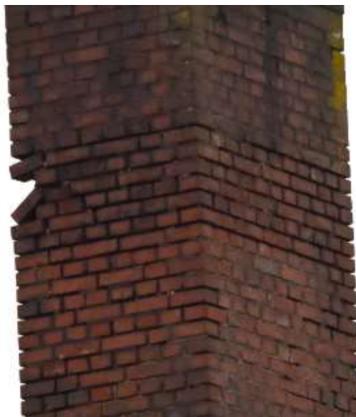
Fot. 196. Fragment komina: lokalnie brak cegły;
