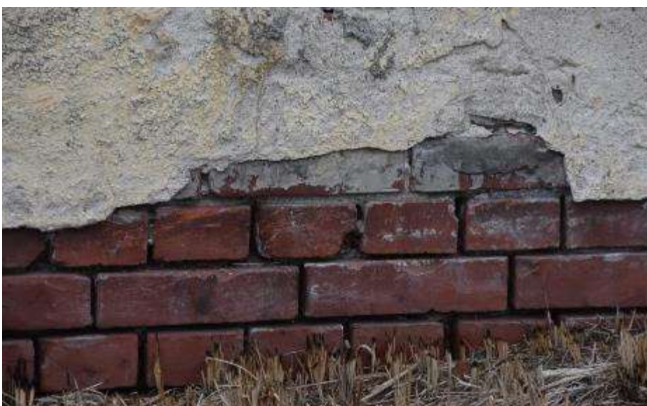
Fot. 426: Fragment elewacji południowej: w pasie nad opaską ubytki tynku; odsłonięta cegła powierzchniowo skorodowana; głębokie ubytki zaprawy w spoinach;
