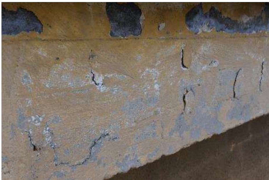
Fot. 401: Fragment elewacji południowej: liczne odparzenia otuliny;
