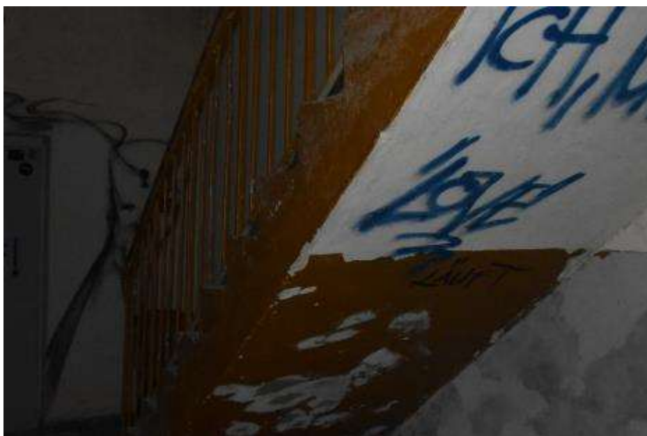
Fot. 183. Fragment biegu schodowego: schody płytowe; żelbetowe; stopnie i podstopnice malowane; napisy na podniebieniu schodów;
