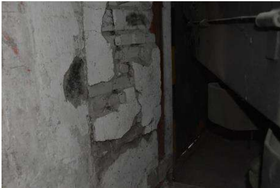
Fot. 8. Fragment ściany zewnętrznej: wypełnienie murowane z bloczków gazobetonowych;
