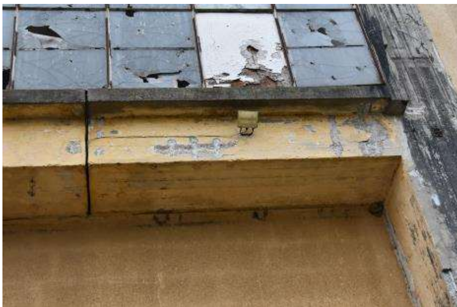
Fot. 404: Fragment elewacji południowej: dylatacja w odległości 350 cm od lica słupów skrajnych;
