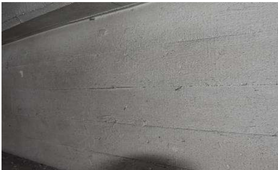
Fot. 206. Fragment dźwigara w osi III-III: elementy wykonywane w szalunku drewnianym; widoczne ślady po deskach;
