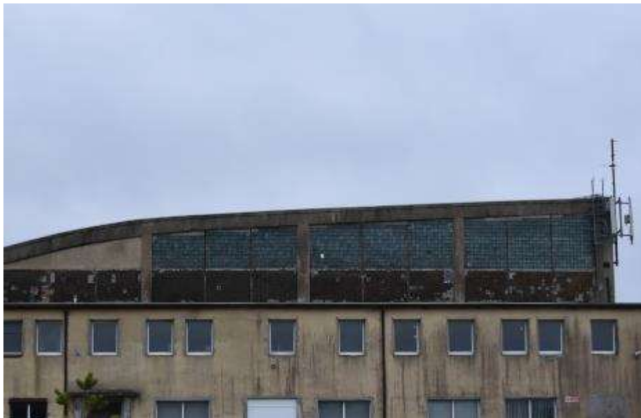
Fot. 289: Fragment elewacji zachodniej: w dolnej części elewacja przysłonięta budynkiem „B”; powyżej elewacja o konstrukcji szkieletowej, żelbetowej;
