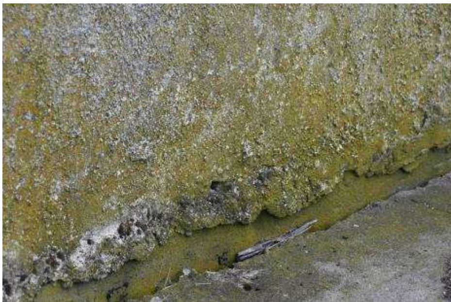
Fot. 275: Fragment elewacji zachodniej: w dolnej części do wysokości 90 cm ślady zawilgocenia; na powierzchni tynku rozwój glonów i porostów;
