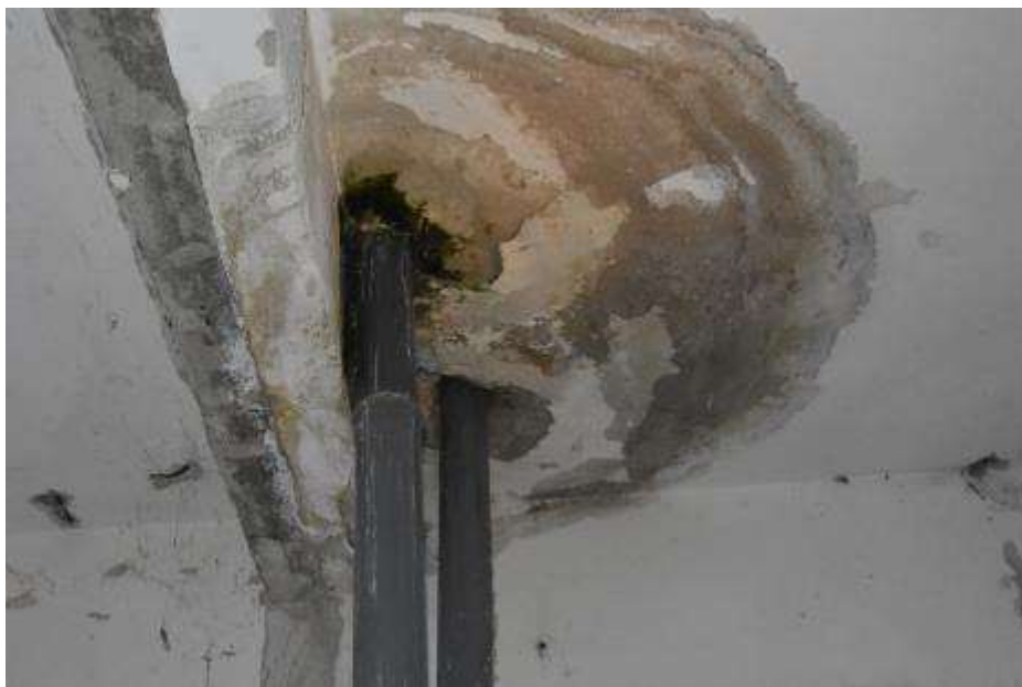
Fot. 181. Fragment stropu nad II piętrem: na suficie zacieki; w miejscu zawilgocenia korozja tynku; złuszczenia warstw zewnętrznych wyprawy;
