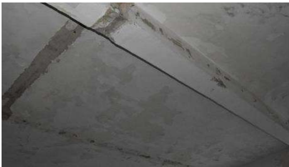
Fot. 240. Fragment stropodachu nad I piętrem: stropodach o układzie płytowo-żebrowym; żebra żelbetowe;
