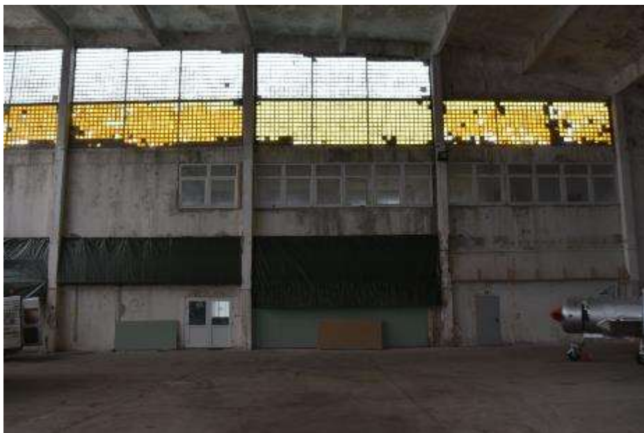
Fot. 17. Fragment ściany zewnętrznej: ściana o konstrukcji szkieletowej; przy ścianie 4 słupy żelbetowe; w poziomie przyziemia i I piętra ściana tynkowana; powyżej wypełnienie z luksferów;
