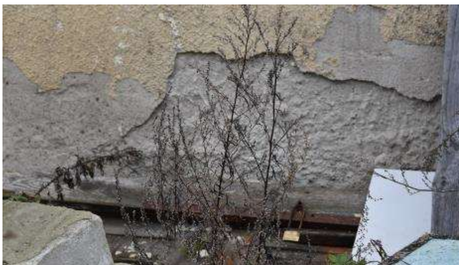
Fot. 334: Fragment elewacji wschodniej: w dolnej części ściana zawilgocona; tynk skorodowany; we fragmentach odpada;
