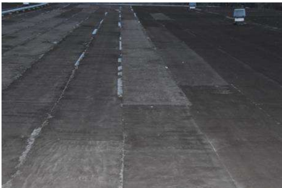
Fot. 254. Fragment dachu nad hangarem: podłoże nierówne; papa pofalowana;
