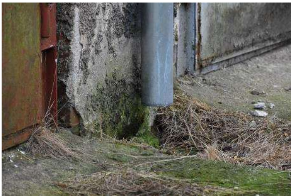
Fot. 264. Fragment elewacji północnej: rura spustowa na filarze trzecim od zachodu bez końcówki; woda odprowadzona bezpośrednio na teren;
