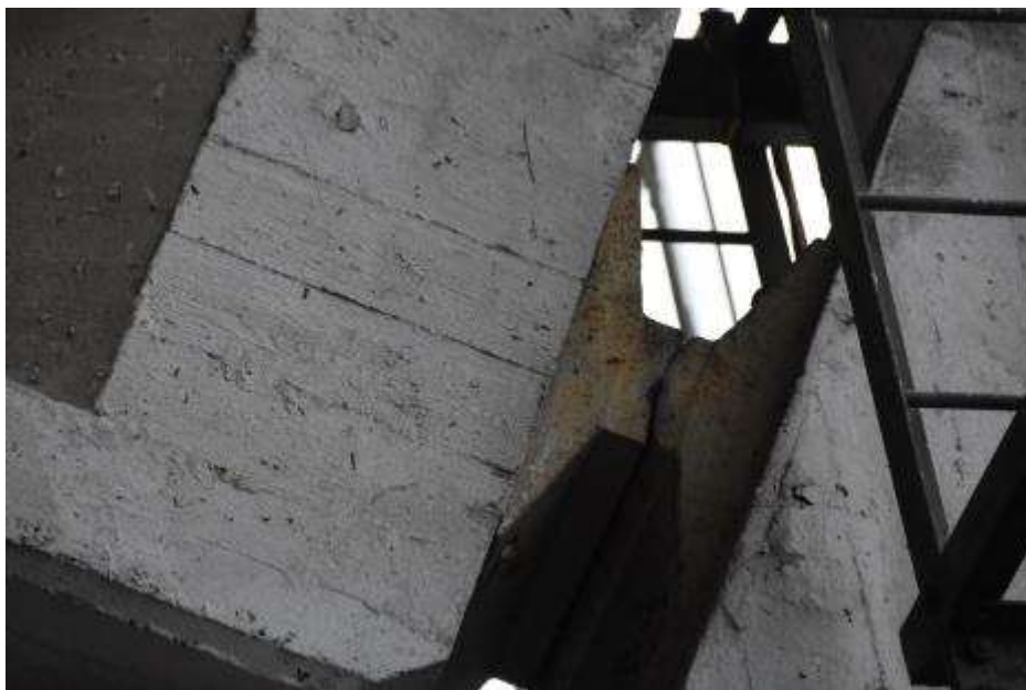
Fot. 215. Fragment dźwigara w osi III-III: połączenie łuku (pasa górnego dźwigara) w osi III ze słupem przegubowe; łożysko stalowe;
