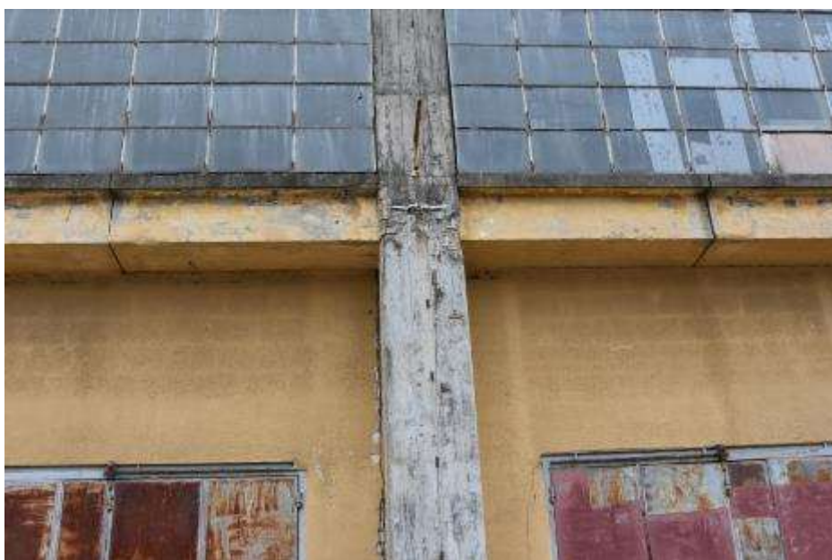
Fot. 402: Fragment elewacji południowej: w odległości 330 cm od lica słupa środkowego dylatacje belki dolnej;
