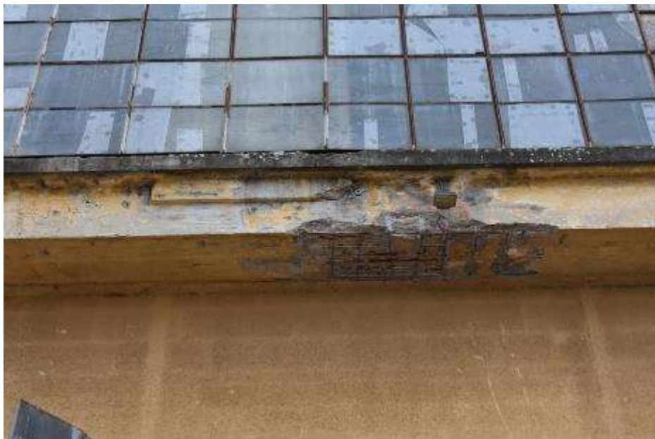
Fot. 407: Fragment elewacji południowej: rozległy ubytek otuliny prętów od spodu belki w rejonie oparcia dźwigara nr IV;
