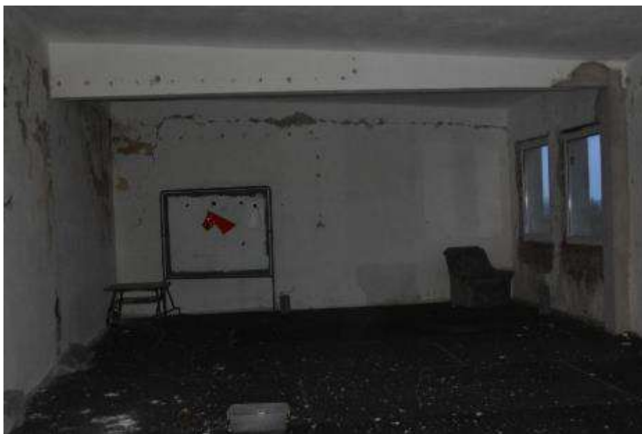
Fot. 118. Fragment ściany wewnętrznej: ściana tynkowana i malowana; zawilgocona;
