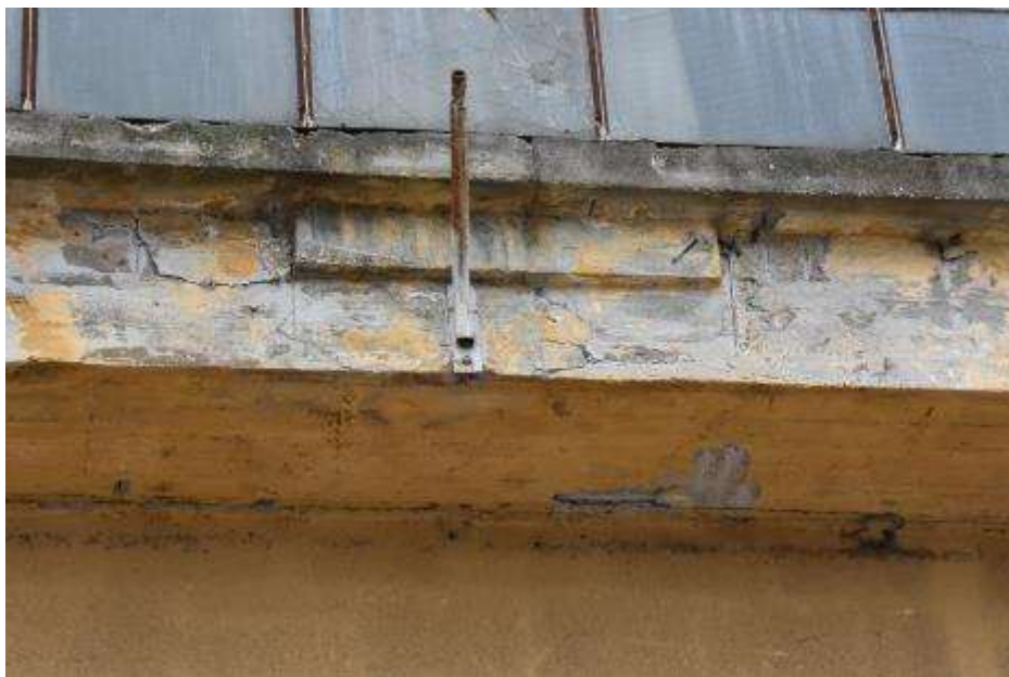
Fot. 412: Fragment elewacji południowej: zbrojenie główne prętami Ø34 mm;
