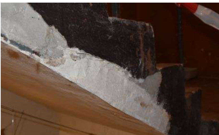
Fot. 185. Fragment biegu schodowego: lokalnie uszkodzenia; ślady napraw;
