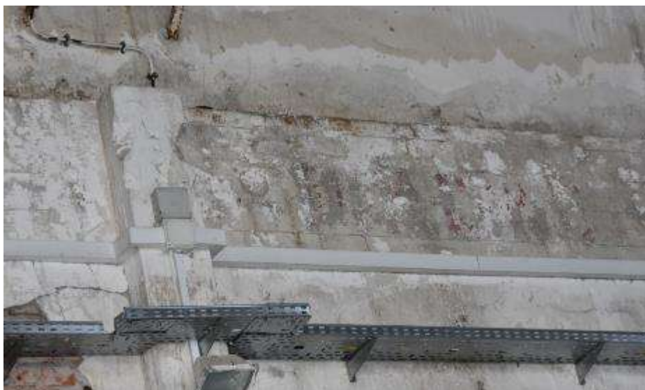
Fot. 46. Fragment ściany zewnętrznej: zacieki na belce żelbetowej; korozja; uszkodzenie pilasta w górnej części; ubytek struktury;
