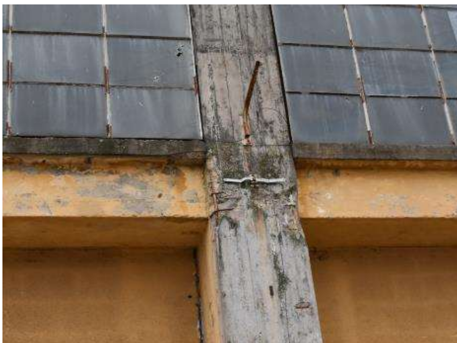
Fot. 396: Fragment elewacji południowej: odsłonięte zbrojenie w rejonie połączenia słupa środkowego z pasem dolnym kratownicy;
