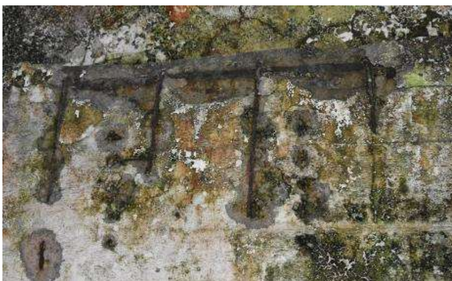
Fot. 71. Fragment ściany zewnętrznej: beton silnie zawilgocony;
