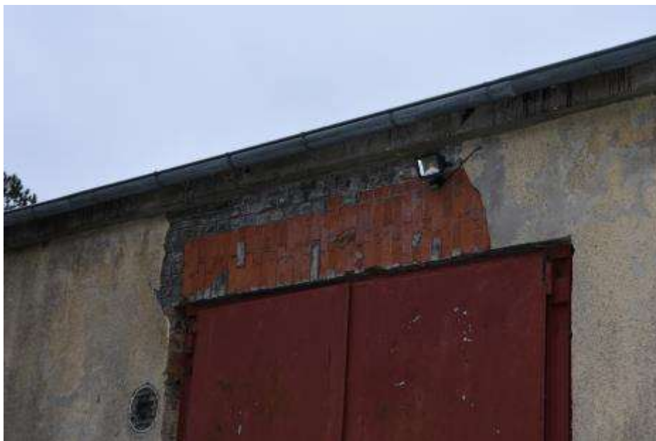
Fot. 316: Fragment elewacji północnej: rozległy ubytek tynku na nadprożu bramy w osi dwudziestej piątej od zachodu; uszkodzenia lico cegły;
