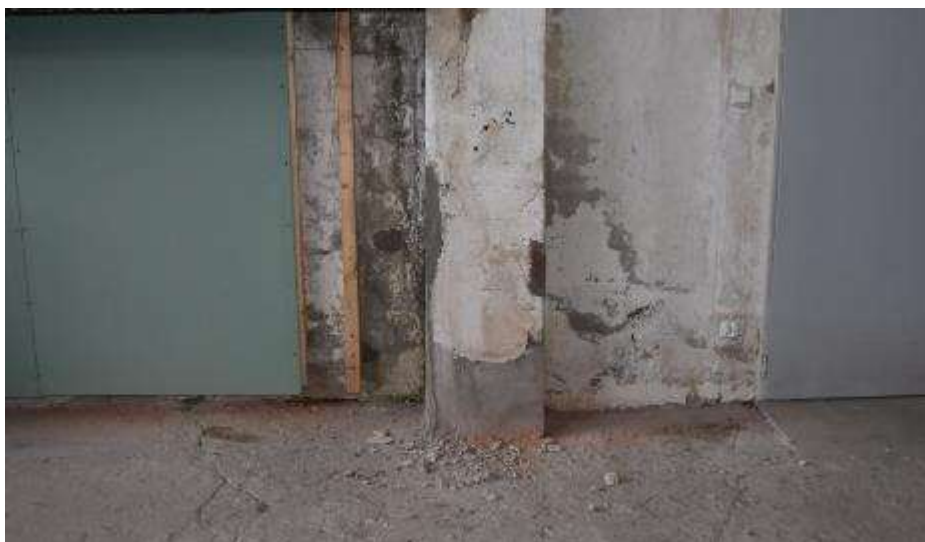
Fot. 21. Fragment ściany zewnętrznej: słup w osi trzeciej od południa (elewacji frontowej) ze śladami napraw w dolnej części;
