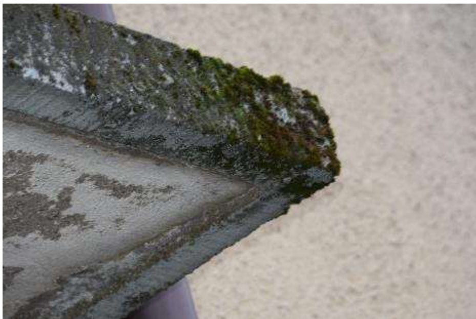
Fot. 347: Fragment elewacji wschodniej: wegetacja mchów;
