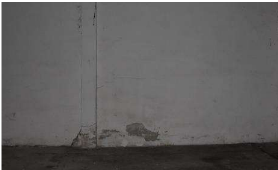
Fot. 125. Fragment ściany zewnętrznej: ściana o konstrukcji szkieletowej; wypełnienie murowane z cegły; tynk skorodowany; w ścianie słup żelbetowy;
