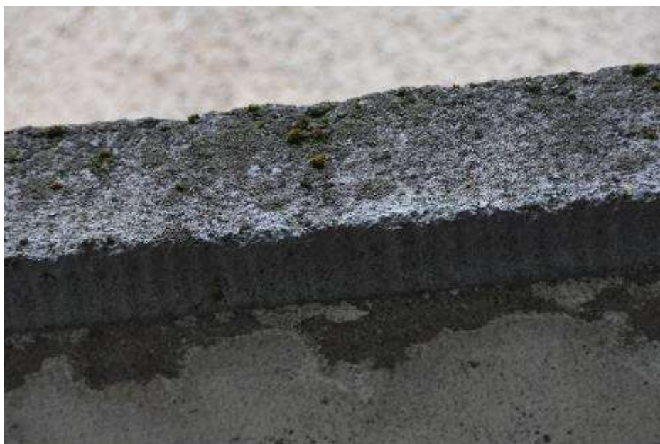
Fot. 346: Fragment elewacji wschodniej: nad wejściem daszek żelbetowy; powierzchnie boczne gradzinowane;
