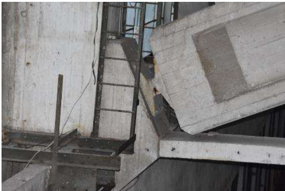
Fot. 12. Fragment ściany zewnętrznej: łuk dźwigara w osi III połączony ze słupem przegubowo;
