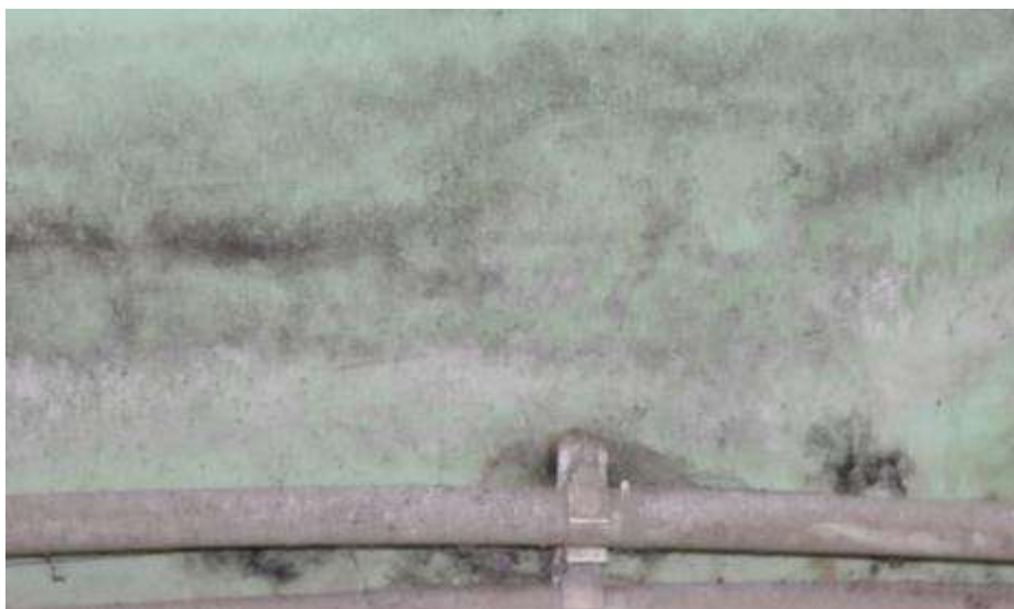
Fot. 101. Fragment ściany zewnętrznej: w dolnej części ściana zawilgocona; na powierzchni rozwój grzybów pleśniowych;
