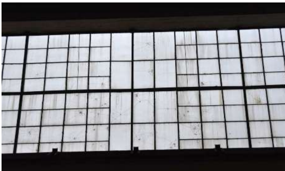
Fot. 6. Fragment ściany zewnętrznej: liczne otwory w szybach; zróżnicowane podziały tafli szkła zbrojonego;
