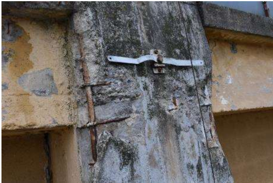
Fot. 397: Fragment elewacji południowej: zbrojenie główne prętami \varnothing 34 mm;
