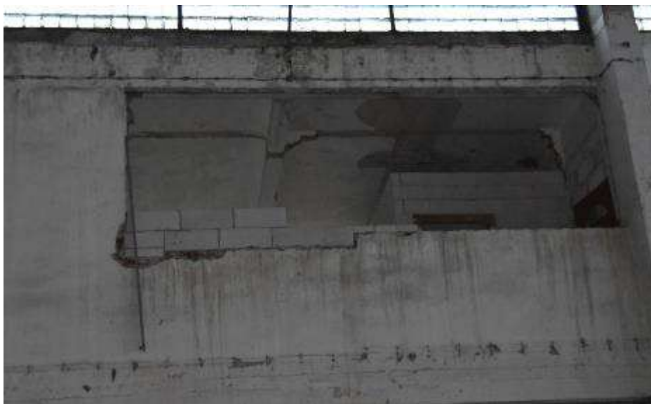
Fot. 93. Fragment ściany zewnętrznej: brak stolarki; otwór w części zamurowany bloczkami betonu komórkowego;
