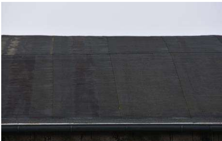
Fot. 246. Fragment dachu nad hangarem: na odcinku od ściany w osi C-C do dźwigara w osi V-V naprawa pokrycia; papa termozgrzewalna;
