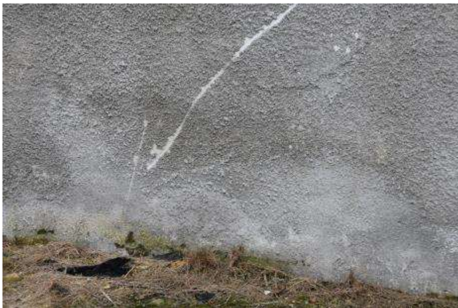
Fot. 303: Fragment elewacji północnej: w dolnej części ściana zawilgocona; tynk skorodowany; odspojony od podłoża;
