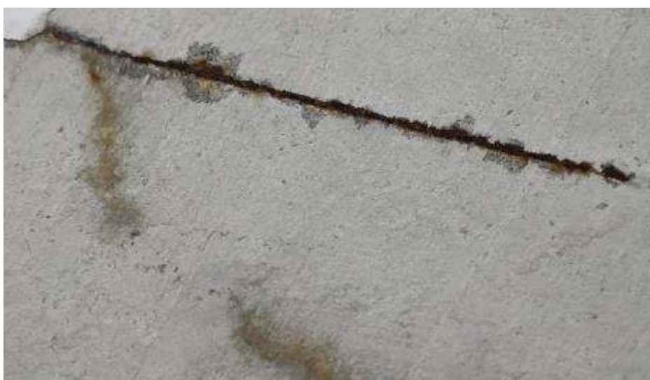
Fot. 241. Fragment stropodachu nad I piętrem: płyta stropodachu monolityczna; lokalnie brak otuliny prętów; zbrojenie powierzchniowo skorodowane;
