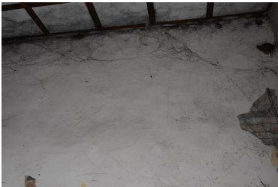
Fot. 147. Fragment ściany wewnętrznej: ściana wymurowana z cegły ceramicznej; tynkowana; tynk skorodowany; odspojony we fragmentach odpada;
