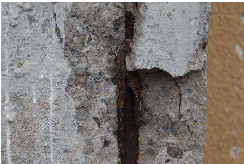
Fot. 393: Fragment elewacji południowej: w dolnej części na skraju słupa zarysowanie; po odspojeniu otuliny widoczne skorodowane zbrojenie;
