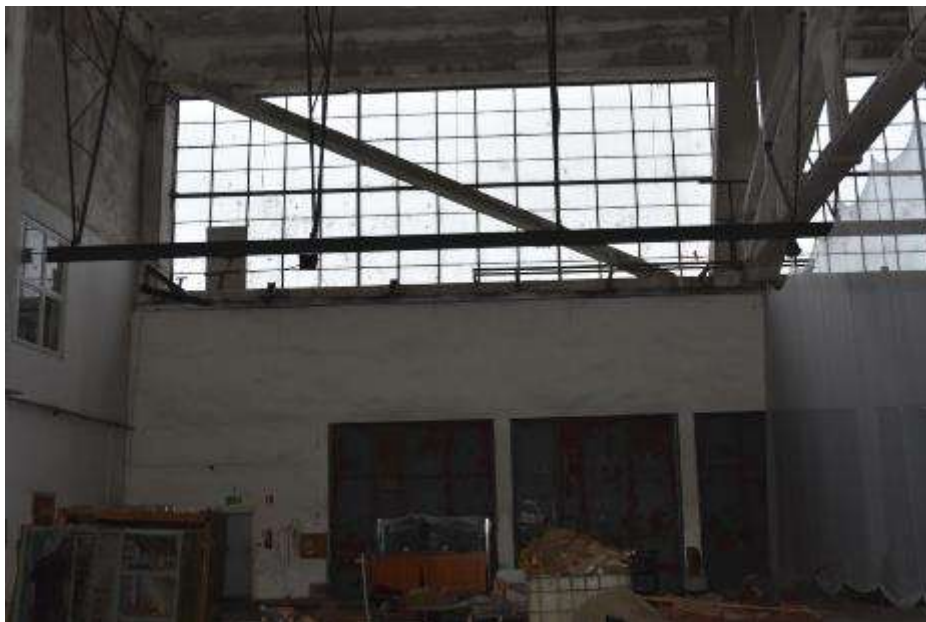
Fot. 16. Fragment ściany zewnętrznej: w dolnej części bramy garażowe; w górnej części kratownica żelbetowa; pomiędzy słupem w osi C-C a dźwigarem V-V krzyżulec żelbetowy;
