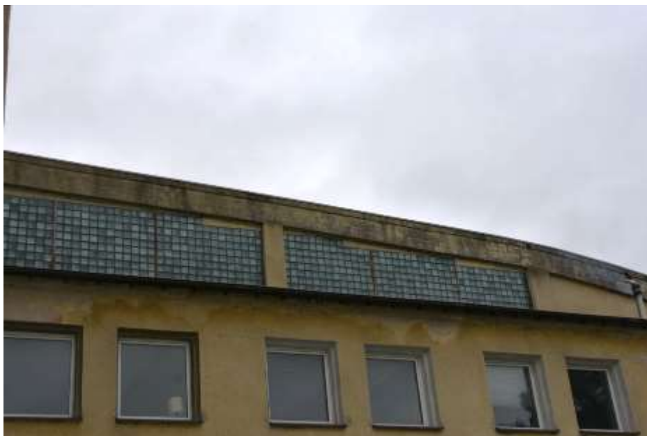
Fot. 353: Fragment elewacji wschodniej: w dolnej części elewacja przysłonięta budynkiem „D”; powyżej elewacja o konstrukcji szkieletowej, żelbetowej;
