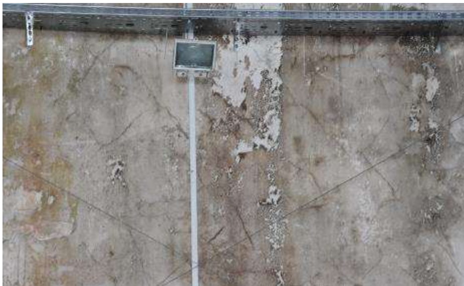
Fot. 41. Fragment ściany zewnętrznej: na odcinku od słupa w osi I-I do pilasta tynk silnie zawilgocony; tynk skorodowany; odspojony od podłoża; zarysowania o zróżnicowanym przebiegu;
