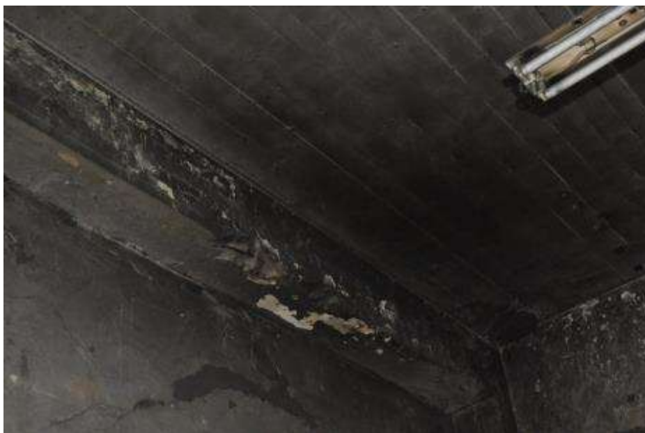
Fot. 170. Fragment stropu nad parterem: strop płytowo żebrowy; monolityczny; w pomieszczeniu nr 6 na suficie ciemne naloty;
