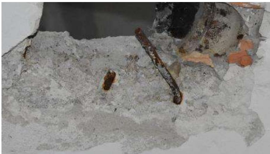
Fot. 179. Fragment stropu nad II piętrem: w pomieszczeniach II piętra strop monolityczny płyta żelbetowa grubości 10 cm; odsłonięte zbrojenie powierzchniowo skorodowane;
