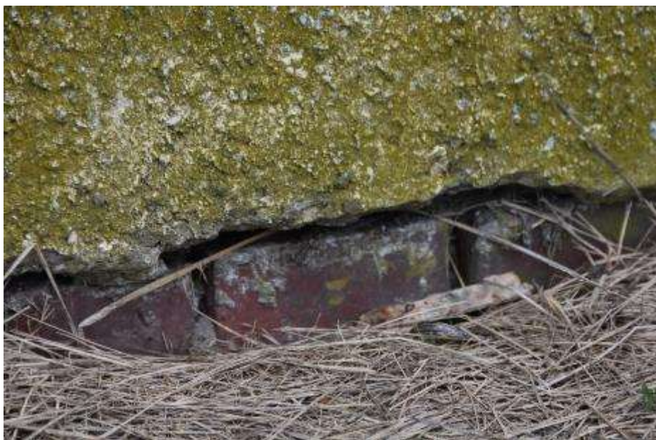
Fot. 276: Fragment elewacji zachodniej: ponad opaską ubytki wyprawy tynkarskiej; głębokie ubytki zaprawy w spoinach;
