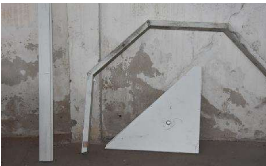
Fot. 42. Fragment ściany zewnętrznej: zawilgocenia w dolnej części ściany; zarysowanie o przebiegu ukośnym po stronie wschodniej pilastra;
