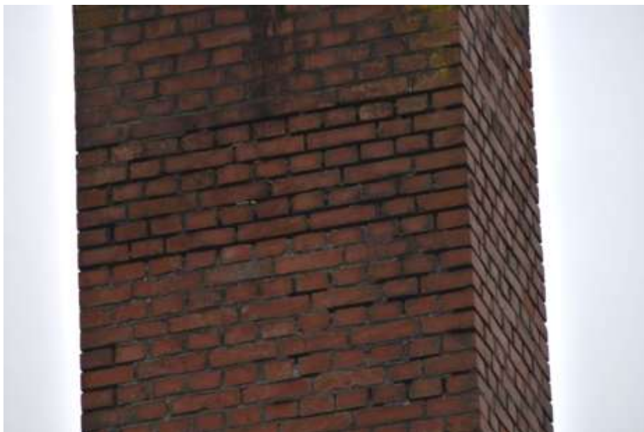
Fot. 195. Fragment komina: powyżej poziomu dachu komin bez tynku; głębokie ubytki zaprawy w spoinach;
