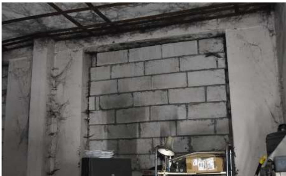
Fot. 129. Fragment ściany zewnętrznej: ściana o konstrukcji szkieletowej; w górnej części belka żelbetowa; przy ścianie słup; wypełnienie tynkowane; w ścianie dwa zamurowane bloczkami gazobetonowymi otwory okienne;
