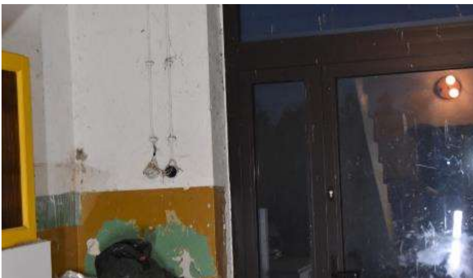
Fot. 132. Fragment ściany zewnętrznej: ściana tynkowana i malowana; w dolnej części lamperia; w ścianie otwór drzwiowy; złuszczenia warstw malarskich;
