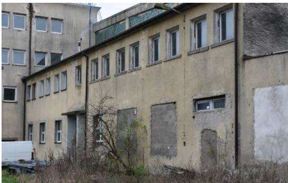
Fot. 336: Fragment elewacji wschodniej: warstwa zewnętrzna tynku tzw. „baranek”;
