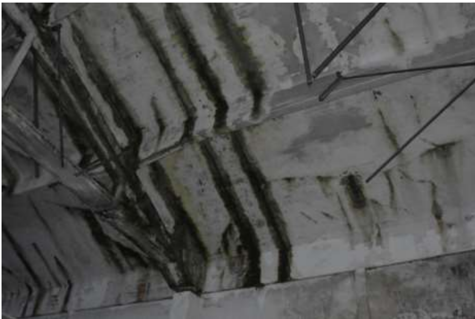
Fot. 226. Fragment płyty dachowej: rozległe zacieki przy dźwigarze w osi IV-IV; na powierzchni płyty rozwój kolonii glonów;
