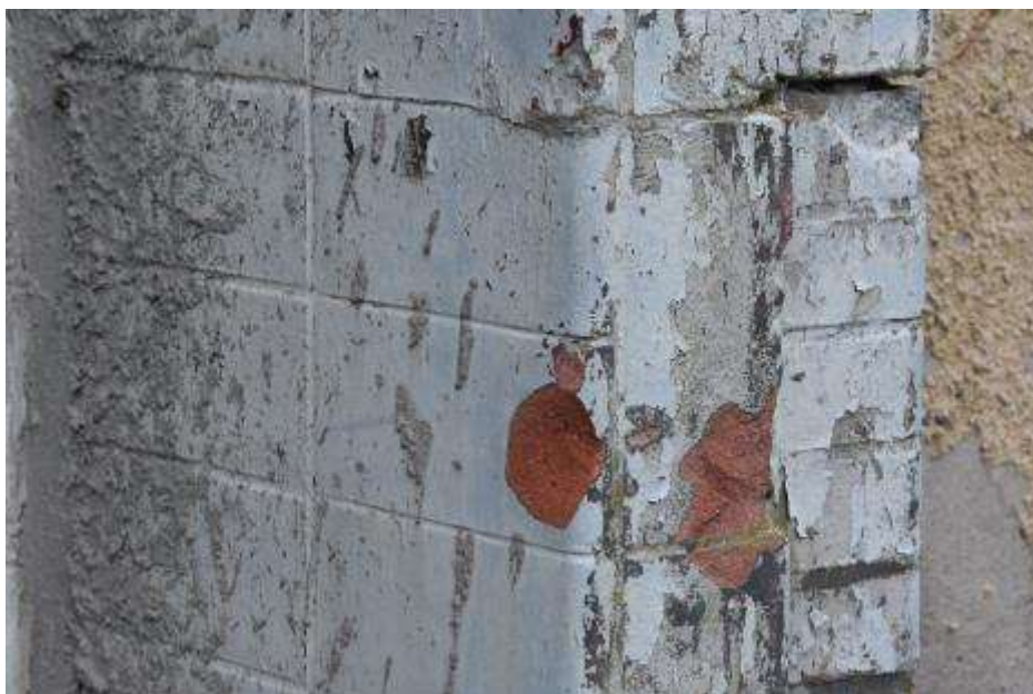
Fot. 344: Fragment elewacji wschodniej: ościeże wyłożone płytką ceramiczną; lokalnie uszkodzenia mechaniczne;
