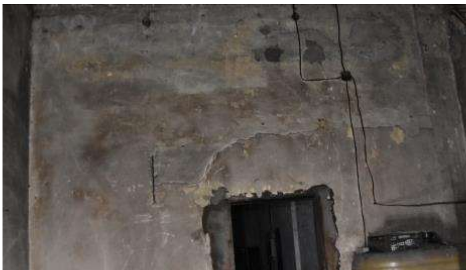
Fot. 98. Fragment ściany wewnętrznej: poziome zarysowanie nad otworem drzwiowym;
