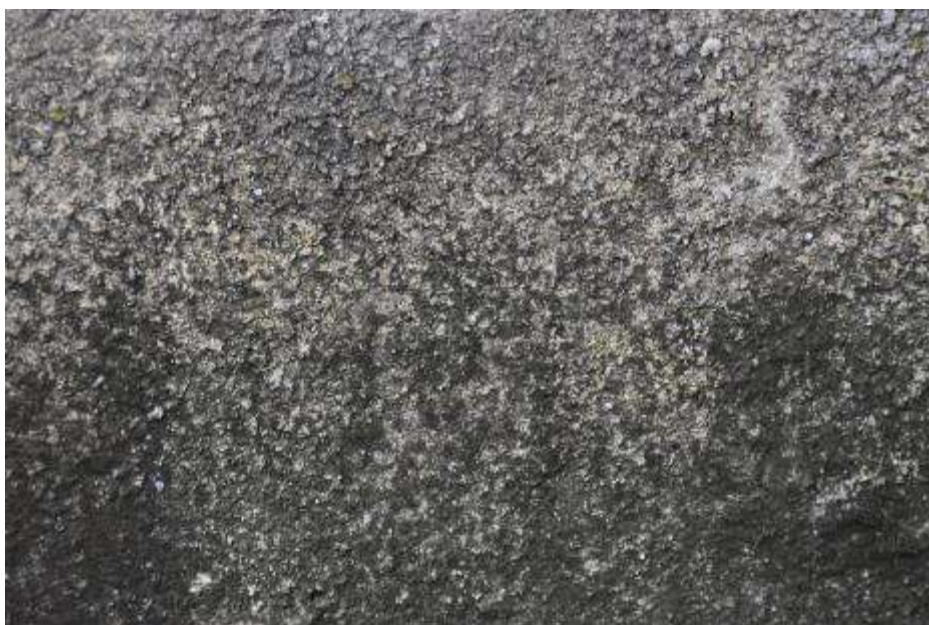
Fot. 330: Fragment elewacji północnej: na powierzchni rozwój kolonii glonów;
