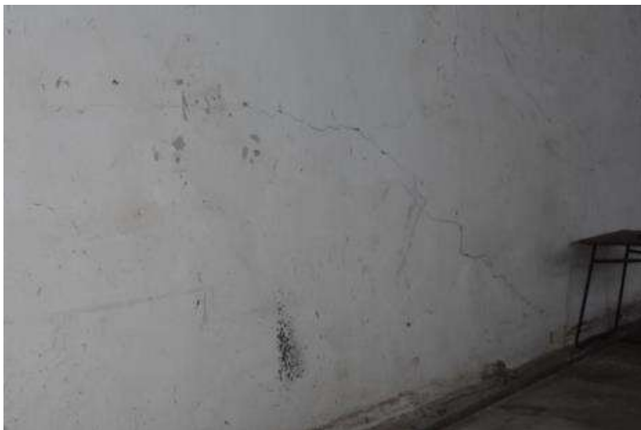
Fot. 82. Fragment ściany zewnętrznej: zarysowania ściany wypełniającej na odcinku od pilasta do ściany w osi C-C;
