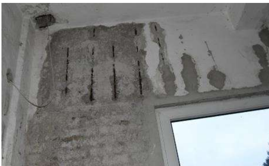
Fot. 163. Fragment ściany zewnętrznej: odsłonięte zbrojenie skorodowane;
