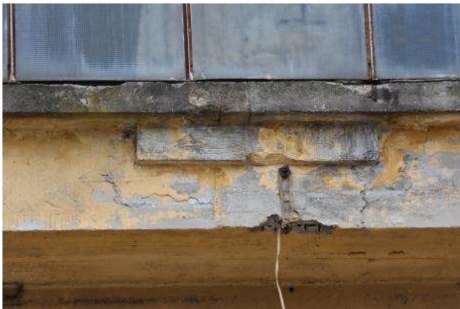
Fot. 405: Fragment elewacji południowej: pogrubienia belki w miejscach oparcia dźwigarów; poszerzenie belki o 5 cm na wysokości 26 cm;
