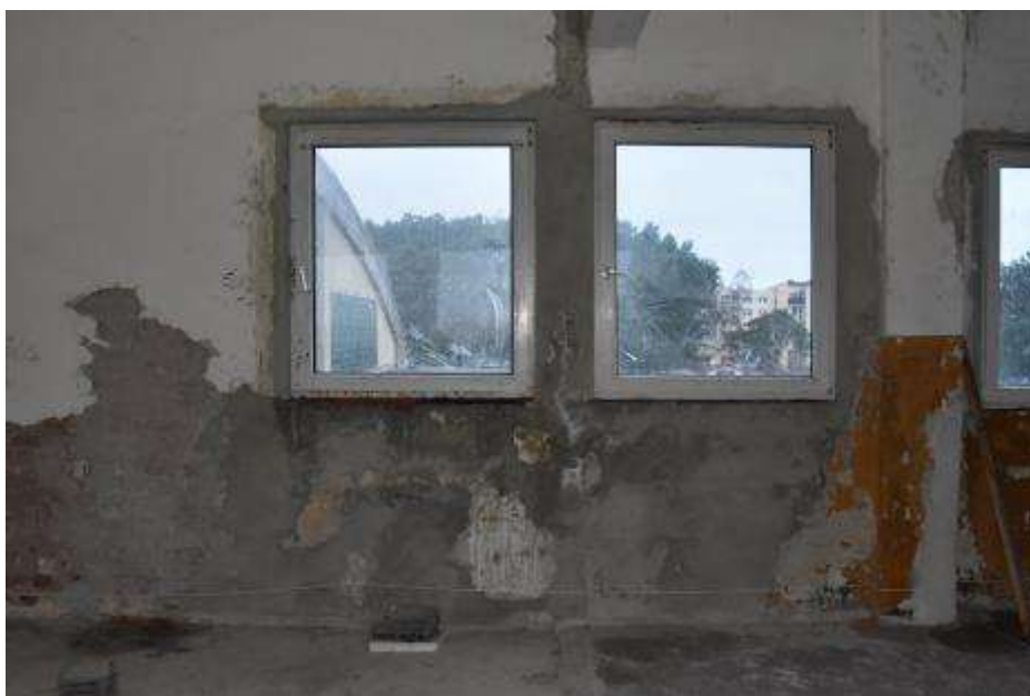
Fot. 164. Fragment ściany zewnętrznej: ściana tynkowana i malowana; rozległe ubytki wyprawy; ślady napraw; zachowane fragmenty tynku skorodowane; zacieki; złuszczenia warstw malarskich;
