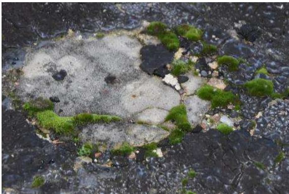
Fot. 252. Fragment dachu nad hangarem: lokalnie na powierzchni wegetacja mchów;
