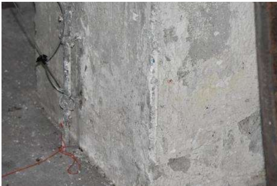
Fot. 81. Fragment ściany zewnętrznej: zawilgocenia w dolnej części;
