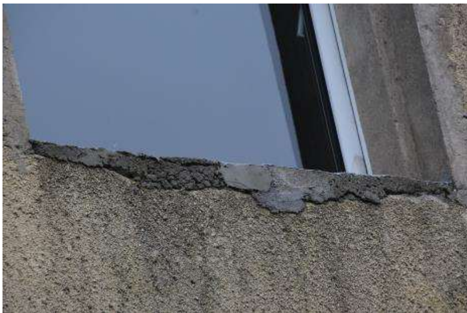
Fot. 280: Fragment elewacji zachodniej: w poziomie I piętra brak parapetów;
