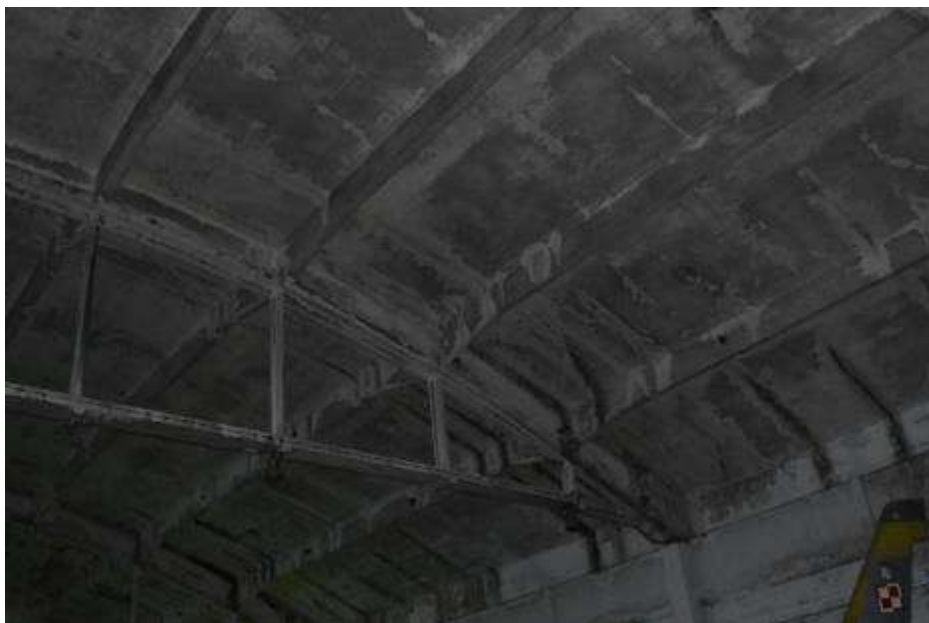
Fot. 199. Fragment dźwigara w osi II-II: od strony północnej dźwigar z zaciekami;
