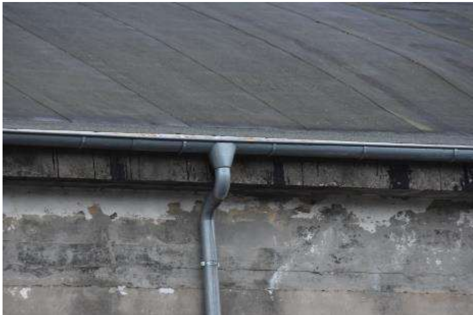
Fot. 261. Fragment elewacji zachodniej: rynny i rury spustowe z blachy tytan-cynk;
