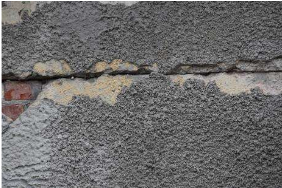
Fot. 301: Fragment elewacji północnej: pęknięcie pionowe na wysokości nadproża bramy garażowej;
