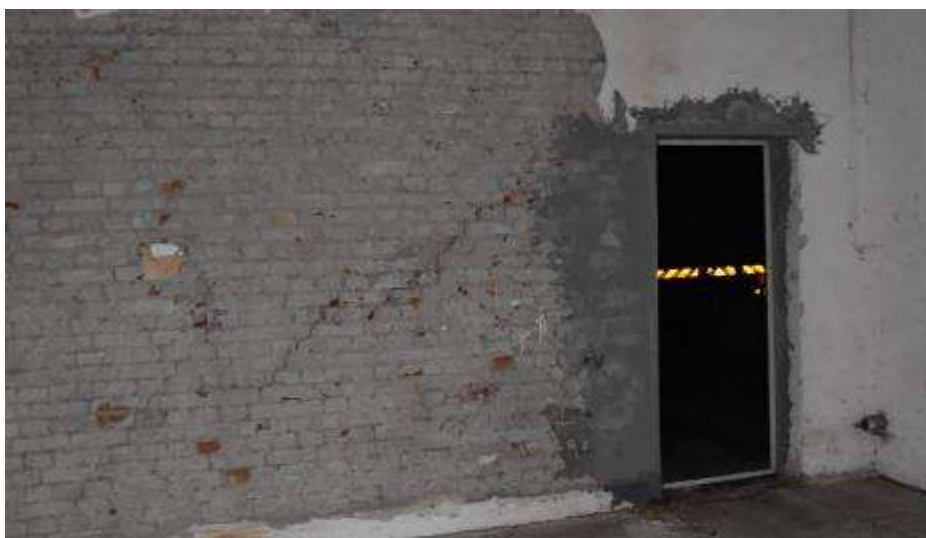
Fot. 85. Fragment ściany wewnętrznej: przy otworze drzwiowym ukośne pęknięcie - od strony garażu nr G8 ściana wypełniająca murowana z cegły ceramicznej; tynk skorodowany; we fragmentach brak;
