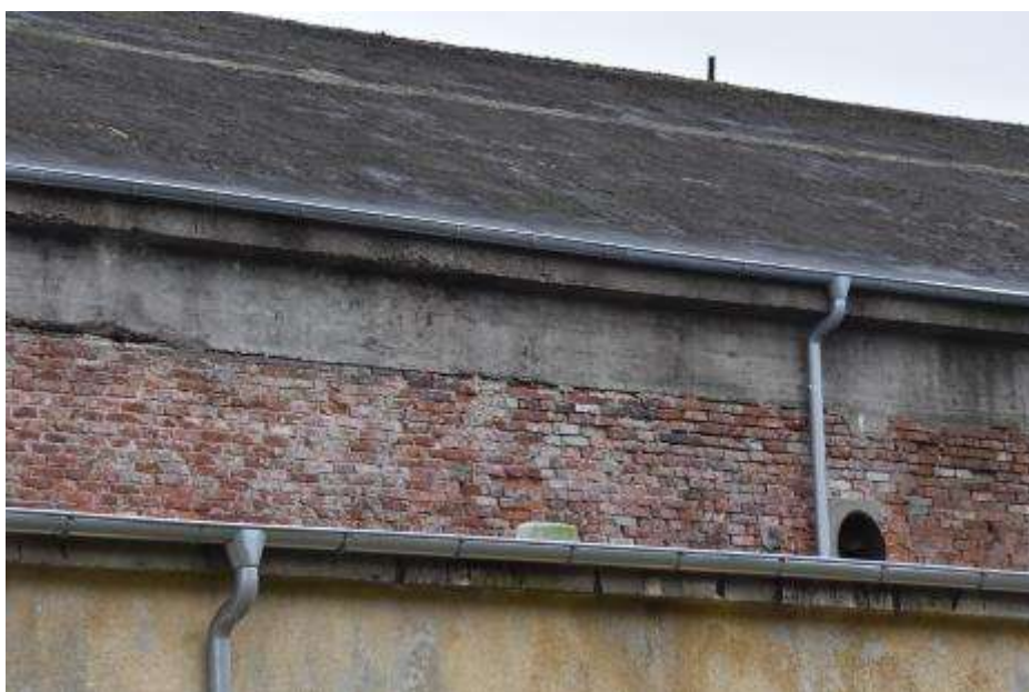
Fot. 250. Fragment dachu nad hangarem: na odcinku od dźwigara w osi V-V do III-III pokrycie zmurszałe; brak działań naprawczych;
