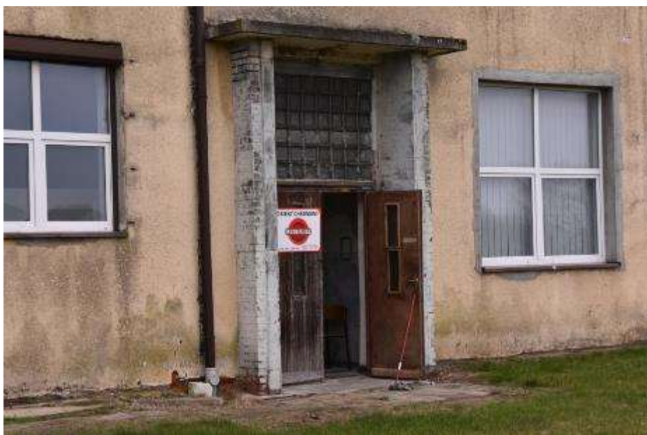
Fot. 282: Fragment elewacji zachodniej: oryginalny portal wejściowy murowany z cegły ceramicznej; naświetle z luksferów;
