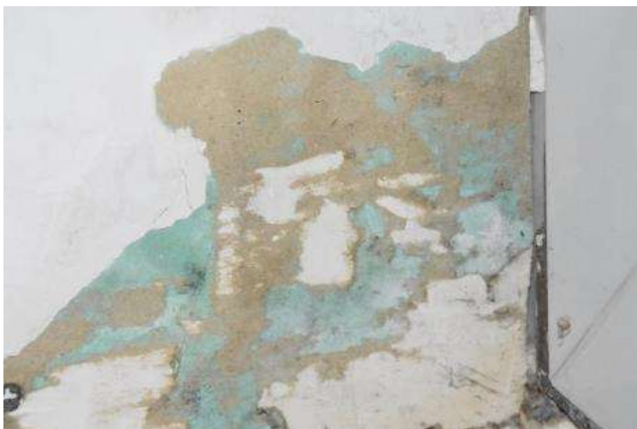
Fot. 108. Fragment ściany zewnętrznej: zawilgocenie ościeży;
