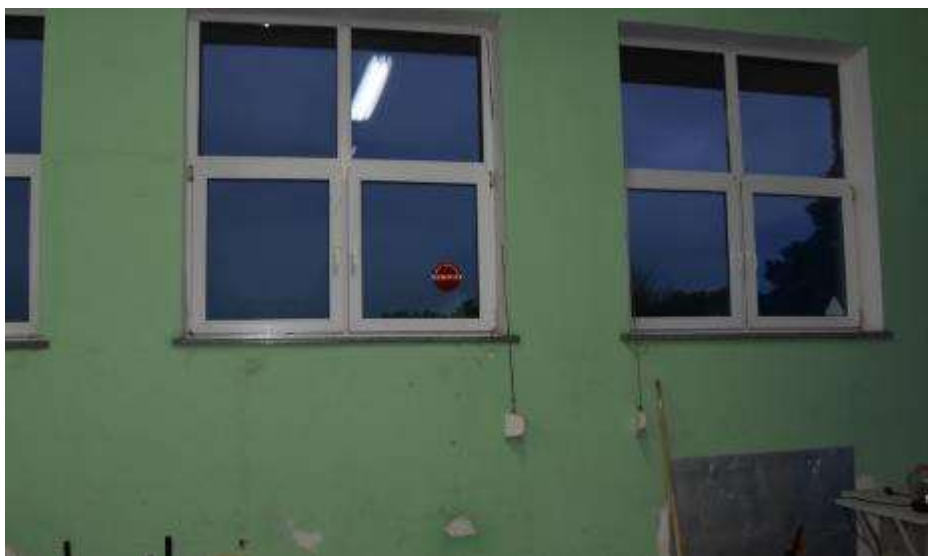
Fot. 100. Fragment ściany zewnętrznej: ściana o konstrukcji szkieletowej; wypełnienie murowane i tynkowane; wyłożona płytami G-K; w ścianie 3 otwory okienne; stolarka plastikowa;
