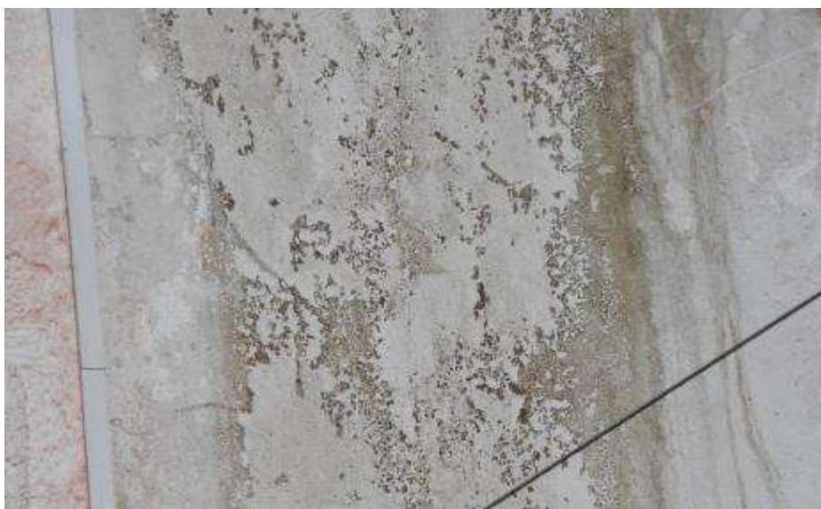
Fot. 48. Fragment ściany zewnętrznej: w rejonie środkowego pilastra zaciek; tynk skorodowany; w miejscu zacieku na powierzchni tynku ciemne naloty;
