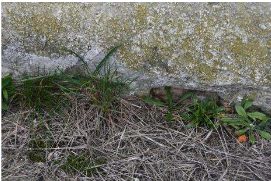
Fot. 277: Fragment elewacji zachodniej: w szczelinie pomiędzy opaską a elewacją wegetacja roślin jednorocznych;
