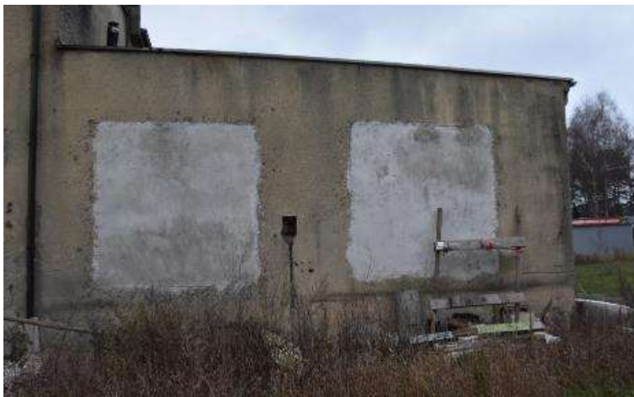
Fot. 333: Fragment elewacji wschodniej: elewacja tynkowana; z warstwą zewnętrzną tzw. „barankiem”; otwory okienne obecnie zamurowane; otynkowane;
