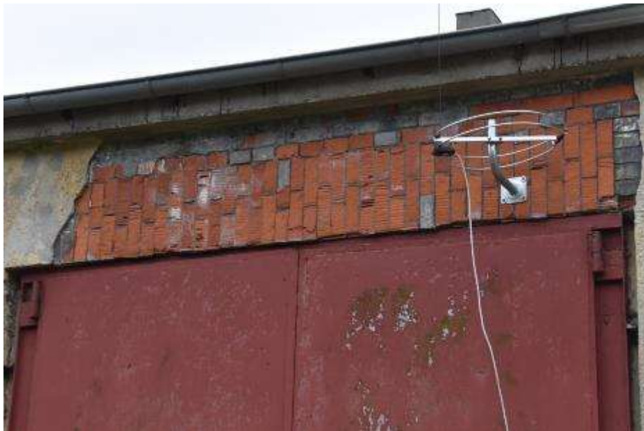
Fot. 315: Fragment elewacji północnej: rozległy ubytek tynku na nadprożu bramy w osi dwudziestej czwartej od zachodu; uszkodzenia lica cegły;
