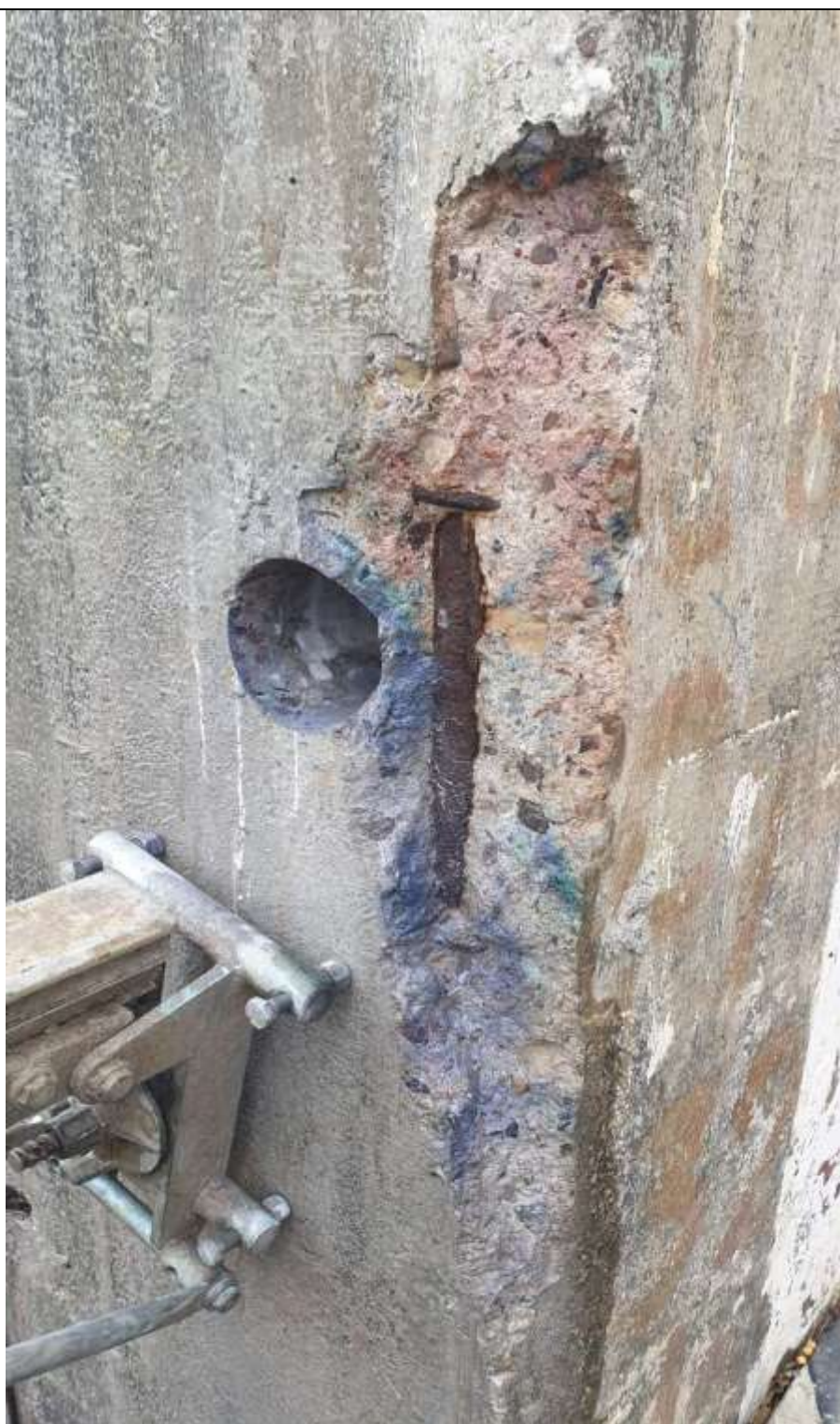
Fot. 2 Beton świeżo odkuty stopniowa karbonatyzacja pH 10-12 (rejon odwiertu rdzeniowego) oraz skarbonatyzowany narożnik (długotrwała ekspozycja elementu, odłupany narożnik ściany pH<8)
