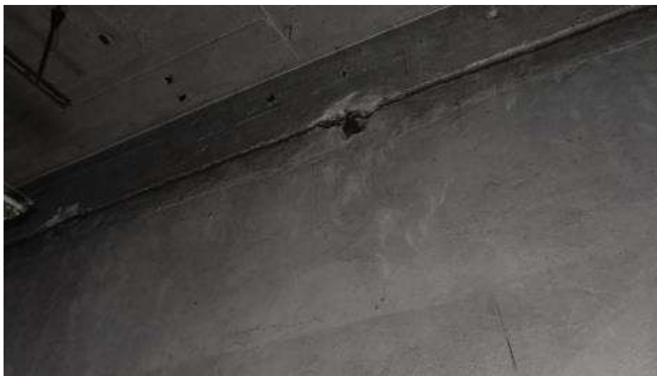
Fot. 146. Fragment ściany wewnętrznej: ściana tynkowana; wymurowana pod żebrem stropu;
