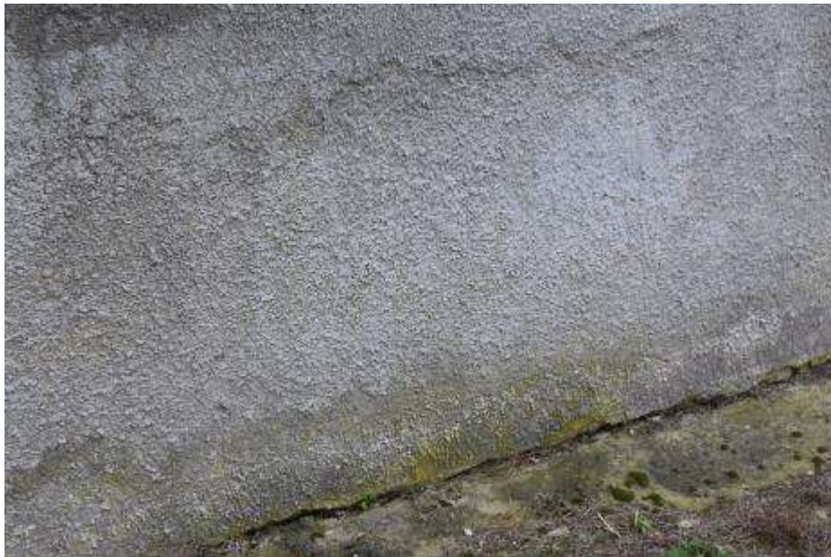
Fot. 295: Fragment elewacji zachodniej: ściana zawilgocona do wysokości parapetów okiennych;
