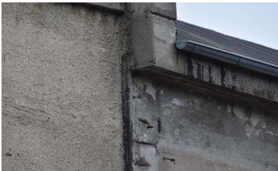
Fot. 324: Fragment elewacji północnej: słup narożny przy budynku „D” z ubytkami otuliny prętów; odsłonięte zbrojenie powierzchniowo skorodowane;
