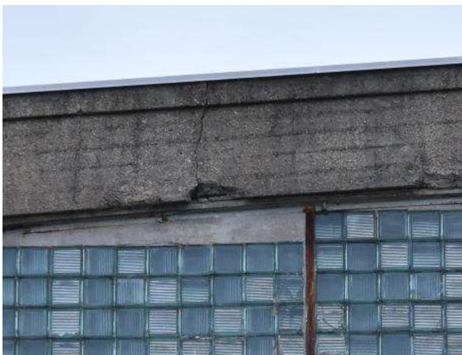
Fot. 292: Fragment elewacji zachodniej: belka wieńcząca z pionowym pęknięciem;
