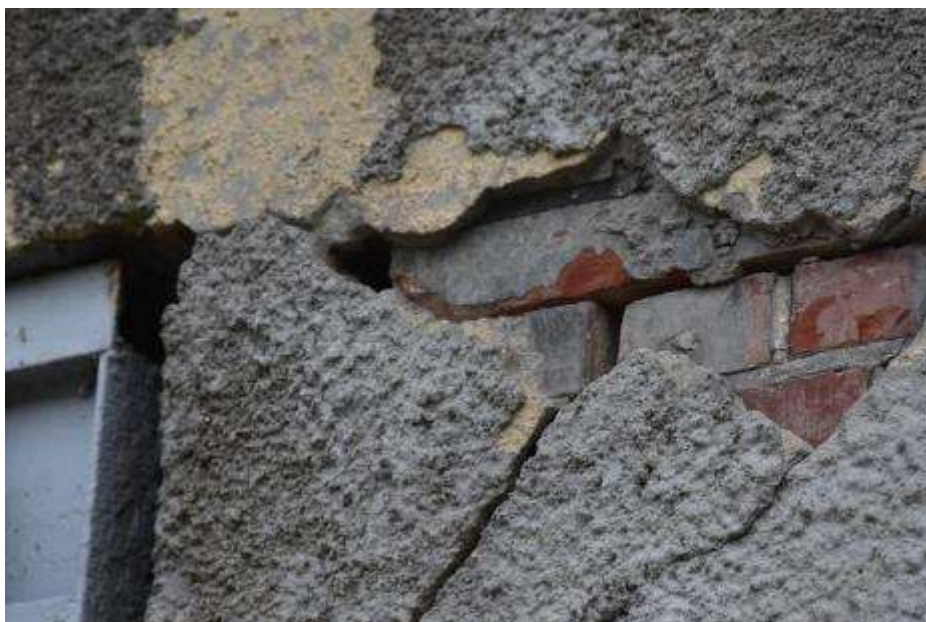
Fot. 304: Fragment elewacji północnej: w rejonie otworu bramnego tynk odpada;
