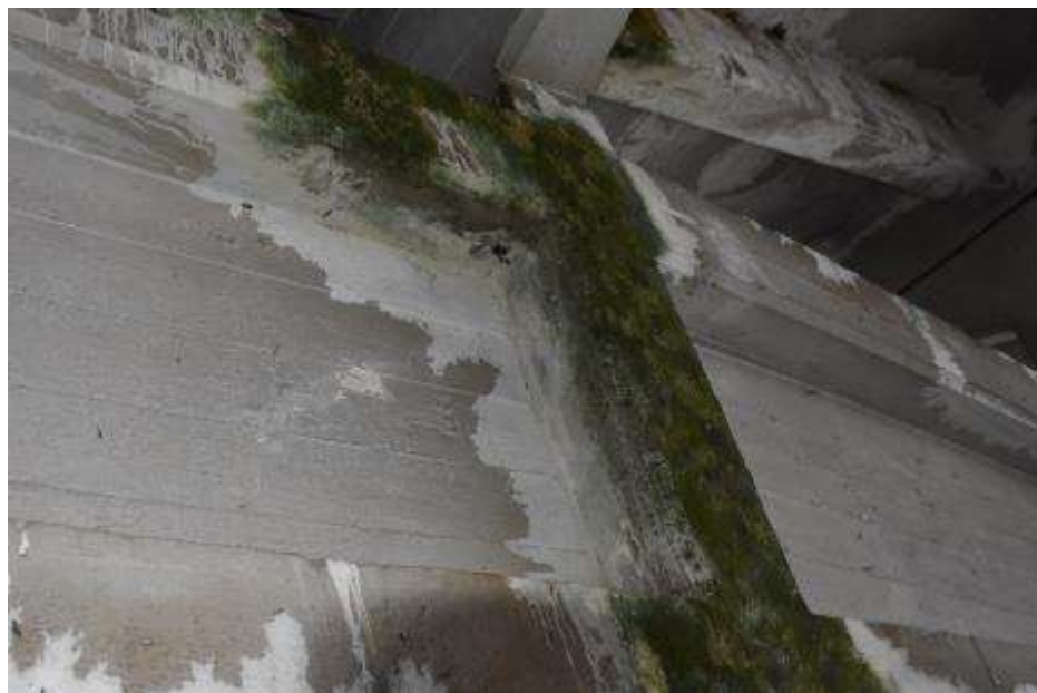
Fot. 205. Fragment dźwigara w osi III-III: przy trzecim wieszaku licząc od południa silne zawilgocenie; rozwój kolonii glonów przewiązce; pasie górnym i dolnym łuku;
