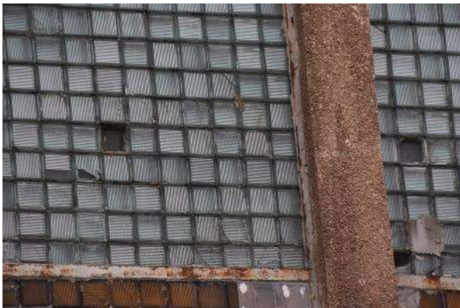
Fot. 291: Fragment elewacji zachodniej: luksfery lokalnie uszkodzone;
