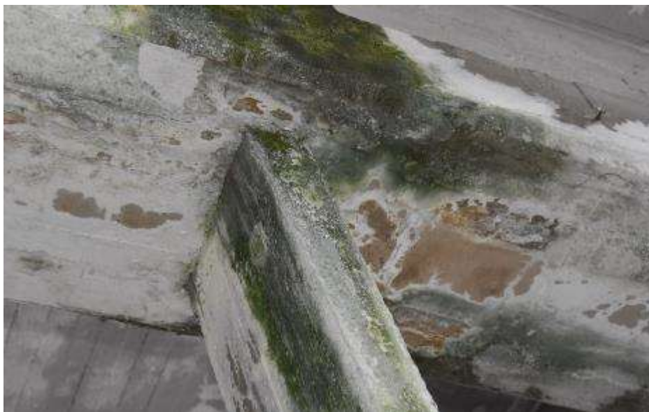
Fot. 204. Fragment dźwigara w osi III-III: na powierzchni wieszaka zacieki i rozwój kolonii glonów
