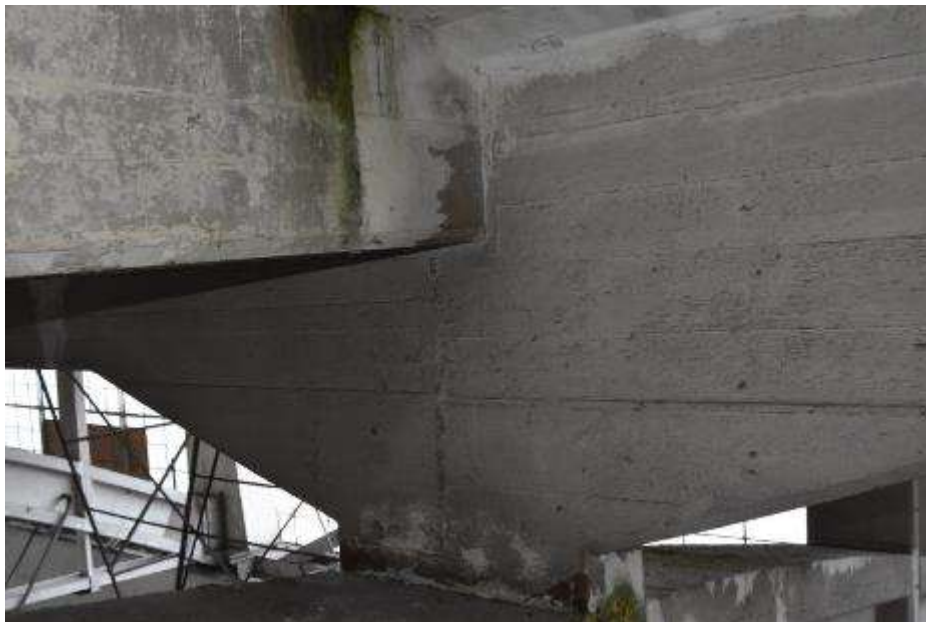
Fot. 210. Fragment dźwigara w osi III-III: węzeł łączący belkę pod stropem z górnym pasem łuku i płatwią w osi 3 z południa; płatwie zukosowane w rejonie węzła;
