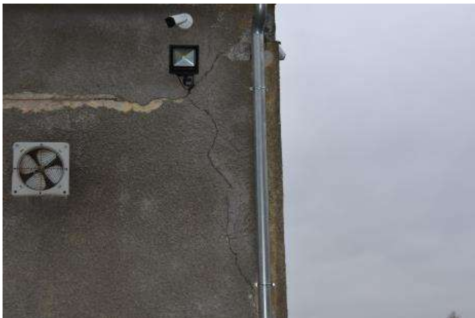
Fot. 302: Fragment elewacji północnej: zarysowanie ukośne od gzymsu do gruntu;
