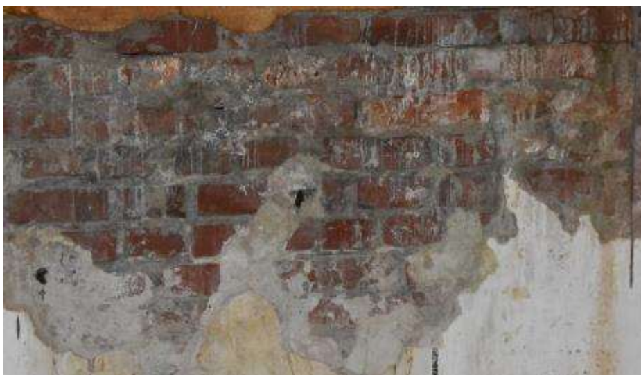
Fot. 106. Fragment ściany zewnętrznej: ściana zawilgocona; rozległe ubytki wyprawy tynkarskiej; odsłonięta cegła powierzchniowo skorodowana;
