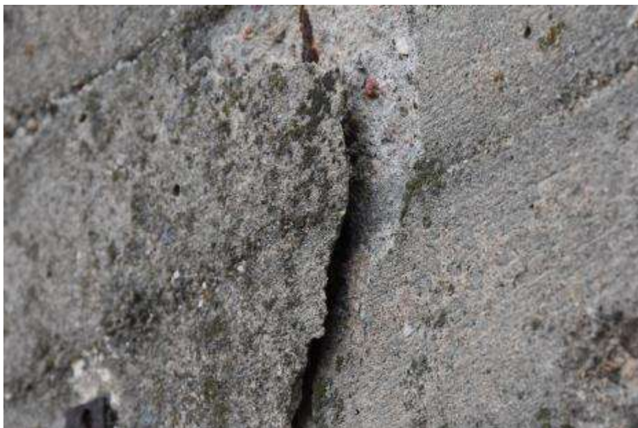
Fot. 415: Fragment elewacji południowej: odparzenia otuliny prętów;
