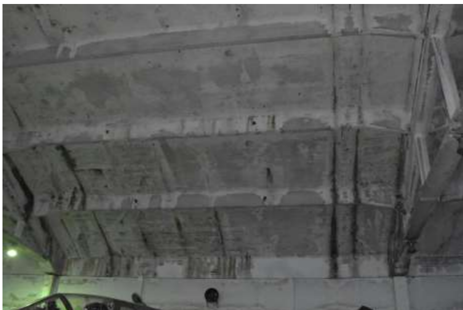
Fot. 232. Fragment płyty dachowej: zacieki od strony północnej;
