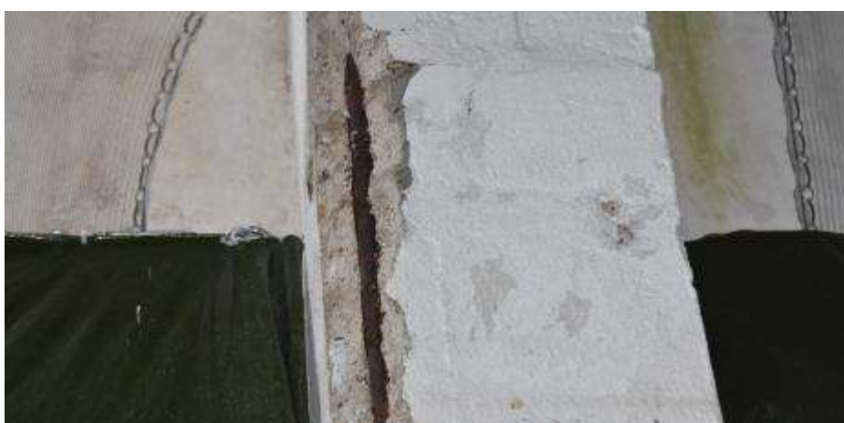
Fot. 20. Fragment ściany zewnętrznej: słup w osi drugiej od południa (elewacji frontowej) z ubytkiem otuliny pręta narożnego na wysokości stropu pomiędzy parterem i I piętrem; odsłonięty pręt powierzchniowo skorodowany;
