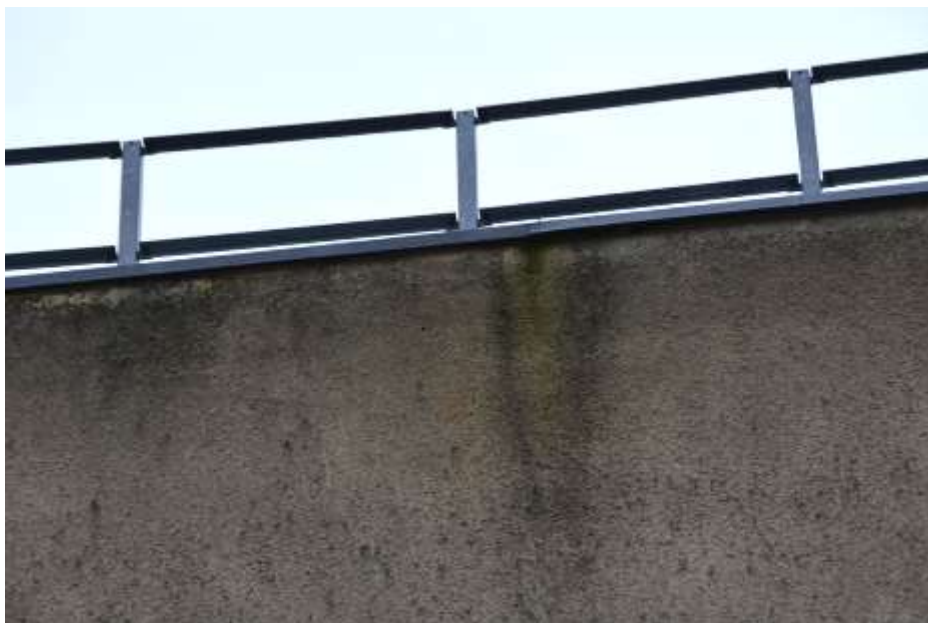
Fot. 383: Fragment elewacji południowej: ściana zwieńczona wyoblonym gzymsem; od góry zabezpieczona obróbką z blachy; zacieki na powierzchni;
