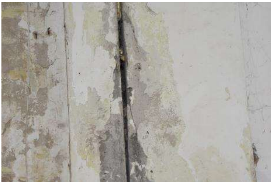
Fot. 136. Fragment ściany zewnętrznej: w ścianie dylatacja; przy dylatacji dwa słupy; szczelina wypełniona pianką montażową;
