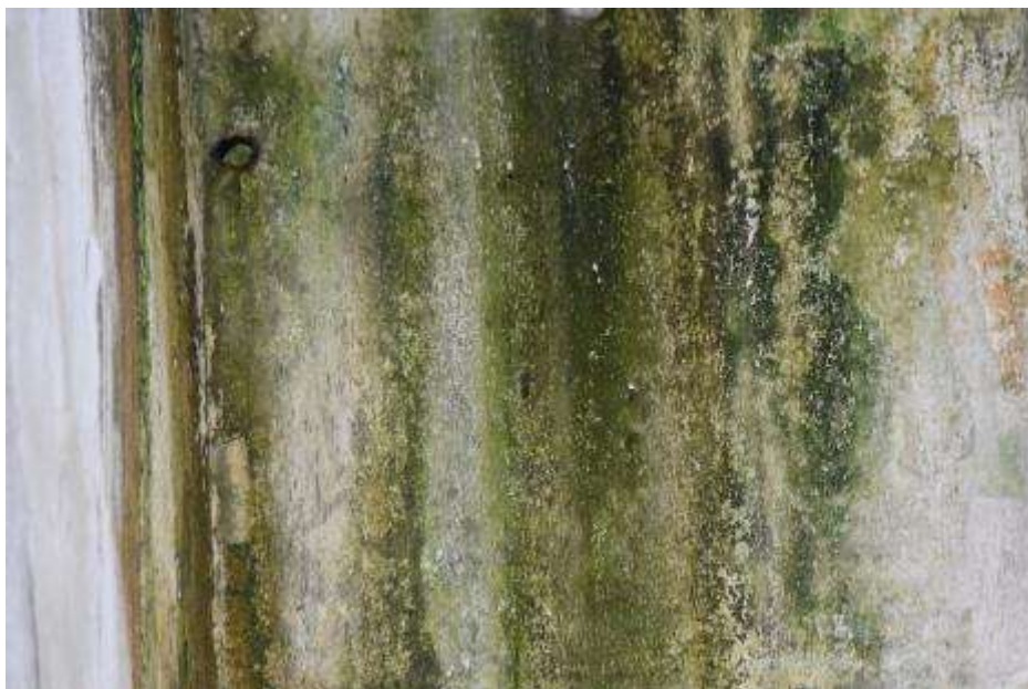
Fot. 60. Fragment ściany zewnętrznej: na powierzchni bocznej słupa w osi IV zaciek; rozwój kolonii glonów;
