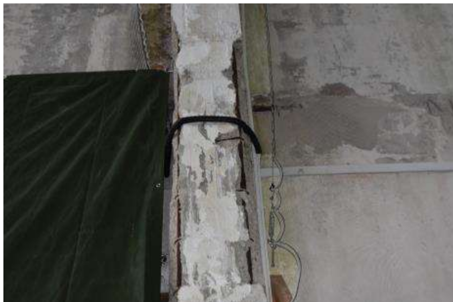
Fot. 22. Fragment ściany zewnętrznej: rozległy ubytek otuliny prętów pomiędzy parterem i I piętrem;
