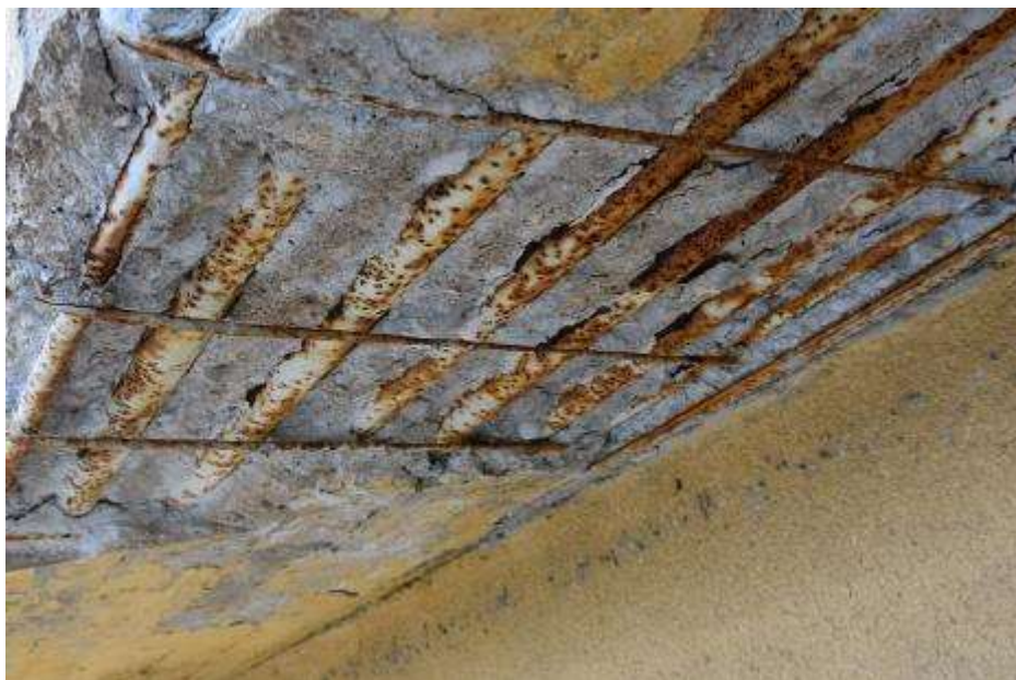
Fot. 408: Fragment elewacji południowej: odsłonięte zbrojenie dolne belki – 7 prętów: dwa pręty skrajne \varnothing 24 mm; pięć prętów środkowych \varnothing 56 mm;
