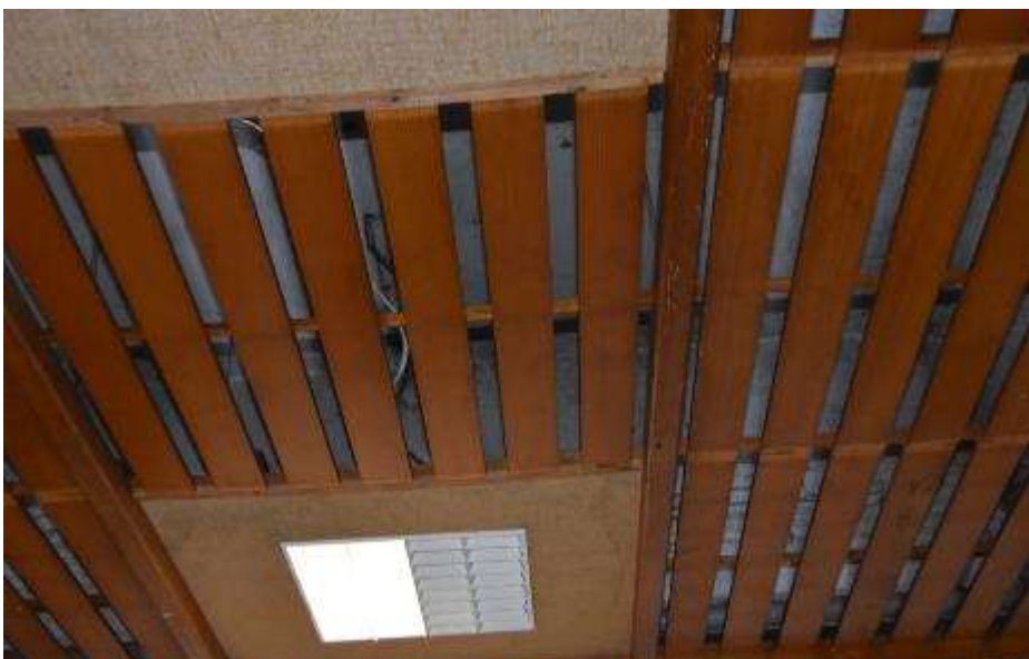
Fot. 172. Fragment stropu nad parterem: w pomieszczeniu nr 8 sufit podwieszony z desek; powyżej strop płytowo żebrowy; monolityczny;
