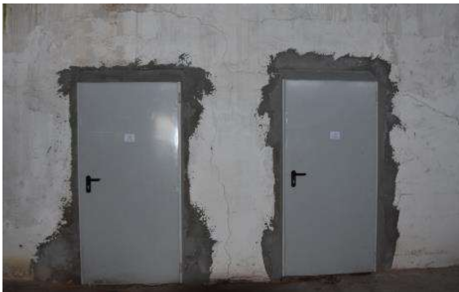
Fot. 64. Fragment ściany zewnętrznej: w rejonie otworów liczne zarysowania;
