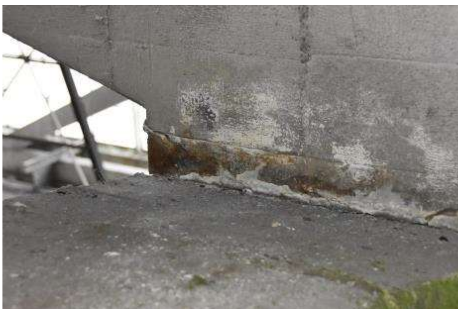
Fot. 211. Fragment dźwigara w osi III-III: połączenie płatwi z pasem górnym spękanе;
