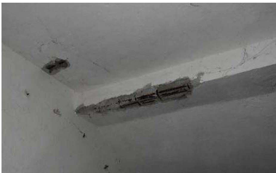
Fot. 189. Fragment biegu schodowego: lokalnie brak otuliny prętów belki spocznika między II i III piętrem; odsłonięte zbrojenie powierzchniowo skorodowane;
