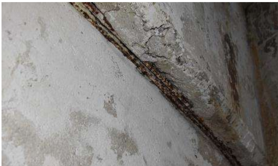
Fot. 76. Fragment ściany zewnętrznej: brak otuliny prętów dolnych belki;
