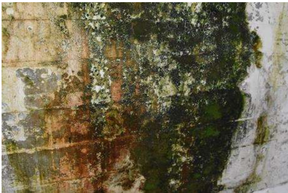
Fot. 74. Fragment ściany zewnętrznej: belka górna pod płytą dachową wysokości 105 cm; silnie zawilgocona; na powierzchni narośle glonów i grzybów;
