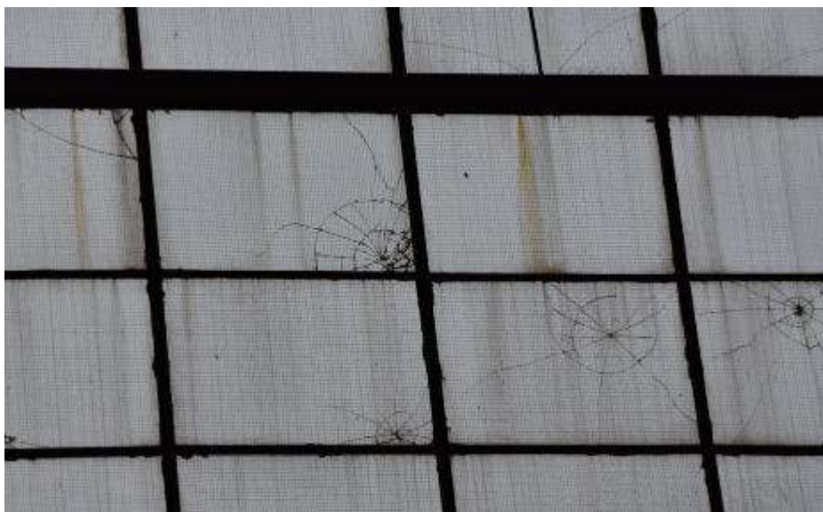
Fot. 4. Fragment ściany zewnętrznej: za kratownicą elewacja szklana; pola wypełnione szkłem zbrojonym;
