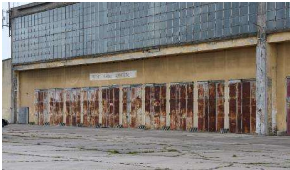
Fot. 385: Fragment elewacji południowej: w dolnej części pierwotnie wrota hangaru; obecnie ściana murowa i tynkowana; w ścianie otwory bramne wyposażone w stalowe bramy garażowe;
