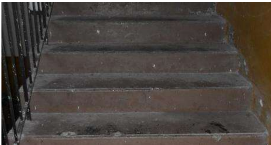
Fot. 190. Fragment biegu schodowego: lokalnie uszkodzenia mechaniczne;
