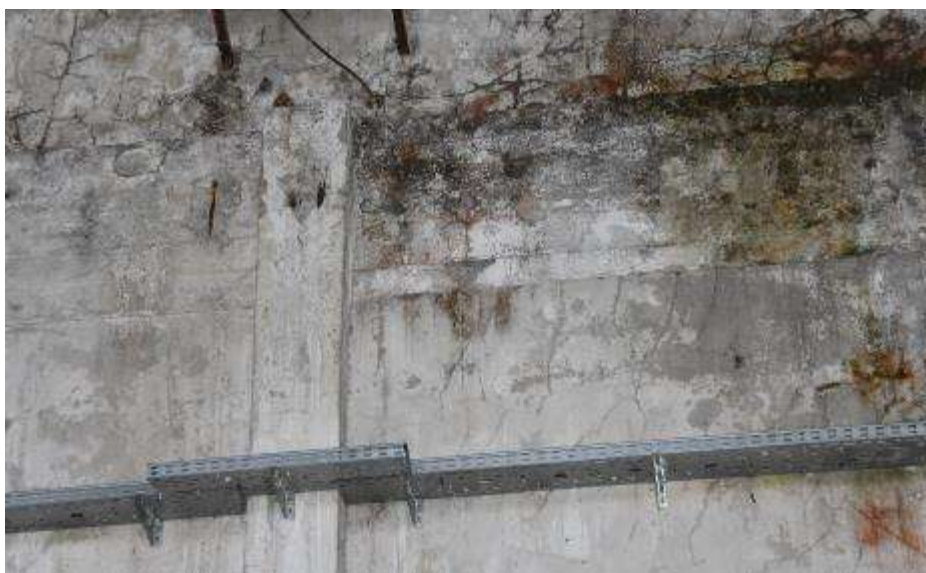
Fot. 69. Fragment ściany zewnętrznej: rozległe zacieki w rejonie pilastra środkowego; silna korozja tynku; na powierzchni rozwój grzybów pleśniowych;
