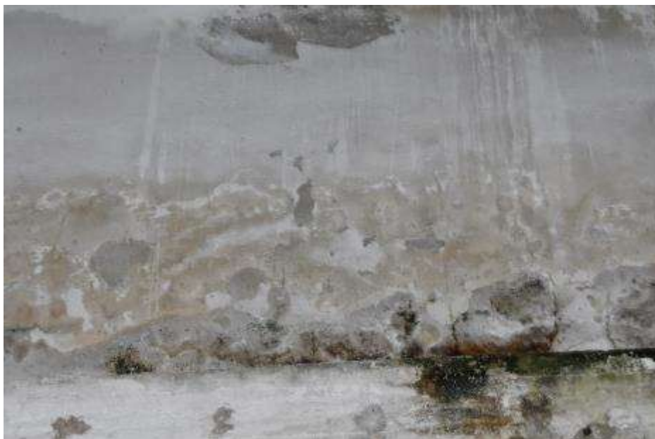
Fot. 58. Fragment ściany zewnętrznej: wypełnienie powyżej belki silnie zawilgocone;
