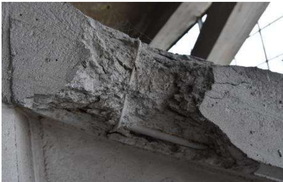
Fot. 212. Fragment dźwigara w osi III-III: przy wieszaku w osi pierwszej od południa uszkodzenie pasa górnego łuku; ubytek otuliny prętów odsłonięcie zbrojenie główne o średnicy \varnothing 20 mm; strzemiona \varnothing 10 mm;
