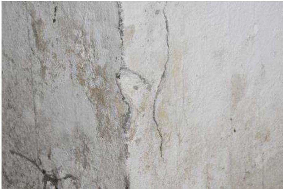
Fot. 49. Fragment ściany zewnętrznej: w dolnej części słupa w osi II odspojona otulina;
