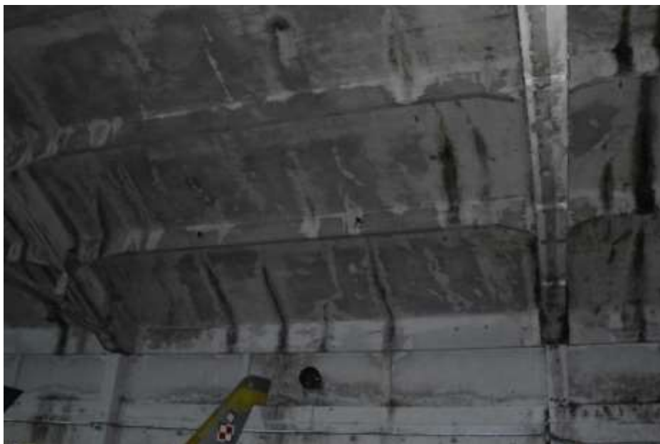
Fot. 231. Fragment płyty dachowej: zacieki od strony północnej; lokalnie na powierzchni płyty rozwój kolonii glonów;
