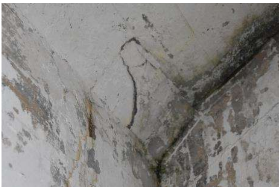
Fot. 227. Fragment płyty dachowej: spękania na powierzchni; nieszczelności; lokalnie odspojenia fragmentów płyty;
