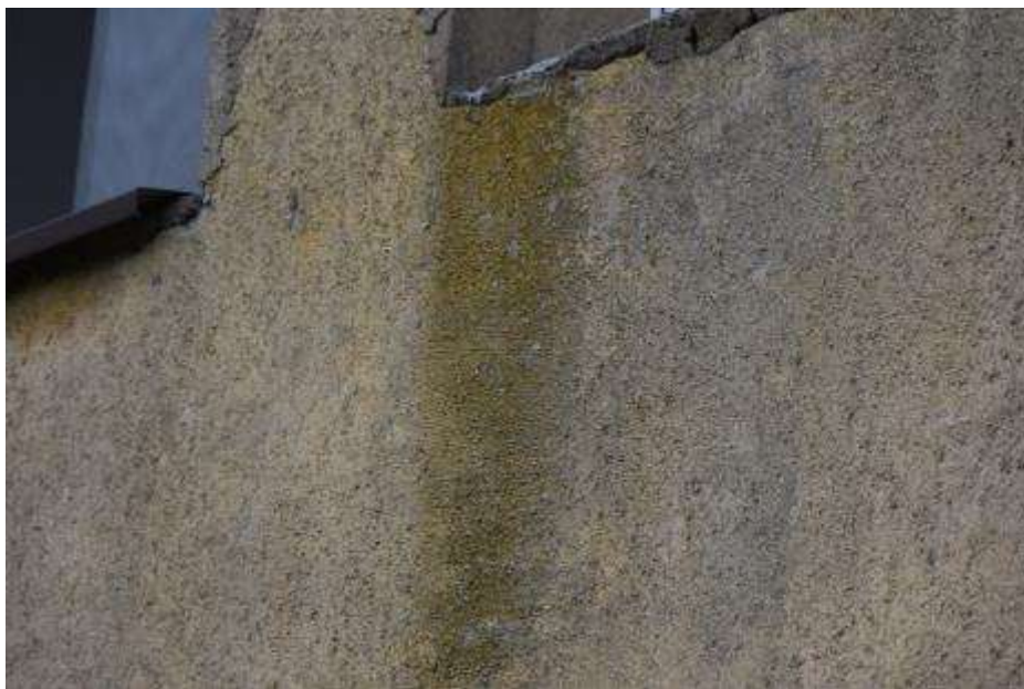
Fot. 287: Fragment elewacji zachodniej: na powierzchni tynku zacieki;
