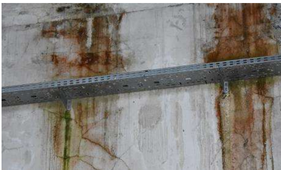
Fot. 67. Fragment ściany zewnętrznej: zacieki nad otworem drzwiowym od strony słupa IV; tynk skorodowany; odspojony od podłoża; na powierzchni wegetacja kolonii glonów;
