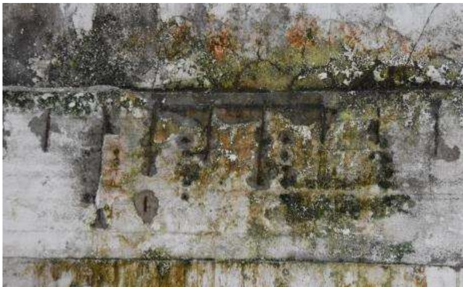
Fot. 70. Fragment ściany zewnętrznej: odspojona otulina prętów belki żelbetowej przy osi V-V; odsłonięte strzemiona i pręt zbrojenia górnego;
