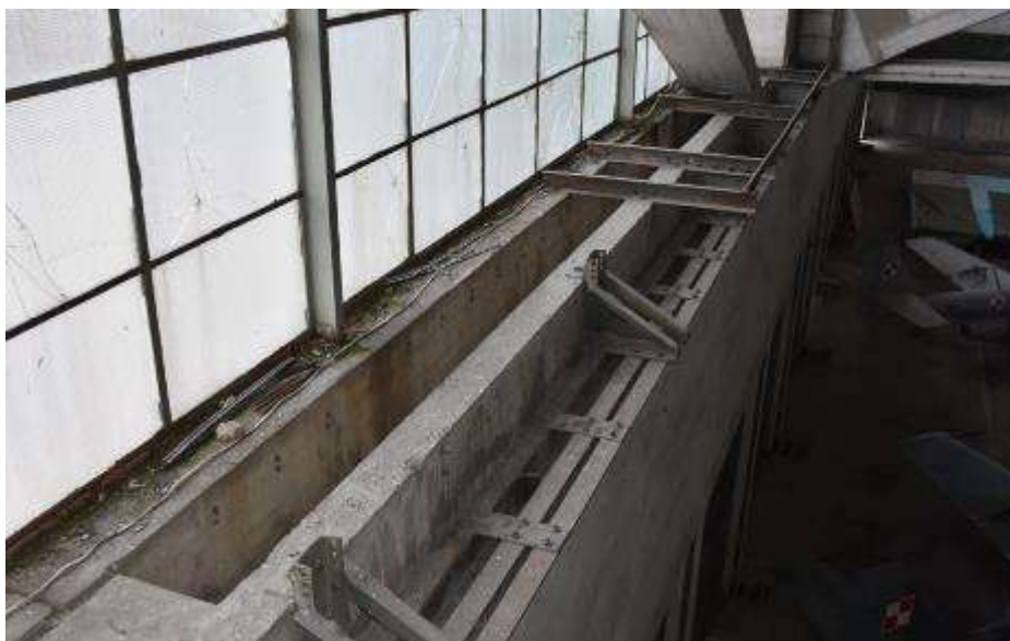
Fot. 10. Fragment ściany zewnętrznej: belka dolna kratownicy o profilu U-kształtnym; od strony hangaru do belki mocowana konstrukcja stalowa pod pierwotne wrota hangaru;
