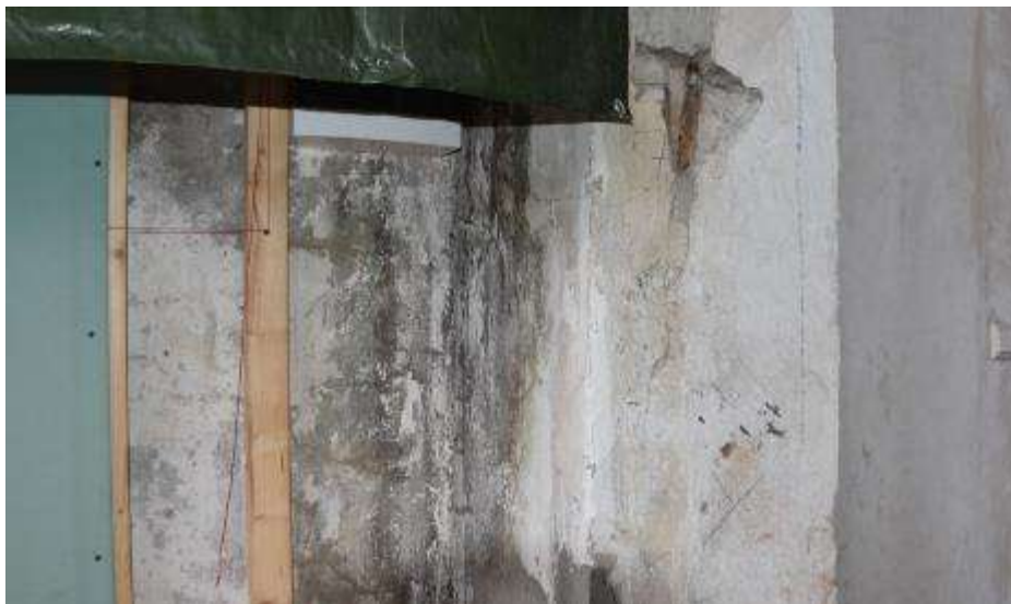
Fot. 25. Fragment ściany zewnętrznej: wyprawy tynkarskie skorodowane; liczne ślady po zaciekach;
