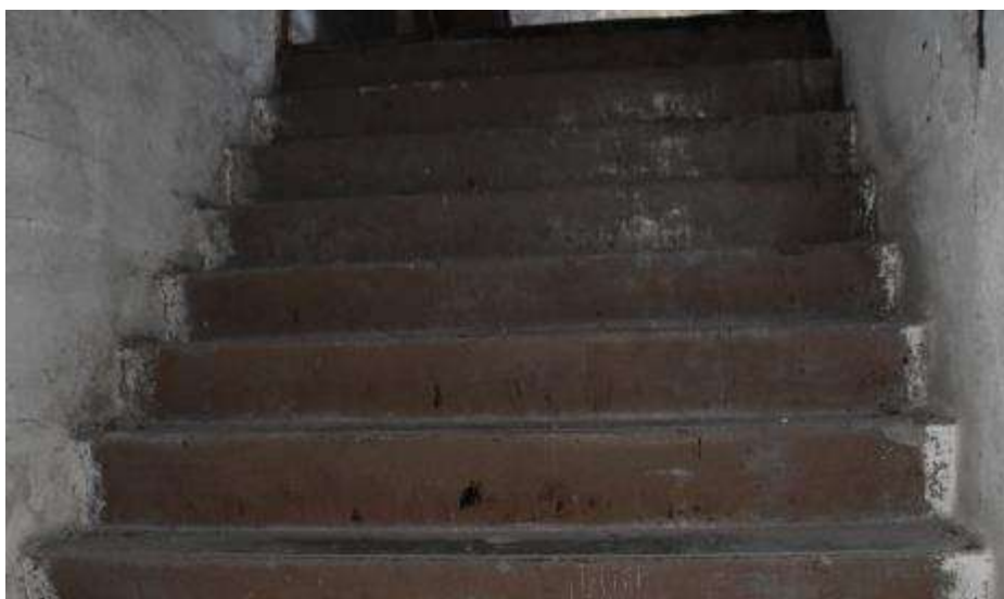
Fot. 191. Fragment biegu schodowego: schody żelbetowe; stopnie betonowe; malowane;
