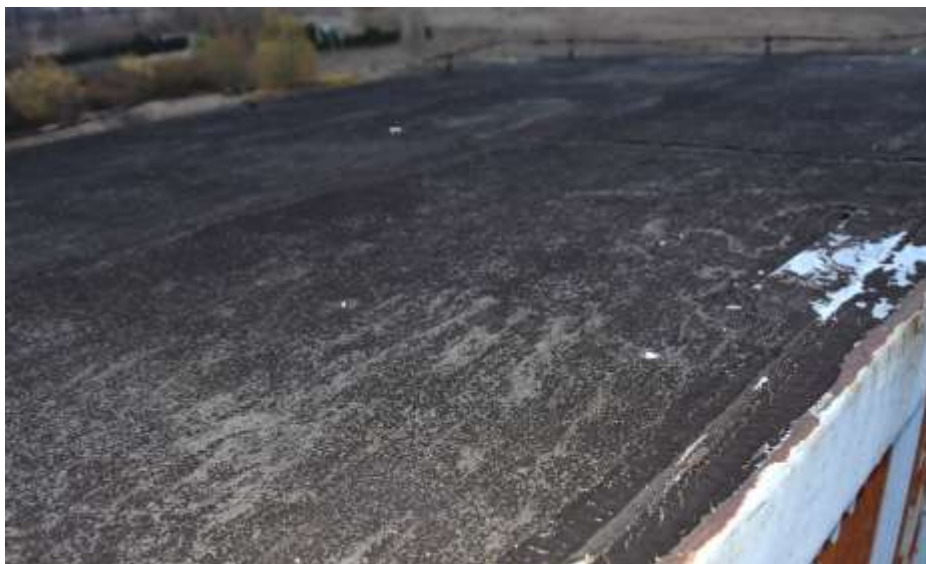
Fot. 257. Fragment dachu nad IV piętrem: na stropodachu nad IV piętrem pokrycie z papy; papa skorodowana; powierzchnia nierówna;
